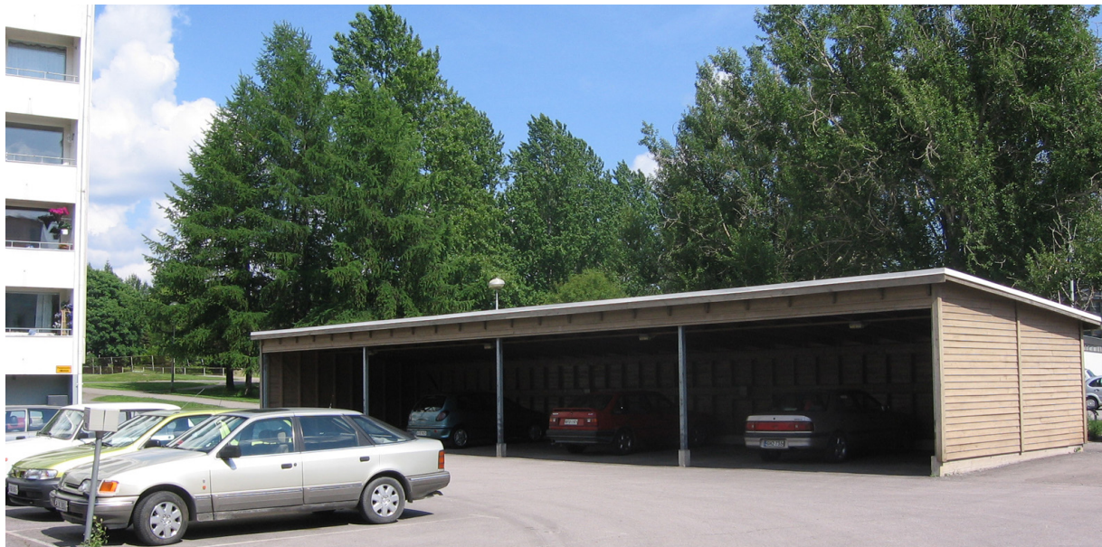
Kuva 44. Taloyhtiöiden pihoissa pysäköidään sekä autokatoksissa että avoimilla parkkialueilla.
