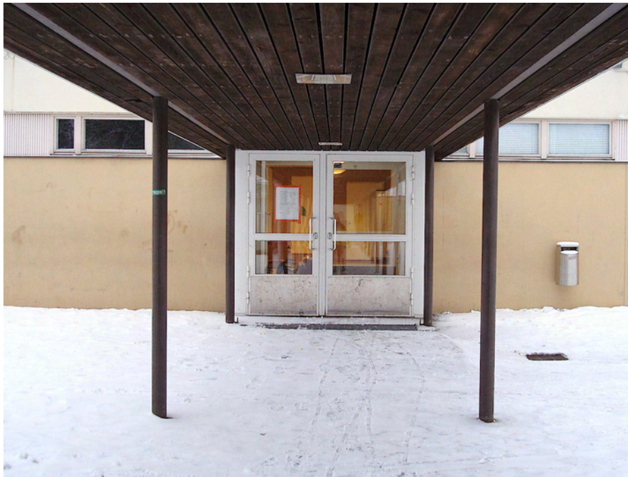
Kuva 8. Pääsisäänkäynti. Pihakouluun johtava katos ja uusitut ulko-ovet.
