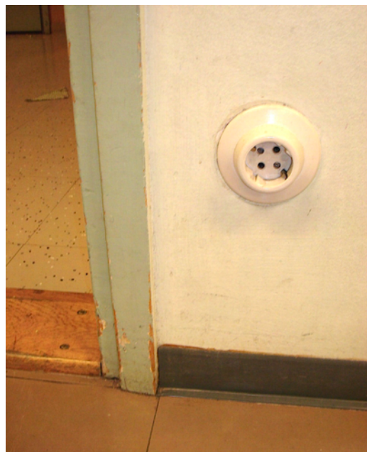
Kuva 38. Alkuperäinen kynnyks, ovi- ja lattialistat, vanhaa Hovi-laattaa ja pistorasia.
