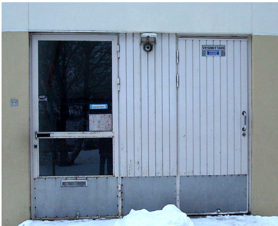
Kuva 13. Alkuperäiset ulko-ovet vahtimestarin asunnon portaaseen ja tekniseen tilaan.
