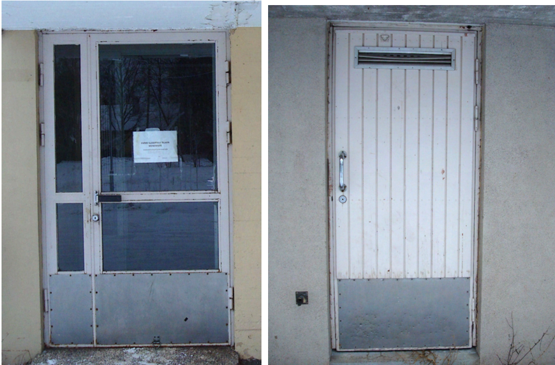
Kuva 11. Alkuperäinen sivuosallinen teräsulko-ovi.
