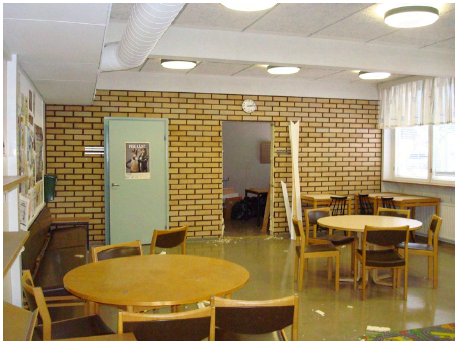
Kuva 29. Neuvolan odotusaula. Tilassa on alkuperäiset pinnat ja rakennusosat sekä alkuperäiset irtokalusteet ja valaisimet.
