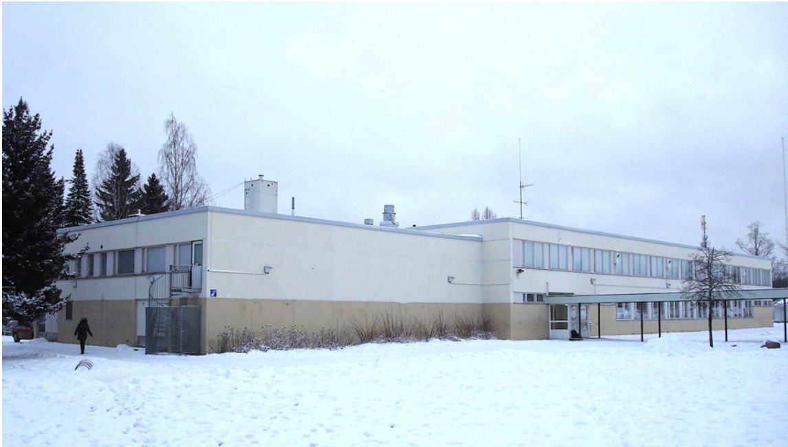
Kuva 4. Rakennuksen pohjoispääty ja julkisivu länteen. Koulun pääsisäänkäynti ja pihakouluun johtava katos. Vahtimestarin asunnon muutoksen yhteydessä päättyyn rakennettu teräsrakenteinen poistumistieporras opetustilasta.
