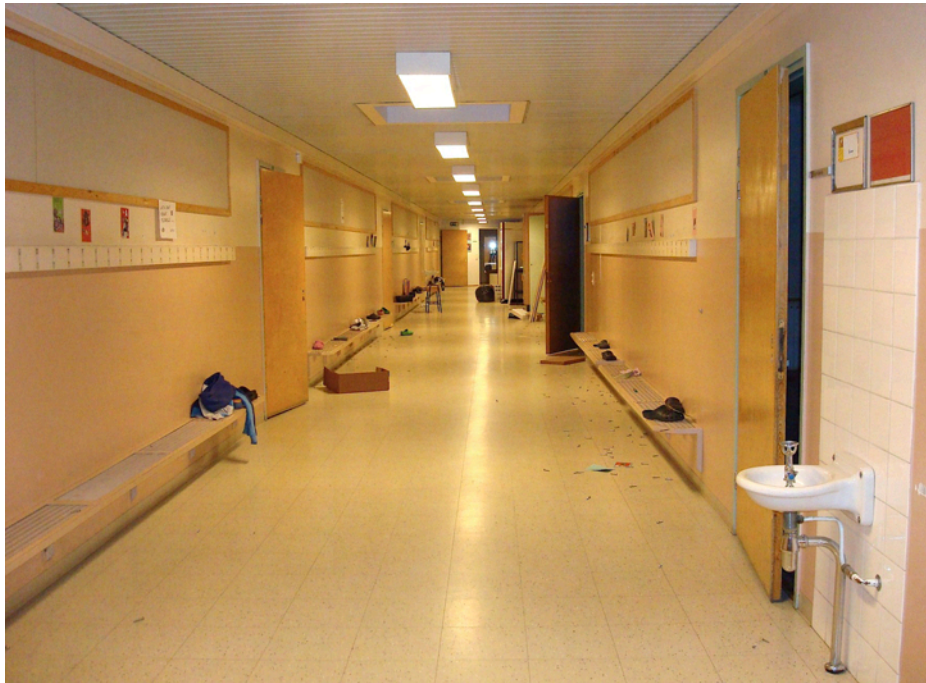
Kuva 22. Pääkäytävä 2.kerroksessa. Valaisimien välissä on kattoikkunat.
