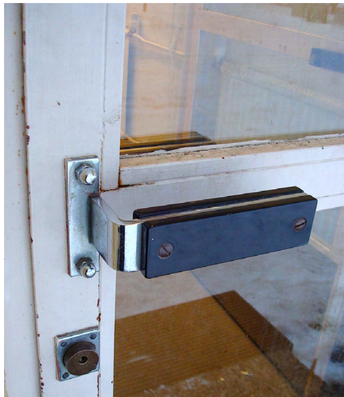
Kuva 10. Vanhojen ovien lukot ja vetimet ovat alkuperäisiä.
