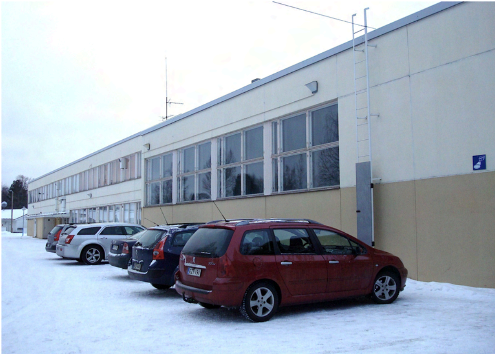
Kuva 7. Itäjulkisivua koillisen suunnasta, etualalla voimistelusalin ikkunaryhmä.
