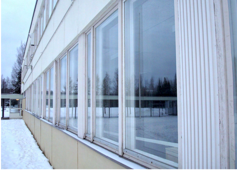
Kuva 14. Alkuperäistä ikkunanauhaa ikkunaväleissä metalliprofiililevyverhous.
