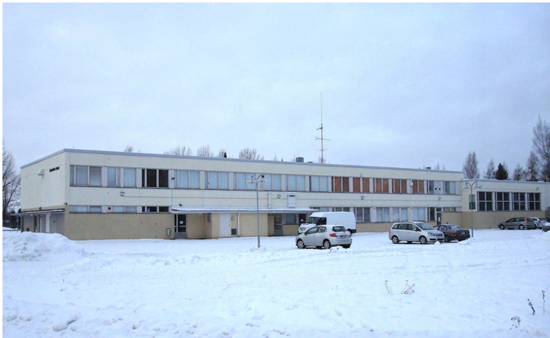
Kuva 6. Rakennuksen itäjulkisivu Juvelankadun ja Sarvannankadun risteyksestä. Katoksen alla laajennus, jossa on kettiön laatikkovarsto ja tekninen tila.
