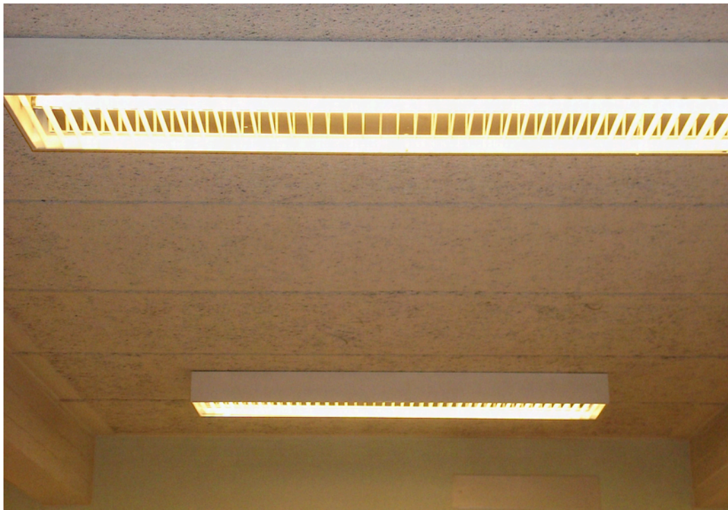
Kuva 32. Tyypillinen opetustilan katto. Palkkiväleissä Toja-levyvaimennus ja valaisimet.
