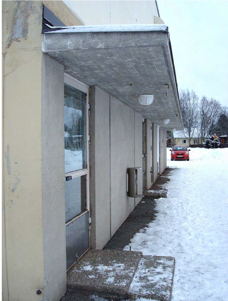
Kuva 16. Alkuperäinen teräsbetonikatos eteläpäädyssä.
