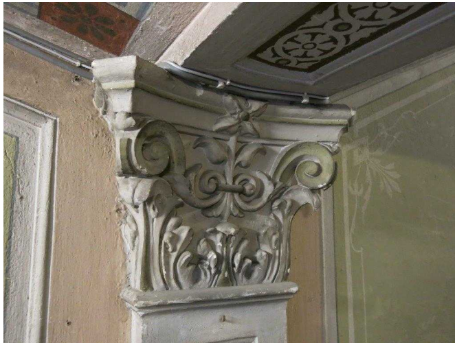
Pilasterien päitä koristavat kompositakapiteelit, joiden yksityiskohtia on korostettu vihreällä ja kullanhohtoisella maalilla. RT
