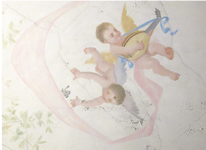
Porrashuoneen katossa on leikkiteleviä puttolapsia; toinen tavoittelee perhosta, toinen soittaa luuttua. Luutunsoittajan kaksoisolento löytyy helsinkiläisen Satamakatu 2:n porrashuoneen katosta (ks. edempänä sivu 46). MH
