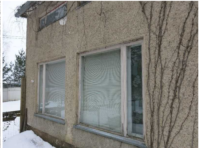
KYY 150 : 4 Sahalan tila asuinrakennuksen 001 eteläsivua Miia Hinnerichsen 21.01.2015
