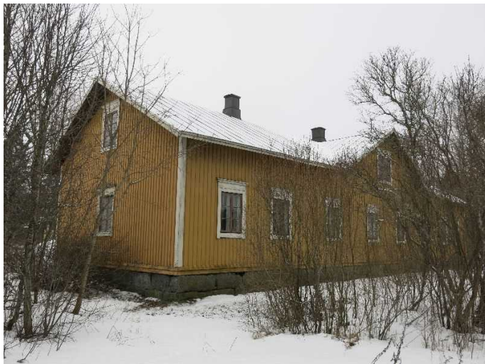
KYY 150 : 25 Kangasniemen tilakeskuksen päärakennus (rakennus 002) kaakosta Miia Hinnerichsen 21.01.2015
