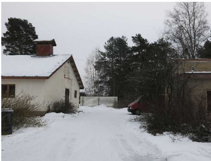
KYY 150 : 1 Sahalan tila pihaa ja rakennuksia pohjoisesta Milla Hinnerichsen 21.01.2015
