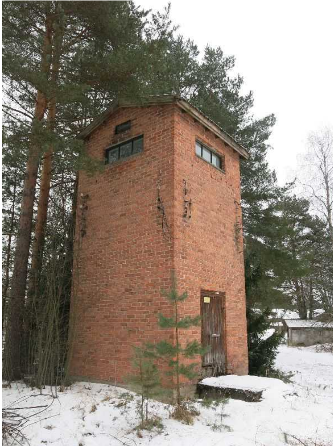
KYY 150 : 54 Kangasniemen tilalla sijaitseva käytöstä poistettu tornimuuntamo (rakennus 015) kaakosta Mjia Hinnerichsen 21.01.2015
