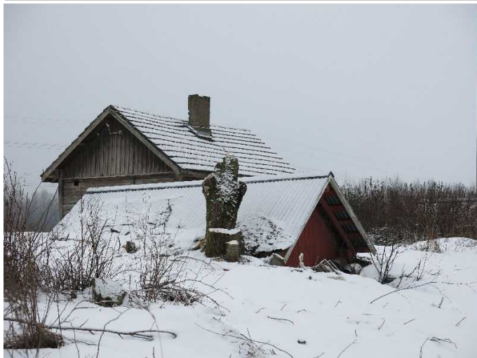
Kangasniemen tilakeskuksen maakellari (rakennus 009)
