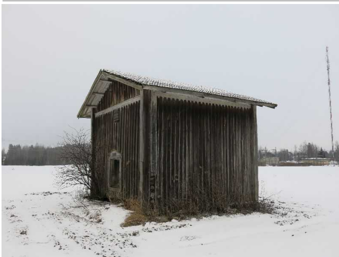
Kangasniemen tilakeskuksen vilja-aitta (rakennus 005) luoteesta.
