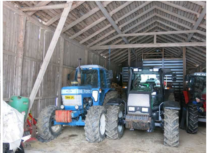
KYY 150 : 51 Kangasniemen tilakeskuksen kuivuri ja konehalli (rakennus 013) lounaissiiven sisätillaa Miiia Hinnerichsen 21.01.2015
