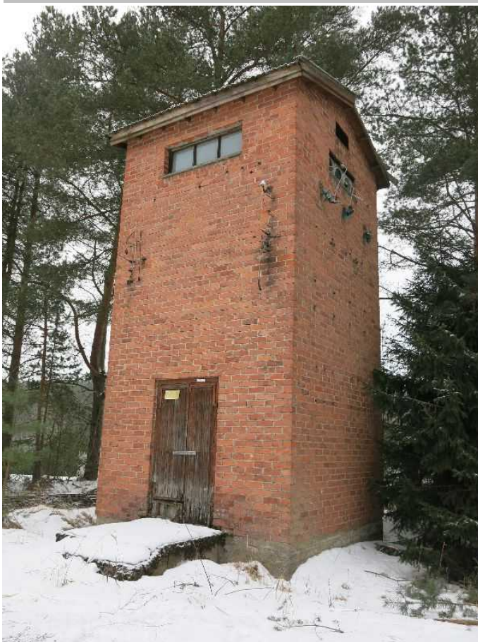
Kangasniemen tilalla sijaitseva käytöstä poistettu tornimuuntamo (rakennus 015) kaakosta.
