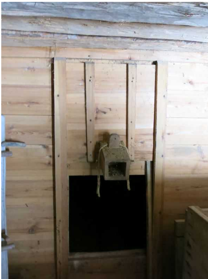
KYY 150 : 36 Kangasniemen tilakeskuksen vilja-aitta (rakennus 005) myöhemmin rakennetut viljalaarit Miia Hinnerichsen 21.01.2015
