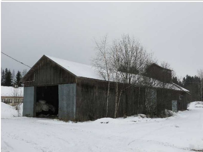
Kangasniemen tilakeskuksen kuivuri ja konehalli (rakennus 013) etelästä. Mjia Hinnerichsen 21.01.2015 00:00:00
