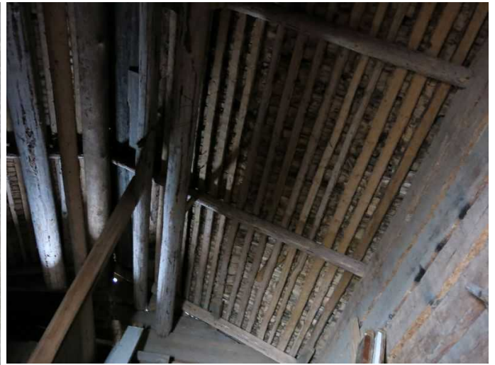
KYY 150 : 35 Kangasniemen tilakeskuksen vilja-aitta (rakennus 005) kattorakenteita ja nokijäljet hirren välissä pidetyistä päleistä Miia Hinnerichsen 21.01.2015
