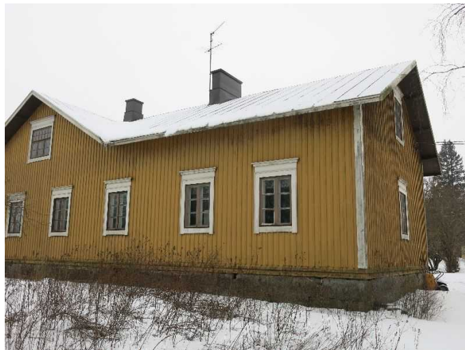
KYY 150 : 26 Kangasniemen tilakeskuksen päärakennus (rakennus 002) koillisesta Miia Hinnerichsen 21.01.2015
