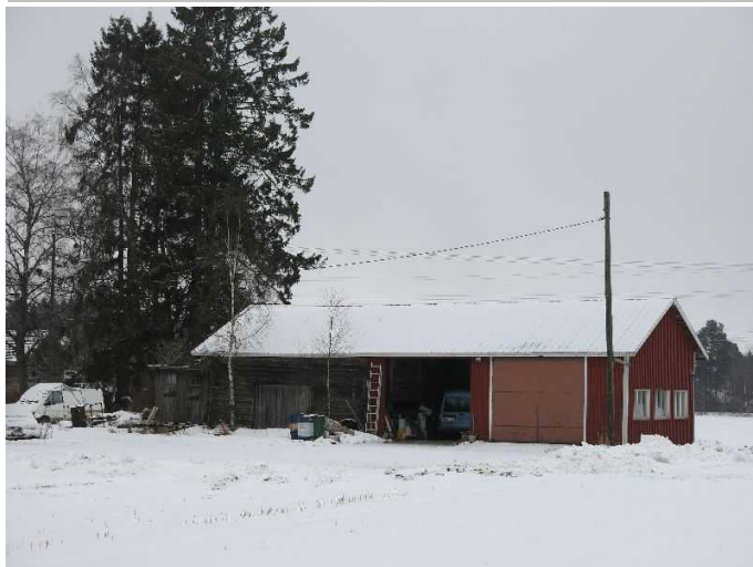
Kangasniemen tilakeskuksen talli ja konevaja (rakennus 006) lounaasta.
