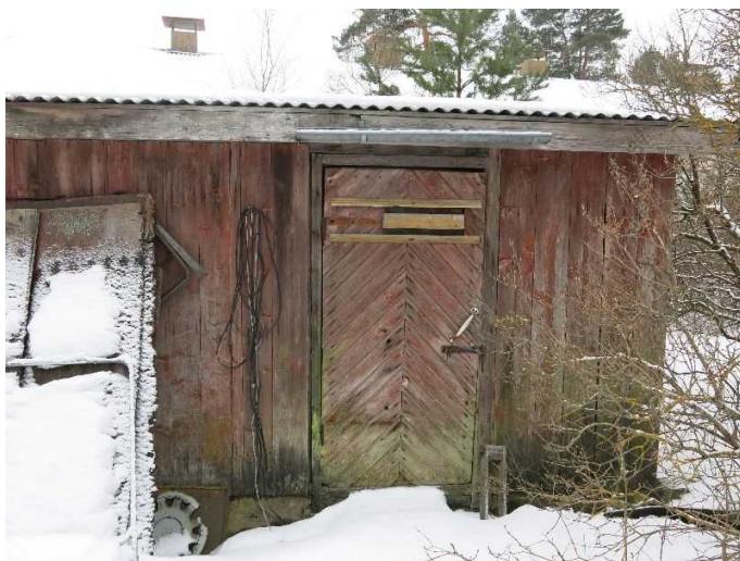
KYY 150 : 14 Sahalan tila piharakennus (rakennus 004) pohjoisesta Mii Hinnerichsen 21.01.2015
