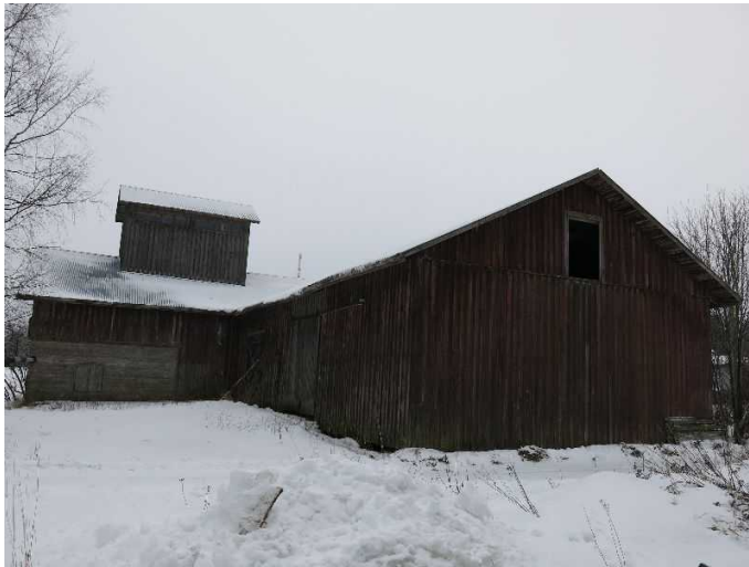
KYY 150 : 50 Kangasniemen tilakeskuksen kuivuri ja konehalli (rakennus 013) pohjoisesta Miiia Hinnerichsen 21.01.2015
