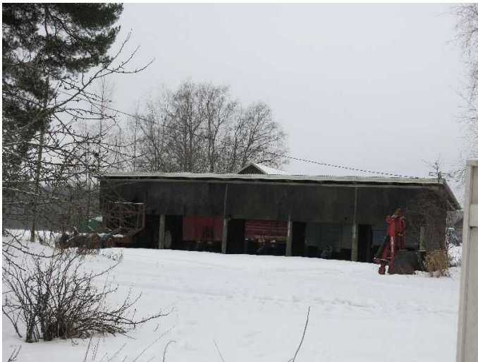
Kangasniemen tilakeskuksen perävaunukatos (rakennus 012) luoteesta.
