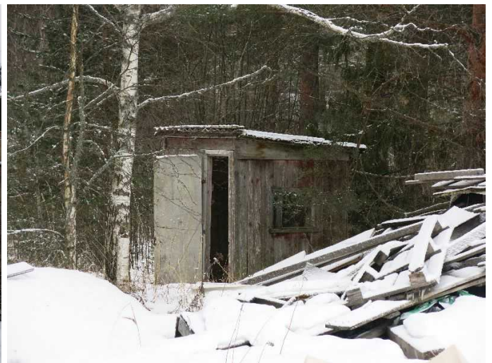
KYY 150 : 15 Sahalan tilalla sijaitseva muualta siirretty entinen VR:n työntekijöiden taukotupa (rakennus 005) lounaasta Milla Hinnerichsen 21.01.2015
