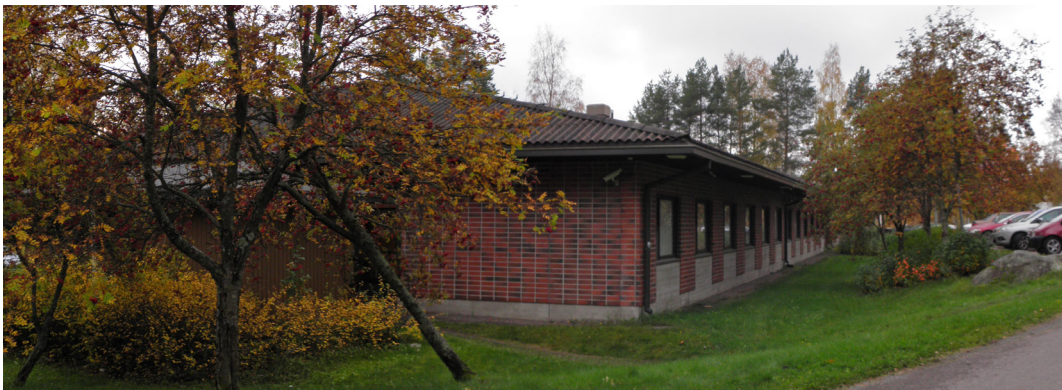
Terveysasema, näkymä pohjoiseen, pihlajien takana näkyy pyöräkatos koillisjulkisivulla
