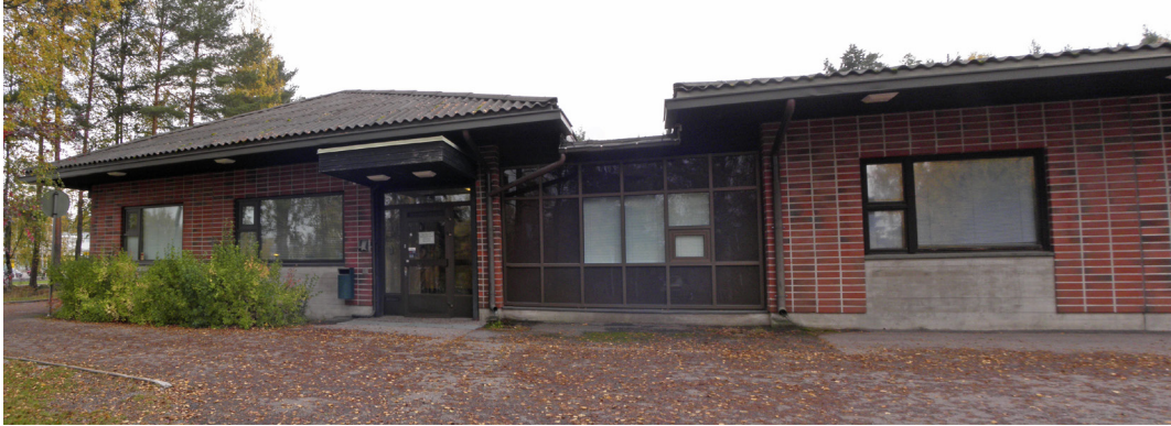
Terveysasema, julkisivu kaakkoon
