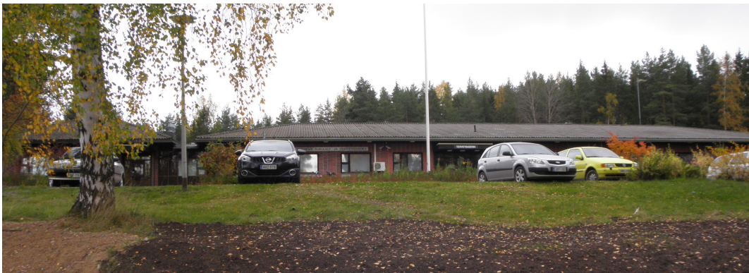
Terveysasema, julkisivu kaakkoon
