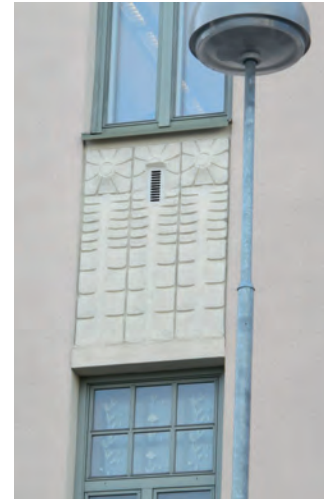
Pääjulkisivu ja sen jugendkoristeet ovat säilyneet.
