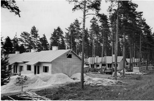
Kalevanrinteen pikatalot rakenteilla vuonna 1947. KUVA E. M. Staf / Vapriikin kuva-arkisto.
