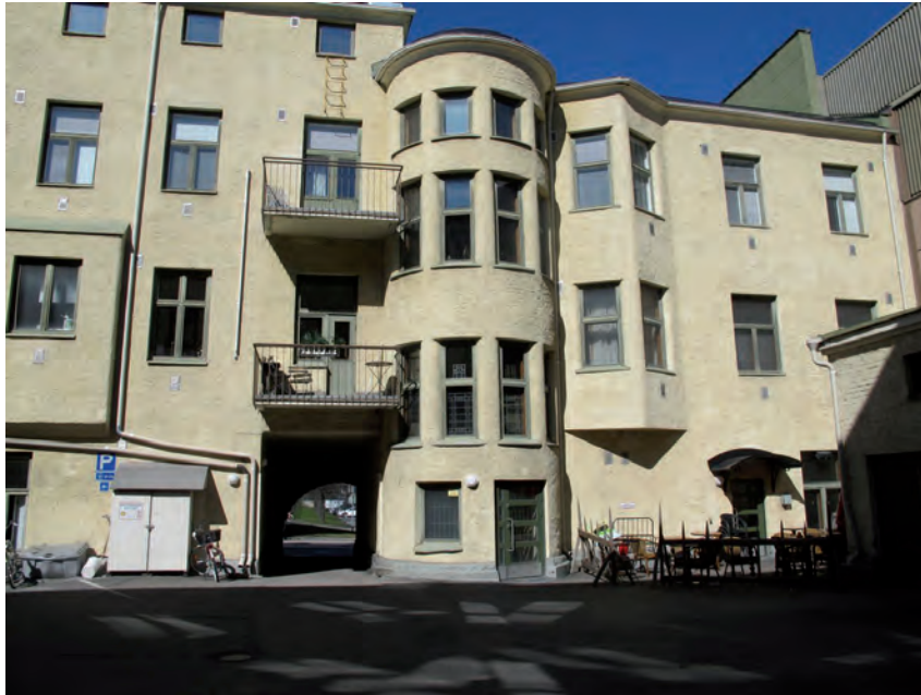
Ravintolan/päärakennuksen takajulkisivu, jossa on pyöreä porrashuone ravintolakerrokseen.
