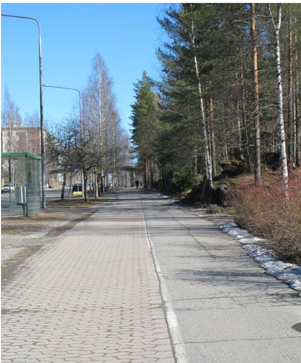
Kuva: Opiskelijankadulla erotettu jalkakäytävä-pyörätie kulkee kadun eteläreunassa erotettuna ajoradasta leveällä nurmikais-taleella, jota rytmittää puurivi (puulajina tyypillisimmin koivu). Kävelytien puoli on alkuperäisessä asussaan, pintanaan tiililadottu betonikiveys.
