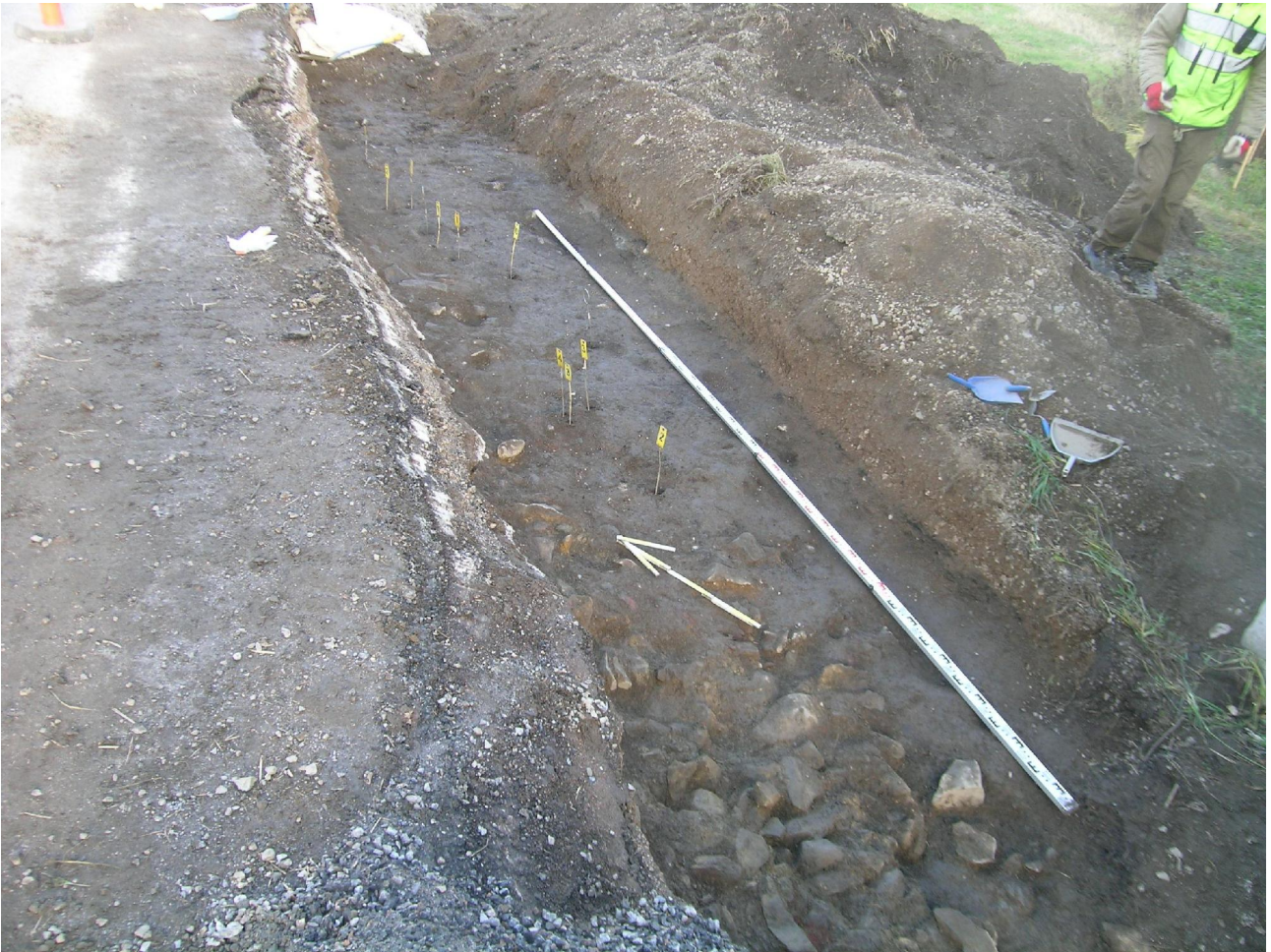
Kuva 18. G-v-alueen lounaisosa (alue G-v2). Etualalla rakenteenomainen kivikeskittymä G-KR2 ja erillinen kivikeskittymä G-KR4 sen koillispuolella luoteisprofiilin edessä. Taustalla G-v-alueen koillisosa on jo peitetty suodatinkankaalla ja murskeella. Keltaiset metallipuikot osoittavat G-PR3-seipäänjäännösten sijainteja. Latta levitetty 5 metrin pituuteen. Kuvassa mukana pohjoisnuoli. Kuvaussuunta koilliseen. Kuvaaaja: Sami Raninen. KYY 130: 16.
