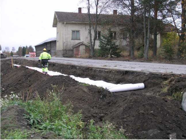
Kuva 4. A–D-v-alueille levitetään suodatinkangasta. Tien toisella puolella Sapalan koillinen päärakennus ja Sapalan vanhaa pihaa, jota istutetut puut reunustavat. Kuvaussuunta itäkoilliseen. Kuvaaja: Sami Raninen. KYY 130: 38.
