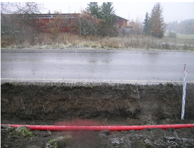
Kuva 12. Maakaapelilinjaa Anian rantatien luoteispuolella. Tiepenkereen profiilissa näkyy penkereen rakenne- tai täyttökerroksia ja niiden alla tummanharmaata savimultaa. Tien toisella puolella näkyy Sapalan tilakeskuksen eteläosan rakennuksia. Vastapäiselle alueelle tien toisella puolella avattiin myöhemmin valvonnan I-alue. Kuvaussuunta kaakkoon. Kuvaaja: Sami Raninen. KYY 130: 41.
