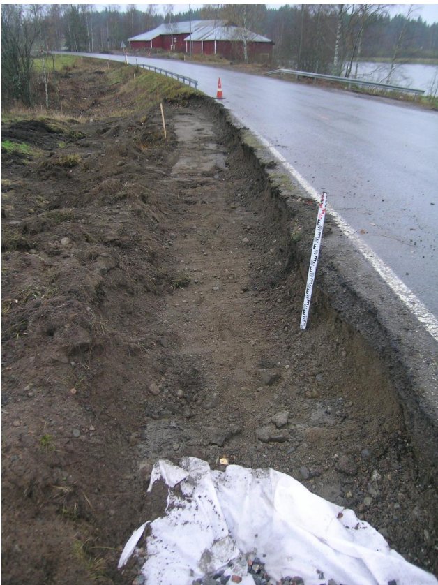
Kuva 33. Kaivantoa Anian rantatien kaakkoispuolisessa pengerluiskassa Juoksianojan sillan koillispuolella. Esille on tullut vain resenttiä täyttömaata. Taustalla Kierikan riihi(?) Kotalahden rantakalliorinteessä. Kuvaussuunta etelään. Kuvaaja: Sami Raninen. KY 130: 81.
