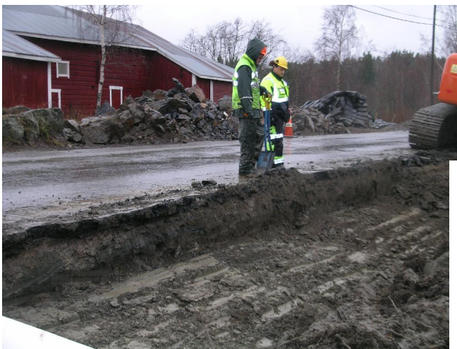
Kuva 35. Anian rantatien itäiseen pengerluiskaan avattua kaivantoa Juoksianojan eteläpuolella. Taustalla vanha ulkorakennus (Kierikan riipi?), jonka edustalla sijainnut kalliopaljastuma on räjäytetty. Ulkorakennuksen takana sijaitsee Pyhäjärven Kotolahti. Taustalla häämöttää Kotolahden pohjoisrannan rantametsikköä. Kuvaussuunta luoteeseen. Kuvaaja: Sami Raninen. KYY 130: 87.
