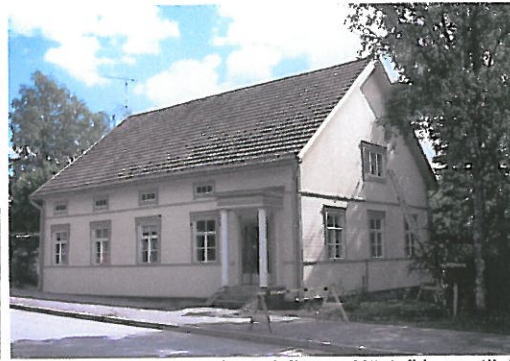
Kuva 14. Ja kunnostuksen jälkeen. Näyteikkuna tilalle puusepällä teetetty kuusiruutuinen ikkuna näyttää alkuperäiseltä.
