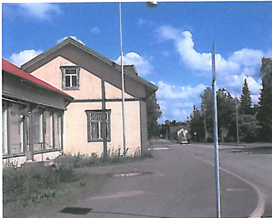
Kuva 15. Murulan päärakennukseen rakennettiin 1950-luvulla lisäsiipi, joka vaikutti merkittävästi rakennuksen tyyliin.
