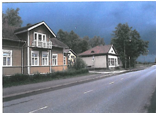
Kuva 19. Ylängön päärakennus ja takana Maantuotteen entinen liikerakennus.
