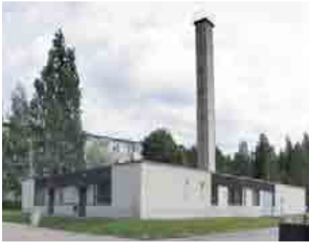
Kortteli 5956 Tontti 6 Rakennus 1 Kuva: P20 Osoite: Peltolamminkatu 36
