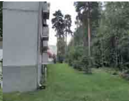
Kortteli 5953 Tontti 6 Rakennus 2 Kuva: 220 Osoite: Säestäjänkatu 13
