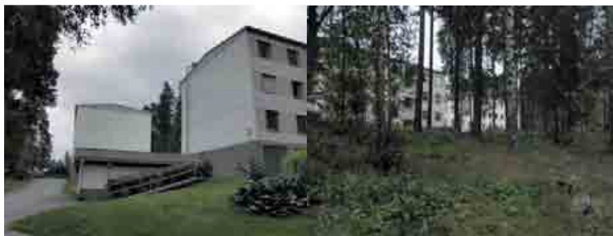
Kortteli 5953 Tontti 4 Rakennukset 1, 3, 2 Kuva: 204 Osoite: Säätäjänkatu 7, 9
