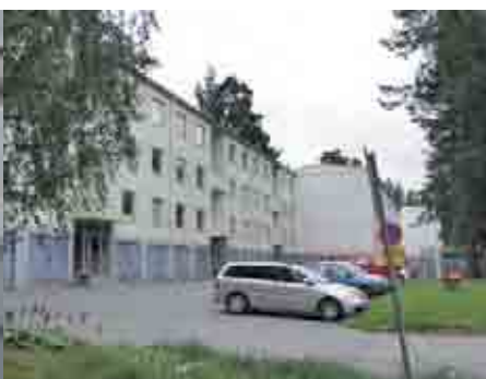
Kortteli 5953 Tontti 7 Rakennus 1 Kuva: 208 Osoite: Säestäjänkatu 11
