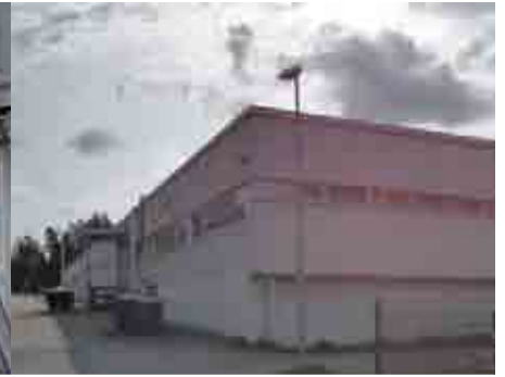
Kortteli 5955 Tontti 1 Rakennus 1 (oik.) Kuva: 353 Osoite: Peltolamminkatu 10
