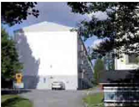
Kortteli 5957 Tontti 5 Rakennukset 2, 3, 1 Kuva: 118 Osoite: Pähkinämäenkatu 2, 4
