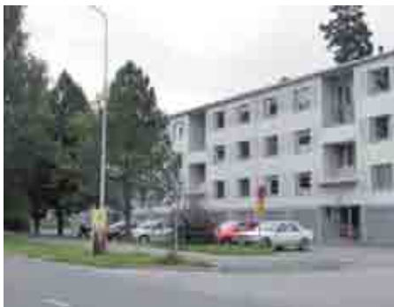
Kortteli 5954 Tontti 4 Rakennus 1 Kuva: 183 Osoite: Säästäjänkatu 1
