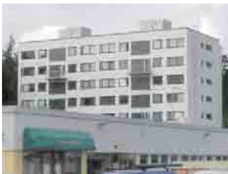
Kortteli 5955 Tontti 3 Rakennus 1 takana Kuva: 363 Osoite: Peltolamminkatu 14
