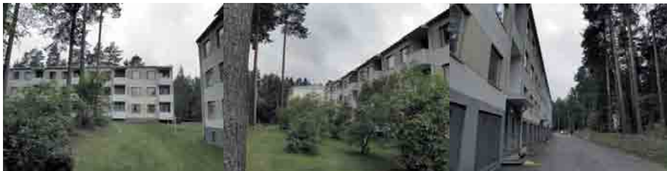
Kortteli 5953 Tontti 4 Rakennukset 2, 1 Kuva: 197 Osoite: Säätäjänkatu 9, 7
