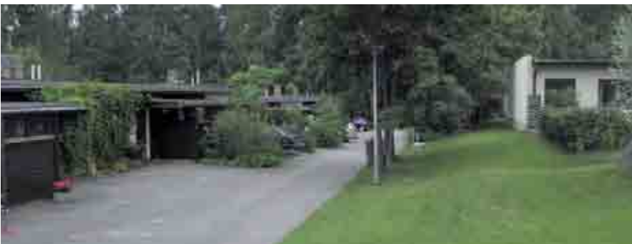
Kortteli 5961 Tontti 3 Rakennukset 4, 3 Kuva: 174 Osoite: Säätäjänkatu 2
