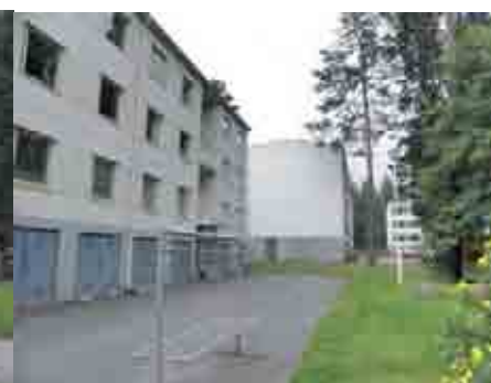
Kortteli 5953 Tontti 7 Rakennus 1, 1 (T6) Kuva: 215 Osoite: Säestäjänkatu 11
