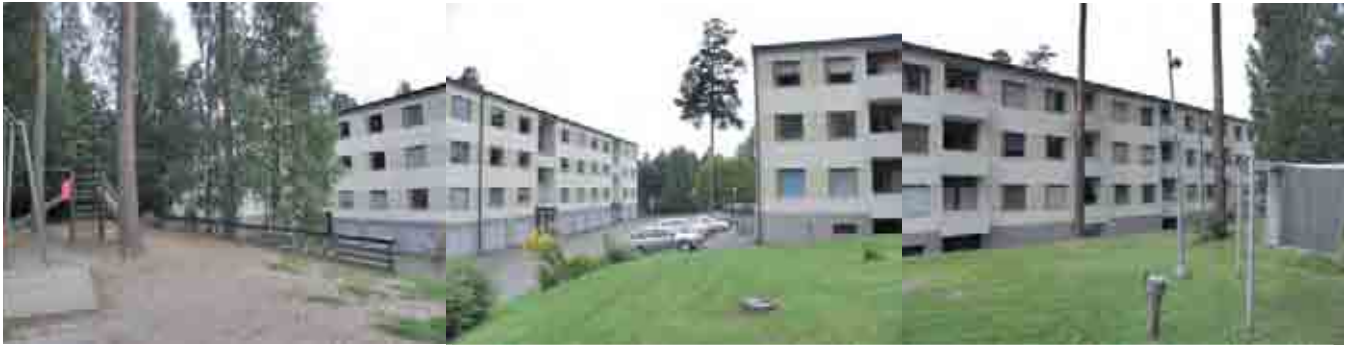
Kortteli 5953 Tontti 5 Rakennus 2 Kuva: 229 Osoite: Säästäjänkatu 19
