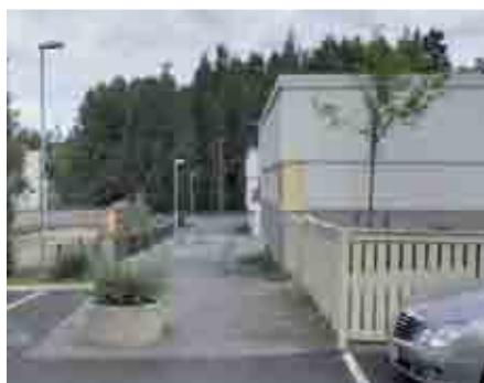
Kortteli 5955 Tontti 2 Rakennus 1 (oik.) Kuva: 364 Osoite: Peltolamminkatu 12
