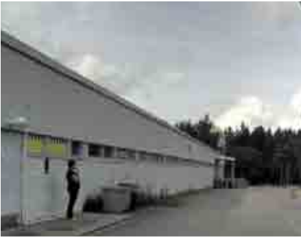
Kortteli 5955 Tontti 1 Rakennus 1 Kuva: P6 Osoite: Peltolamminkatu 10
