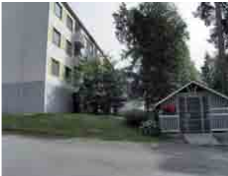
Kortteli 5957 Tontti 5 Rakennukset 1, 3 Kuva: 437 Osoite: Pähkinämäenkatu 2
