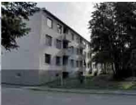
Kortteli 5954 Tontti 4 Rakennus 1 Kuva: 319 Osoite: Säästäjänkatu 1
