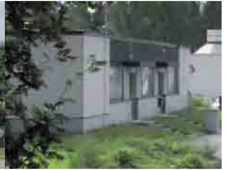
Kortteli 5956 Tontti 6 Rakennus 1 Kuva: P11 Osoite: Peltolamminkatu 36
