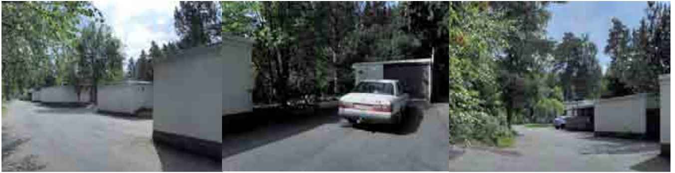
Kortteli 5960 Tontti Rakennukset 9-12 Kuva: 438 Osoite: Pähkinämäenkatu 1
