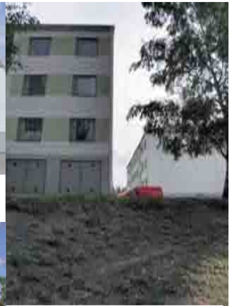
Kortteli 5957 Tontti 5 Rakennukset 2, 1 Kuva: 435 Osoite: Pähkinämäenkatu 2, 4
