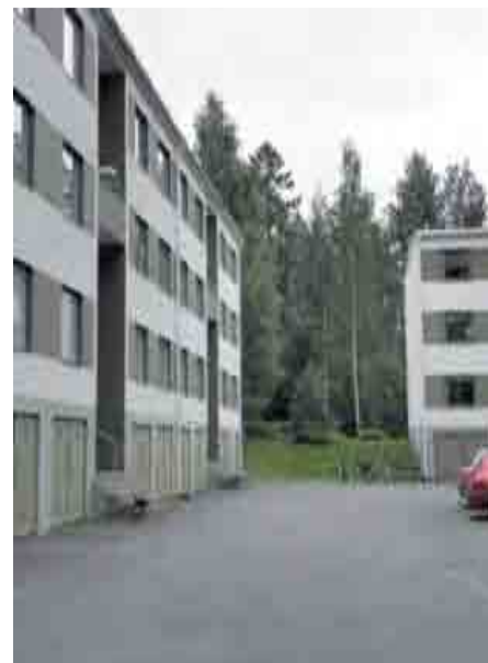
Kortteli 5953 Tontti 6 Rakennus 1, 2 Kuva: 219 Osoite: Säestäjänkatu 13, 15
