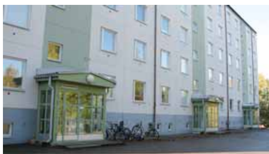
Porrashuoneiden sisäänkäynteihin on tehty laajennuksia.
