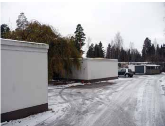
Peltolammin eteläpäässä osoitteessa Pähkinämäenkuja 1 on kytkettyjen pientalojen kortteli, jossa autoallit rajaavat taloille atrium-tyyppiset etupihan.
