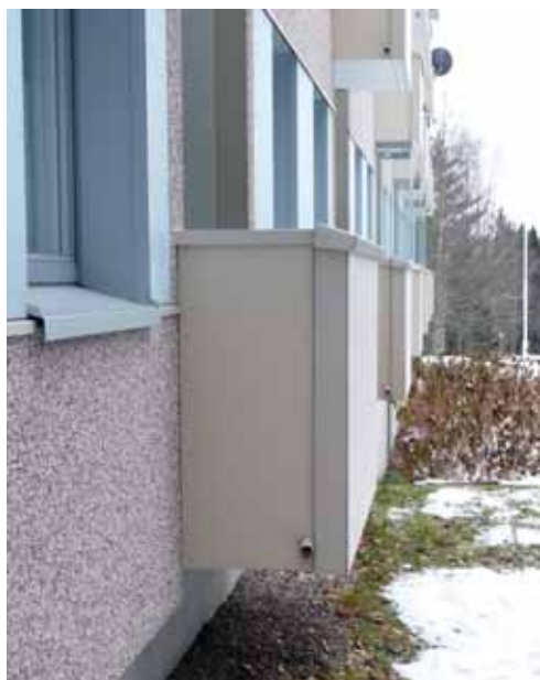
Ylimmässä kuvassa alkuperäinen julkisivu, joka on maalattu. Keskellä ja alla kuvassa lisälämmöneristetty ja levytetty talo.
