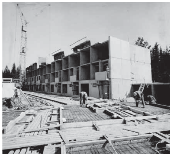
Ristimäen ensimmäisen vaiheen kenttävalimo. (lähde: Aarre Mattisen valokuvakokoelma / Rakennusliike Mattinen & Niemelä Oy)
