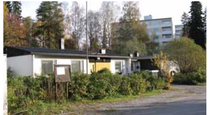
Ruotulan kerrostaloaluetta Tornimäenkadulta ja pientaloaluetta Pokalankadulta. As Oy Ruotulan Tornit muodostaa yhtenäisen kokonaisuuden, jossa myös rakennusten alkuperäinen, taloittain vaihteleva väritys on onnistuttu säilyttämään.
