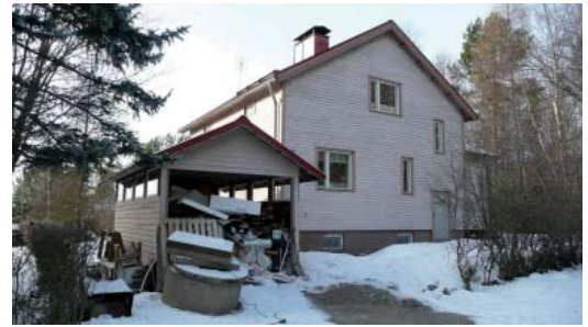
(kuva: Rakennusvalvonnan arkisto)
