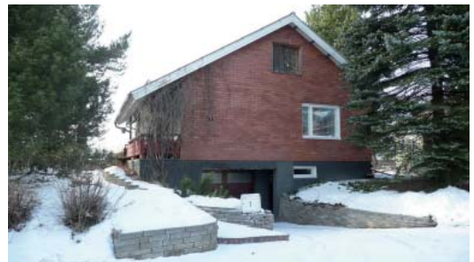
(kuva: Rakennusvalvonnan arkisto)
