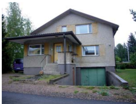
(kuva: Rakennusvalvonnan arkisto)
