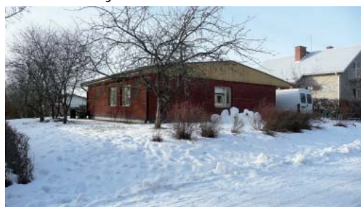
(kuva: Rakennusvalvonnan arkisto)
