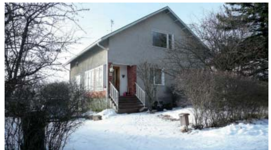
(kuva: Rakennusvalvonnan arkisto)
