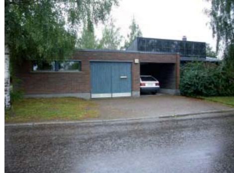
(kuva: Rakennusvalvonnan arkisto)
