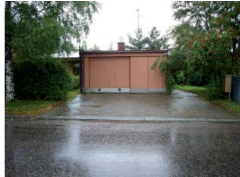
(kuva: Rakennusvalvonnan arkisto)
