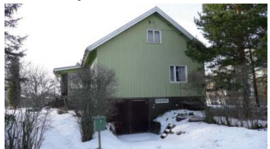
(kuva: Rakennusvalvonnan arkisto)
