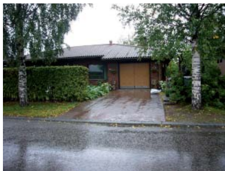
(kuva: Rakennusvalvonnan arkisto)
