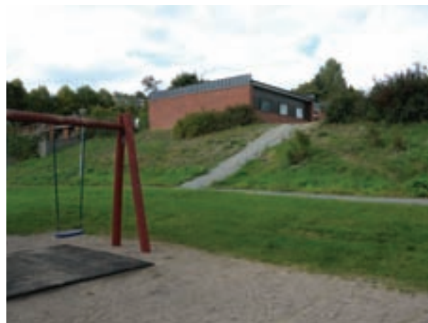
Atriumtaloilta Omenapuistoon johtava polku sijaitsee hankalasti jyrkässä rinteessä.
