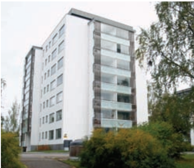
Pistetalojen julkisivuremontti on muuttanut rakennusten ulkoarkkitehtuuria mm. parvekelasitusten osalta. Uudistukset on toteutettu kuitenkin hyvin alkuperäistä ilmettä mukailien.
