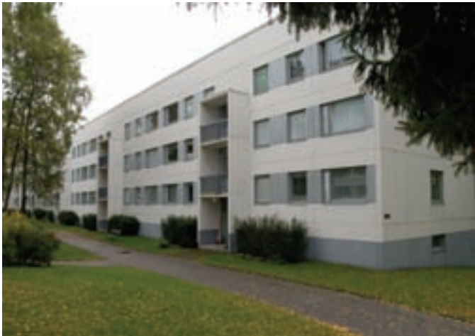
Lamellitalojen vähäeleinen arkkitehtuuri on säilyttänyt ominaispiirteensä vuosikymmenien ajan.
