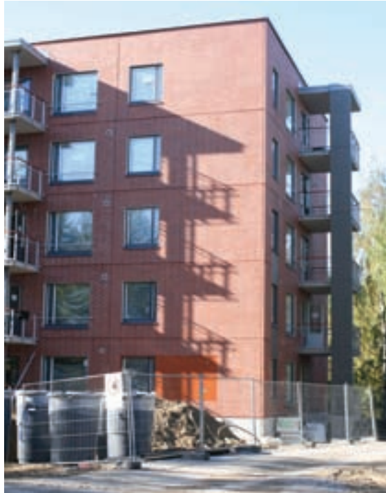
Käynnissä olevaa täydennysrakentamista Linnainmaalla.
