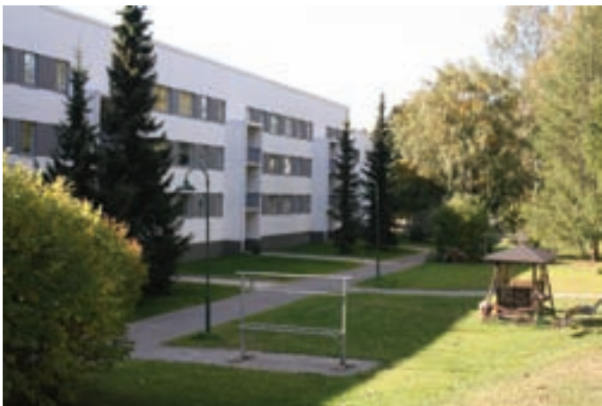
Jälkeenpäin lisätyt pihakalusteet ja valaistus ovat osin ristiriitaisia alkuperäisen yksinkertaisen tyylin kanssa.
