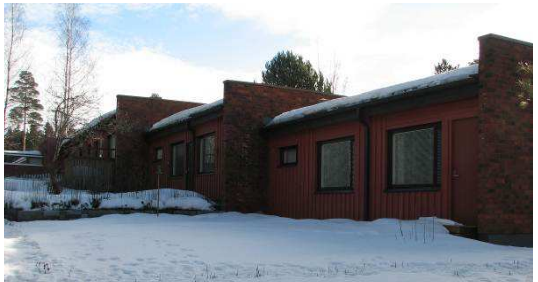
Kuva: Rinteeseen porrastettu rivitalo Havutien varrella, 1976.
