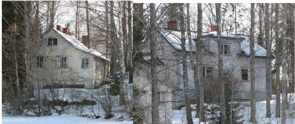
Kuvat: vas. rannan ja oik. ylärinteen huvilarakennus
