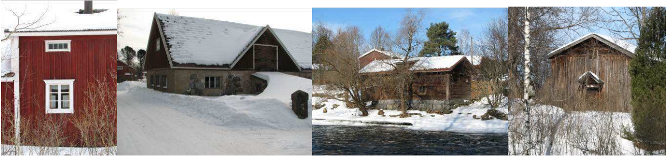
Päärakennuksen julkisivua, rapattu kivinavetta, rantamakasiini ja aitta.
