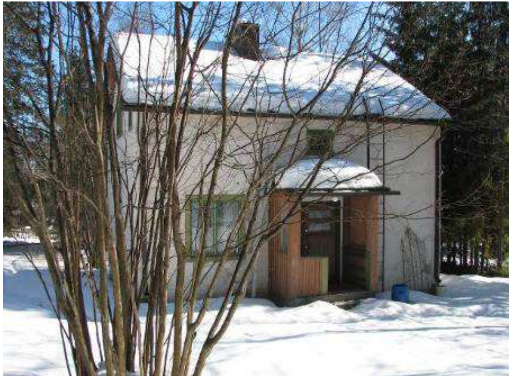
Kuva: Tapiolan rapattu asuinrakennus länsipuolelta.
