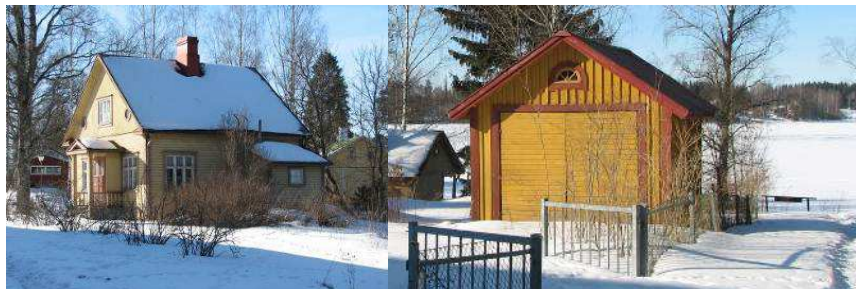
Kuvat: Rakennusajan niukka klassismi näkyy rakennusten julkisivuissa.
