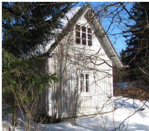
Kuva: Rakennuksen eteläpäätyä
