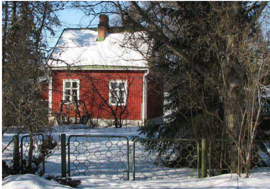
Kuva: Risukon huvila, portti edustaa sotien jälkeistä metallinkäsittelyä.
