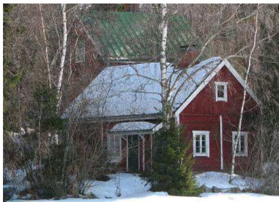
Kuva: Karinsivun kookas rantarakennus, taustalla näkyy Risukon huvila
