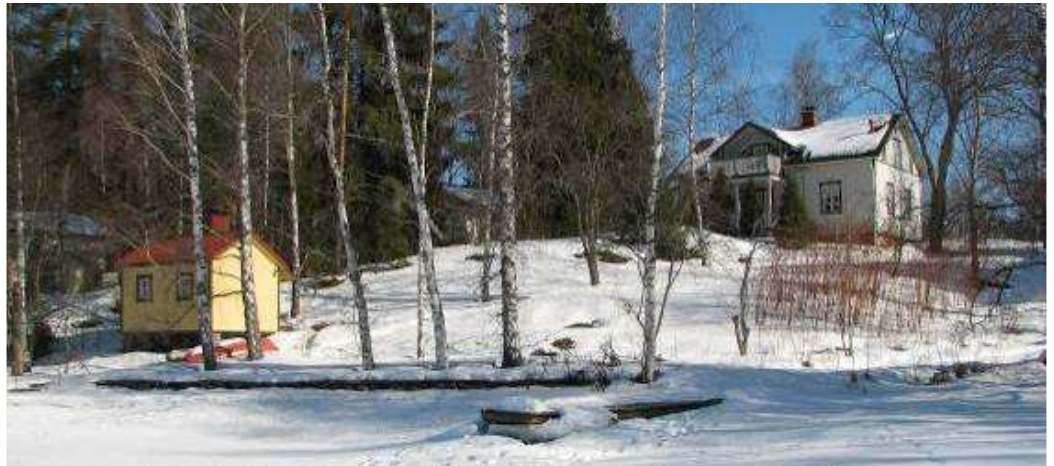
Kuva: Suvimäen rantarakennus ja huvila länsipuolelta
