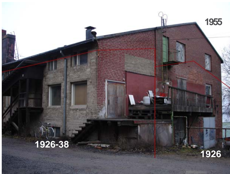
C. Tehtaan eteläsiiven itäpääty
