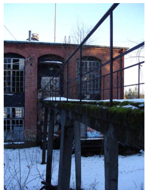
Yläpuolella: Näsijärven pahvitehtaan teräs-betonirakenteinen lastaussilta suoraan rautatielle Alla: OTK:n tulitikkutehtaan lastaussilta
