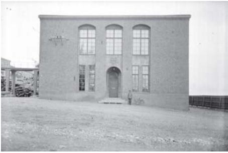
Tehtaan itäpäädyn paraatijulkisivun konttorisääkäyntiä on korostettu. Ovenpielessä seisoo vartija. Kuva TKM I_57
