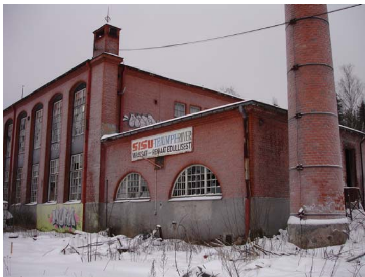
Yläkuva Näkymä tehtaan eteläisivusta syksyllä 2006
