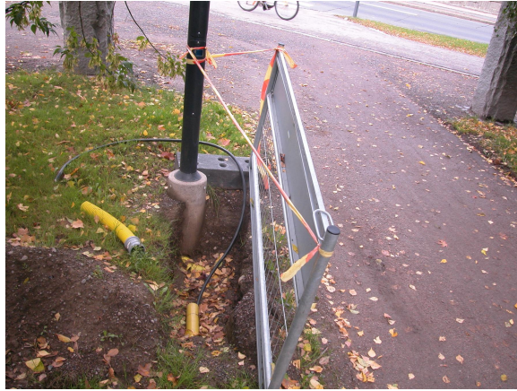
Kaapelikaivanto hautausmaan luoteiskulmassa, taustalla Pirkankatu. Kuvaaja: Sami Raninen.
