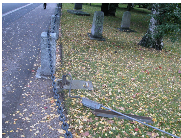
Poistetun valaisinpylvään jäännös Pirkankadun laidalla. Kuvaaja: Sami Raninen.
