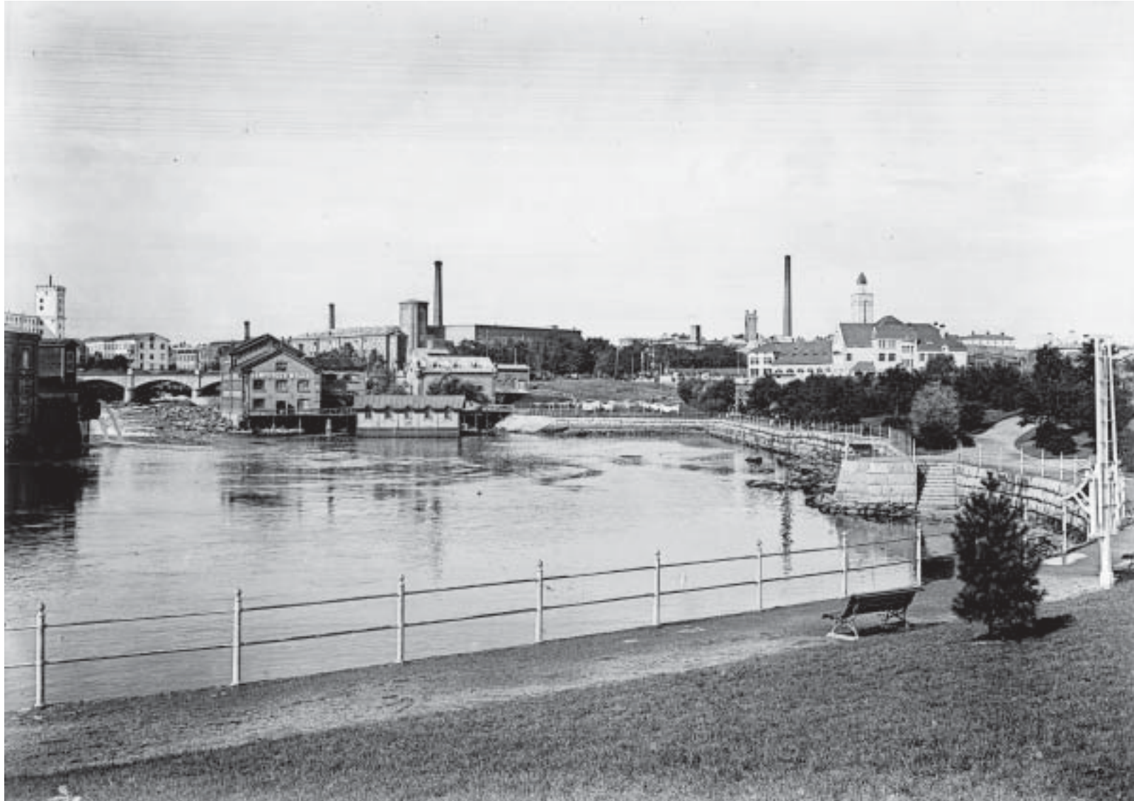
Koskipuiston rantaviiva alkuperäisessä muodossaan ennen kosken uoman täyttöö, joka tapahtui 1930-luvulla. Rantamuurissa oli portaat alas veteen ja pieni näköalapaikka. Rantaviivan oikaiseminen muutti voimakkaasti puiston luonnetta, kuten myöhemmistä kuvista on helppo havaita. (Tampereen museot, kuvaarkisto, E.A. Bergius)
