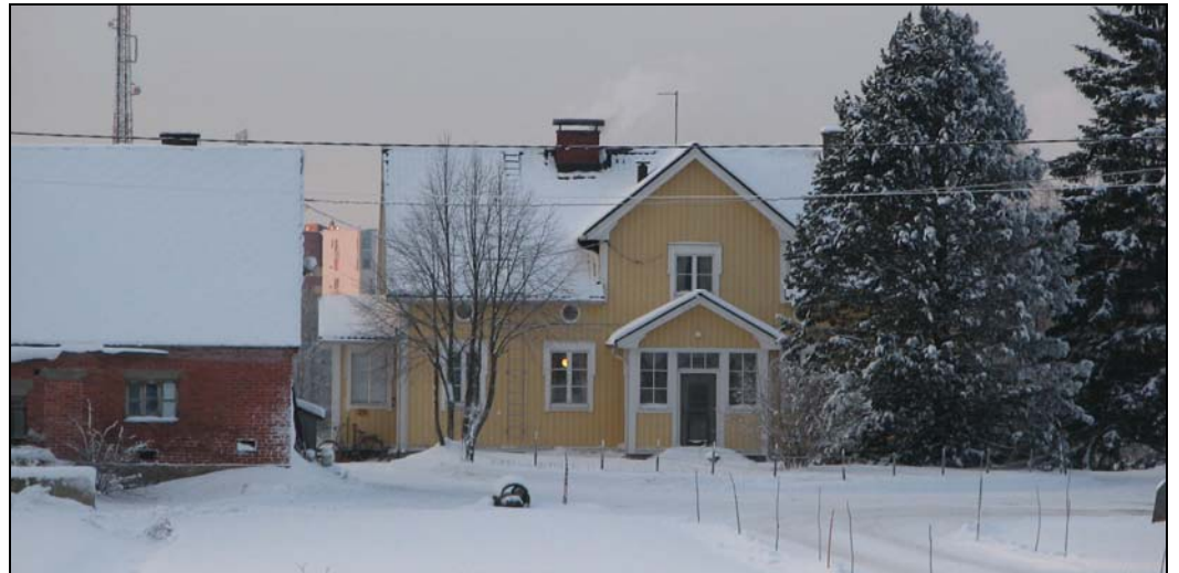
Kuva: Peltomäen navetta ja päärakennus pihatien ja kylätien suunnasta kuvattuna.
