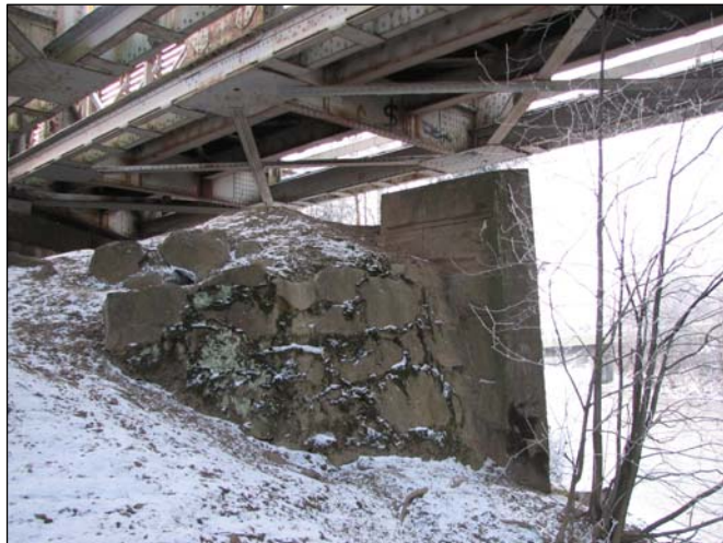
Kuva: Vanhan, yksirataisen sillan perustukset nykyisen sillan alla. Reunoista viimeistellyistä lohkokivistä muurattuun kivimuuriin liittyy epäsäännöllisistä kivistä muurattu tukimuuri.
