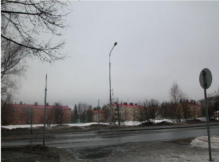
Näkymä Koivukujan rakennuksiin Nuolialantieltä. Keskellä urheilukenttä. Anna Lyyra-Seppänen 16.3.2012
