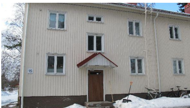
Pihajulkisivu, sisäänkäynti. Anna Lyyra-Seppänen 13.3.2012
