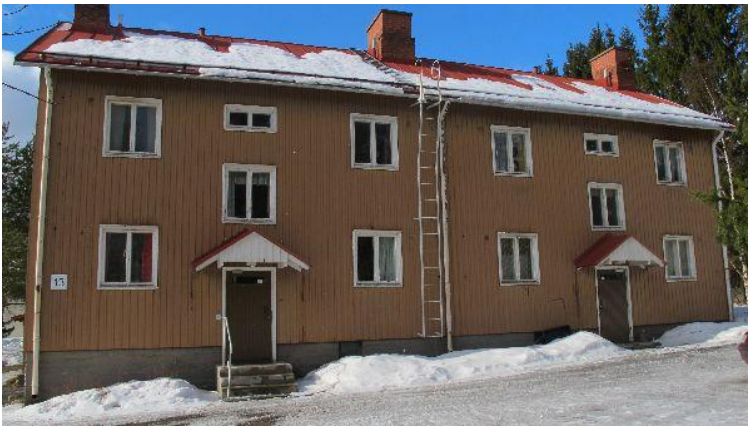
Pihajulkisivu koillisesta. Anna Lyyra-Seppänen 13.03.2012 12:43:55
