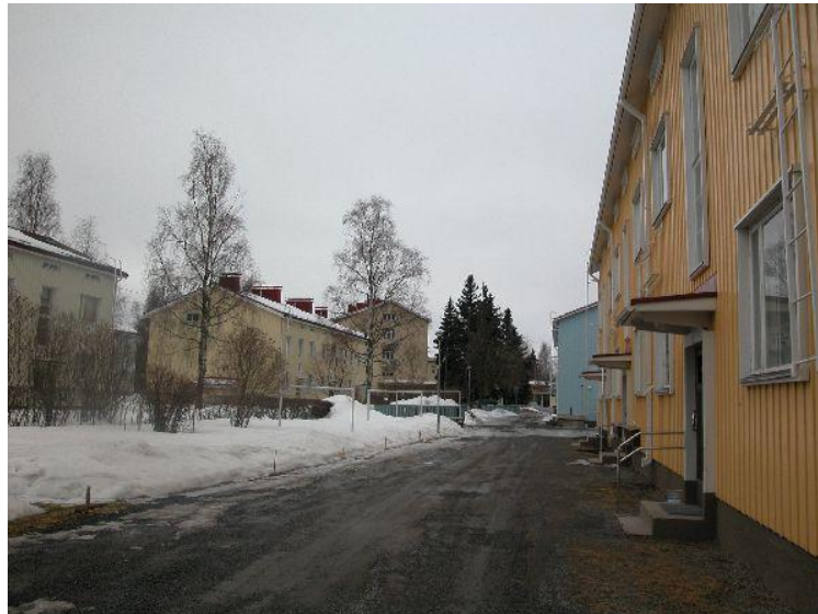
Nekalantie 64:n pihaa. Takana näkyvä korkeampi kivitalo on Nekalan päiväkoti. Anna Lyyra-Seppänen 16.3.2012
