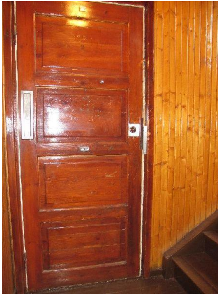
Asunnon ovi porraskäytävään, alkuperäinen. Anna Lyyra-Seppänen 13.3.2012
