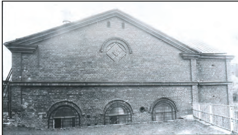
Värjäämön pohjoispääty vuonna 1979. Pyöreä yläikkuna on muurattu umpeen. Pohjakerroksen ikkunat ovat osittain maan alla. Kuva Marna Maula.
