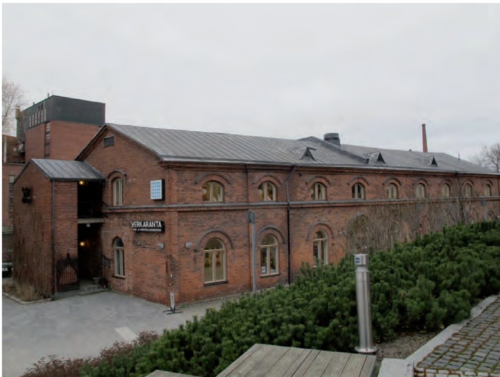
Verkarannan eteläpäätyyn on rakennettu varapoistumistieporras vuonna 1984.
