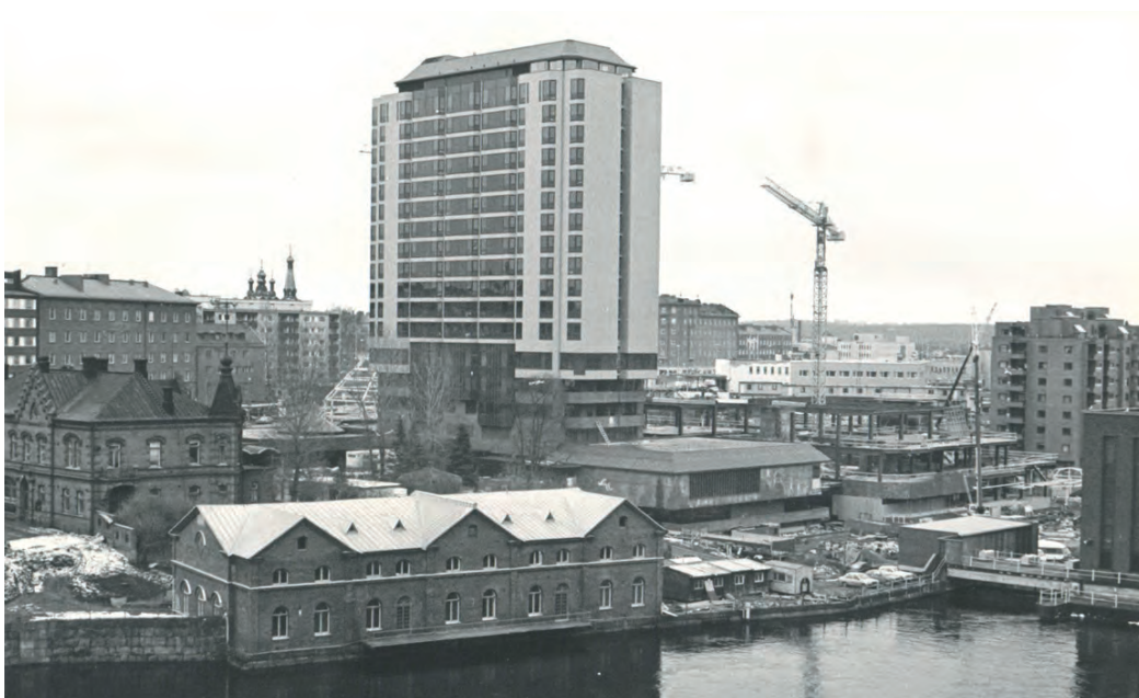
Verkatehtaan alue vuonna 1986 hotelli Ilveksen valmistuessa. Värjäämön eteläpäässä sijainneet kuivaamo ja karstalanakehäämö on purettu. Kuva TSA.
