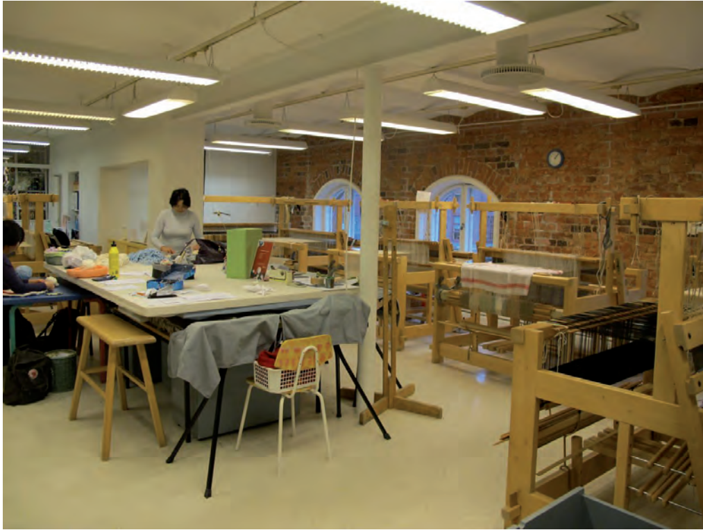
Toisen kerroksen kudontahuone. Koskenpuoleinen tiiliseinä on hiekkapuhallettu alkuperäinen Lambeert Pettersonin laajennuksen seinä vuodelta 1899- Alkuperäinen ulkoseinän linjaus näkyy etualalla teräspilarin kohdalla.
