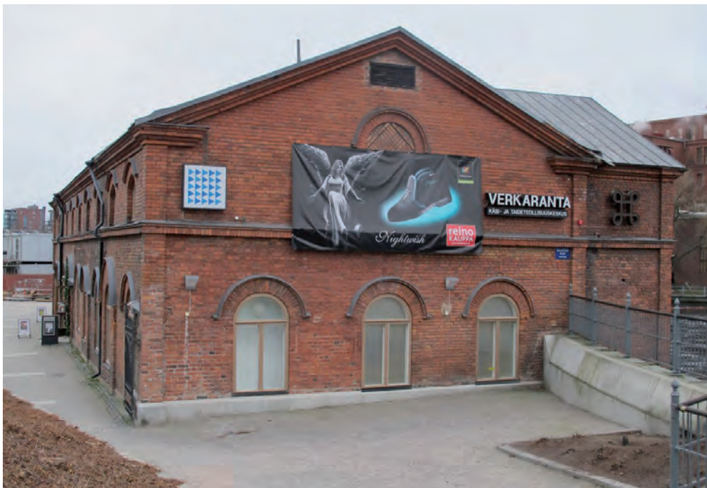
Verkarannan pihaa on laskettu pohjoispäädyssä, jotta ikkunat saatiin pihatasolle. Pään sokkelit on verhoiltu graniittilevyillä muutostyön yhteydessä. Tammerkosken rantaan on rakennettu uudet teräsaidat.
