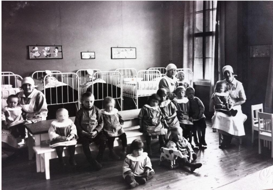
Lastenseimen päiväsalii 1920-luvulla ja vuonna 1938 (vasemmalta) Lattiaan on asennettu lino-leumimatto suojaamaan laudoitusta kulutukselta. Seinien yläosat on maalattu valkoisiksi ja alaosa on vaneria.
