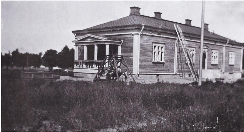
Rakennus valmistusvuotensa aikoihin. Esillä vielä paljas hirsiseinä, joka jätettiin muutamaksi vuodeksi painumaan ennen vuorauksen asennusta. Verantaa ei ole vielä laajennettu.
