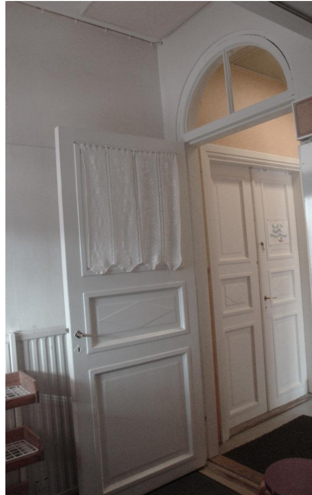
Rakennuksen ikkunat ja ovet ovat alkuperäisiä, niihin on uusittu lukkoja ja pintamaali.
