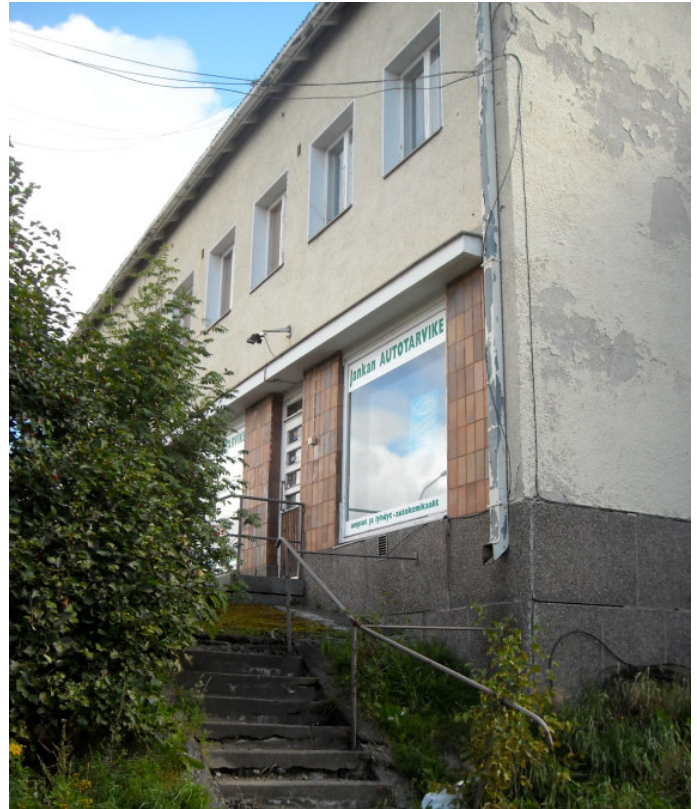
Takahuhdin Voima , eteläjulkisivua Kuva: Ursula Dye, 2012
