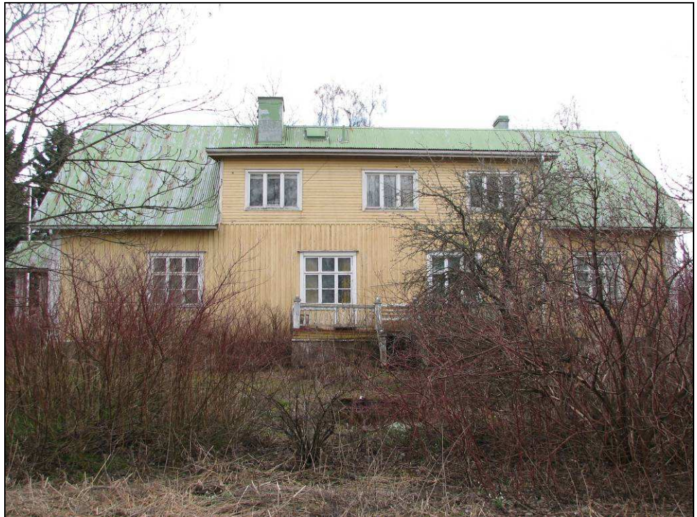
Kuva: Jankan päärakennuksen pihanpuoleinen, länsisivun julkisivua.
