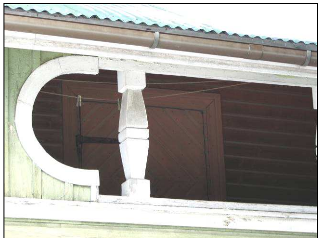
Kuva: Solan aukotusta, luhdin yläosa on lautarakenteinen, joten pienten aukkojen pylväillä on lähinnä koristetarkoitus.
