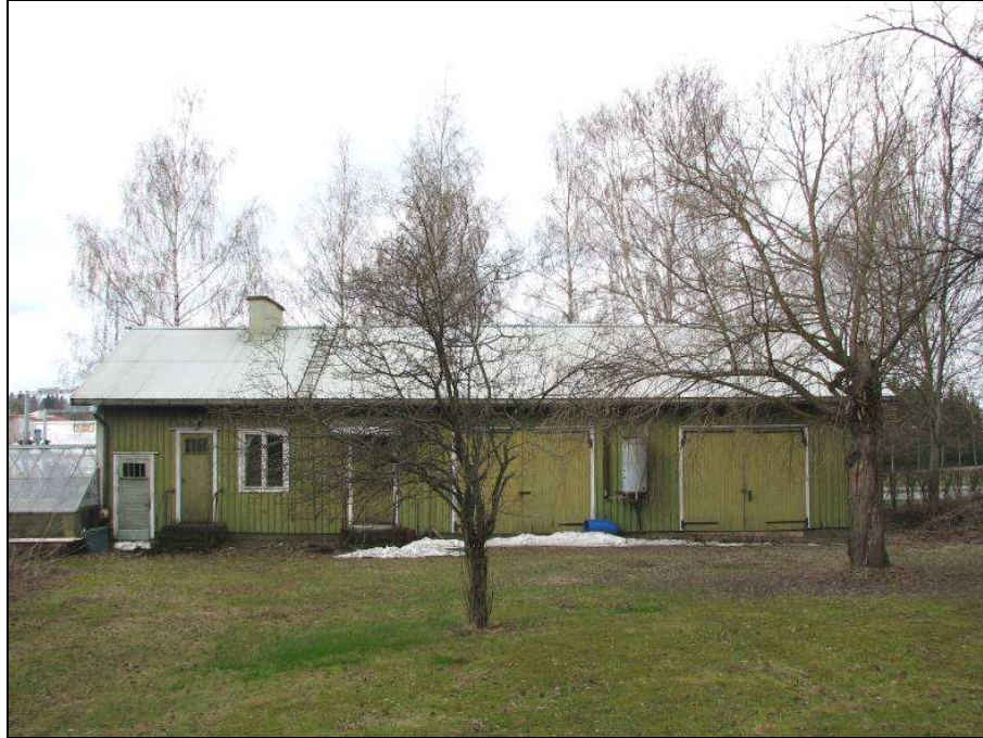
Kuva: Alarakennus kuvattuna pihan puolelta.
