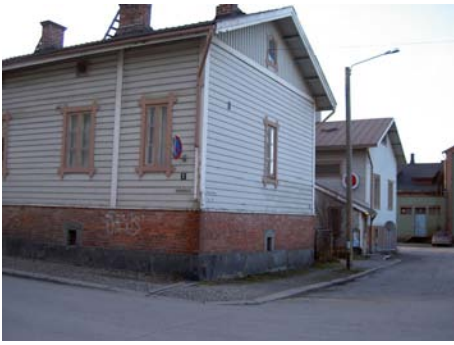
Kuva 72 Murtokadun ja Vellamonkadun kulma
