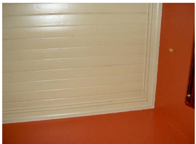
Kuva 118 Asunnon eteisen peittomaalattu paneelisisäkatto
