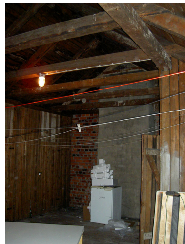
Kuva 115 Rakennuksessa on korkea avoin kylmä ullakko
