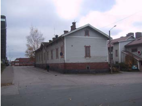
Kuva 73 Rakennuksen pääty pohjoiseen
