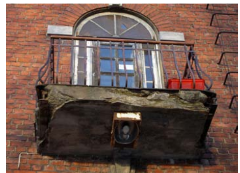
Kuva 95 Parveke pihanpuolen sisäänkäynnin päällä
