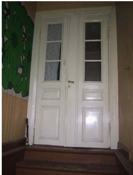
Kuva 85 Lasiaukollinen paripeiliovi portaiden yläpäässä
