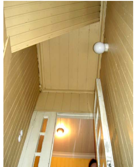
Kuva 88 Lasiaukollinen paripeiliovi portaiden yläpäässä
