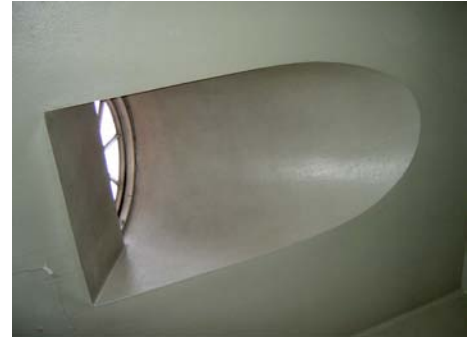
Kuva 103 Kattolunetti porrashuoneessa
