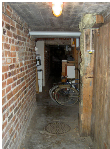
Kuva 114 Näkymä kellarikäytävästä. Kellarissa on asuntojen irtaimistovarastot.
