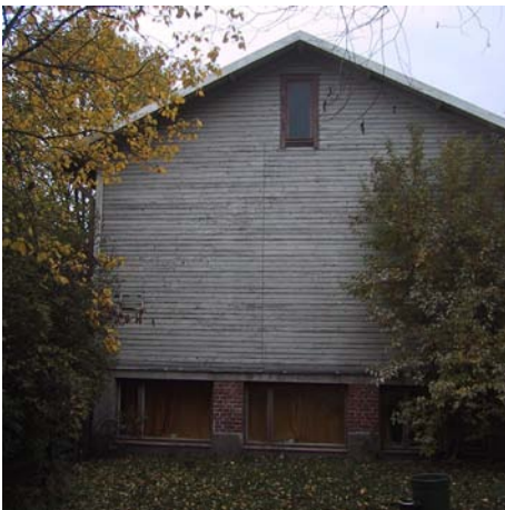
Kuva 51 alhaalla Morkun laajennusosan pääty
