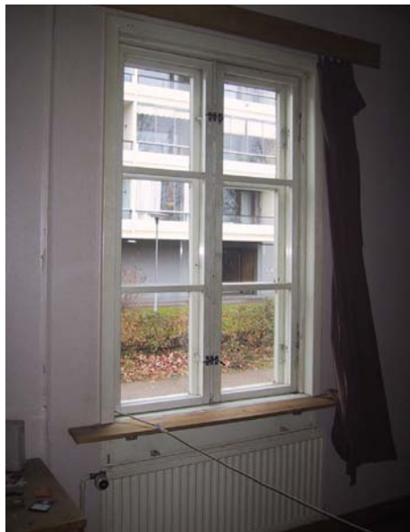
Kuva 87 Asuinhuoneiston ikkuna sisäpuolelta
