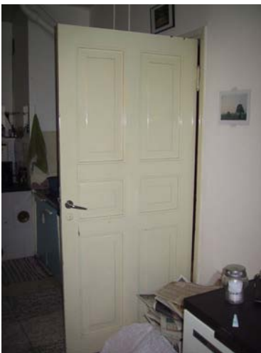
Kuva 113 Huoneistojen sisäovet ovat peitto-maalattuja peiliovia
