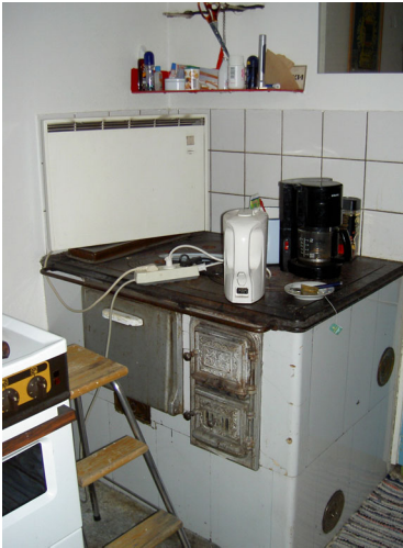
Kuva 108 Asuinhuoneistojen keittiöissä on alkuperäiset puuliedet.
