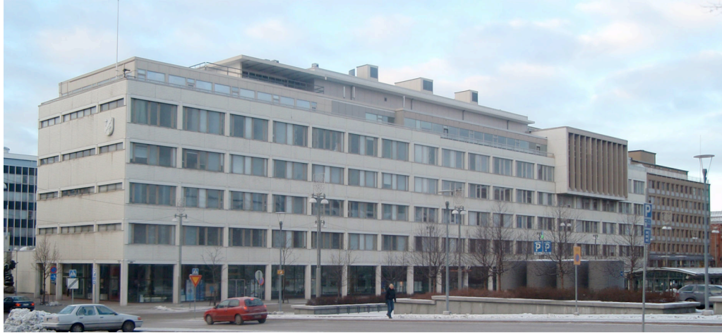
Näkymä Keskustorille v. 2009. Katolla uusi iv-konehuone.
