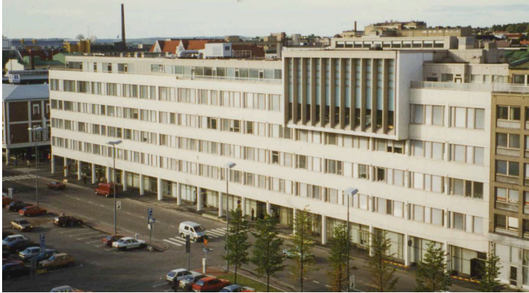
Keskusvirastotalo 1990-luvun lopulla ennen iv-konehuoneen rakentamista (Kuva Pentti Lajja)
