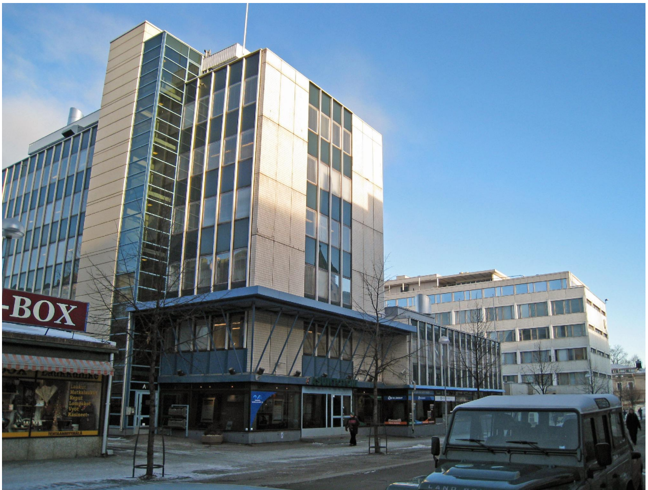
Näkymä Puutarhakadulta, rakennukseen lisätyt hissikuilu ja katos
