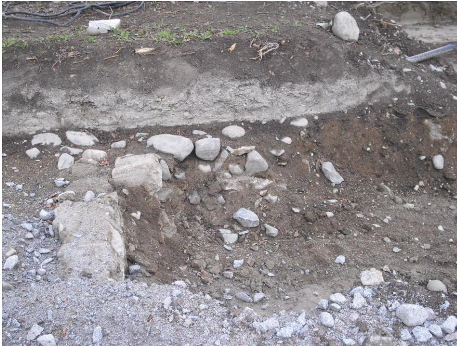
Kuva 27. Sementtisokkeli osittain poistettuna. Profiilissa näkyy hyvin puistomultakerros, sokkeliin liittyvä maanpinta ja sen alla oleva perustushiekka. Kuvaussuunta S.
