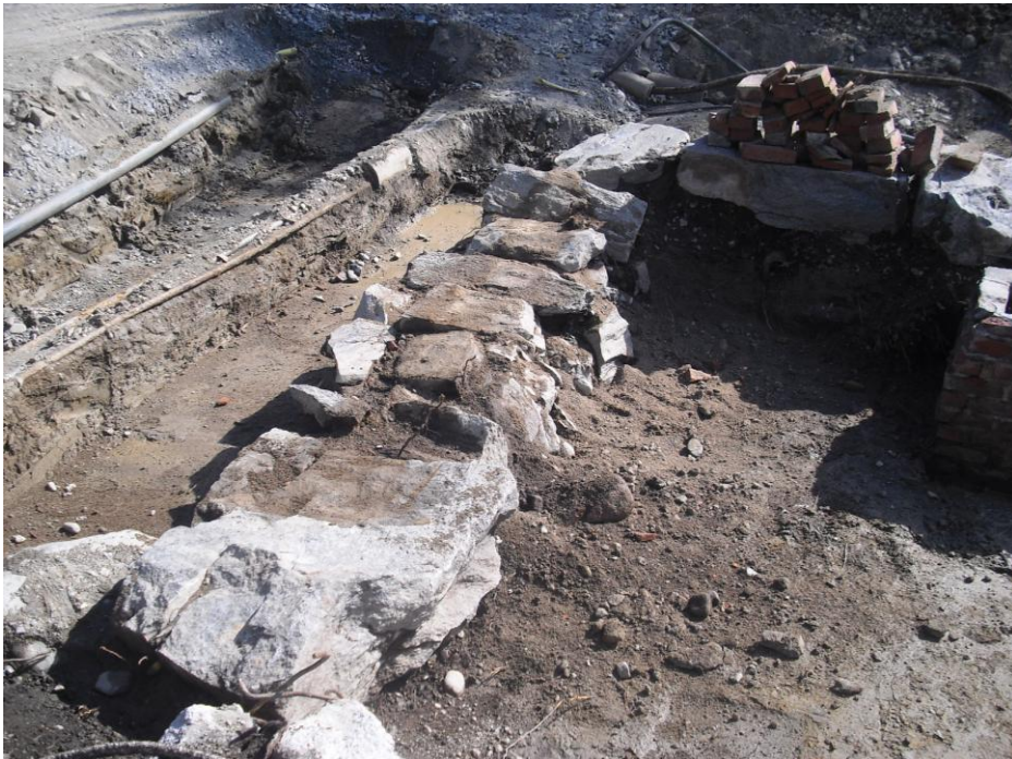
Kuva 30. Tiilimuuraus poistettuna. Kuvaussuunta W.
