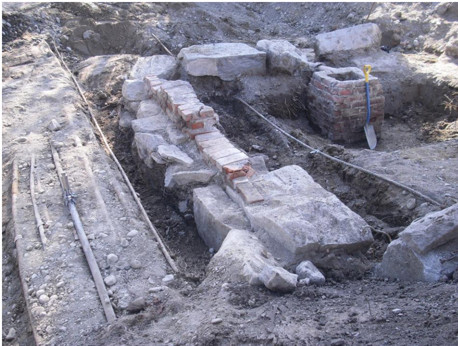
Kuva 4. Esiin kaivettuja rakenteita, sekä katkaistuja ja katkaisemattomia kaapeleita. Kuvaussuunta NW.
