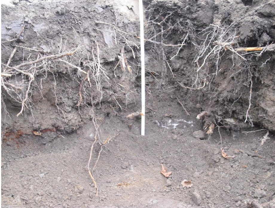
Kuva 45. Puistovalon perustuskuoppa. Kuvaussuunta N.
