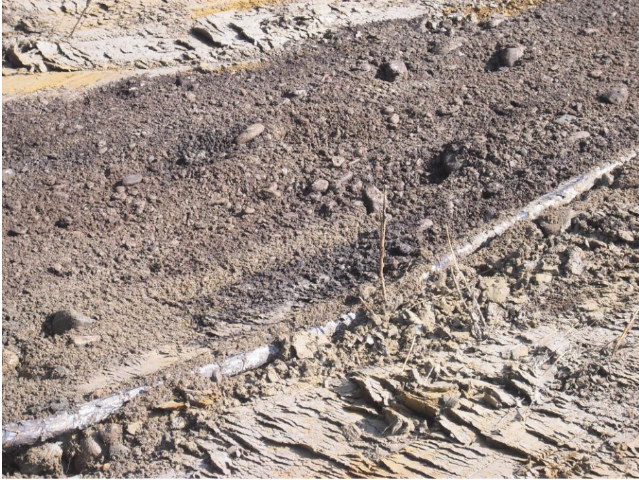
Kuva 31. Perustusten alla näkyvä tumma maa silltissä savessa.
