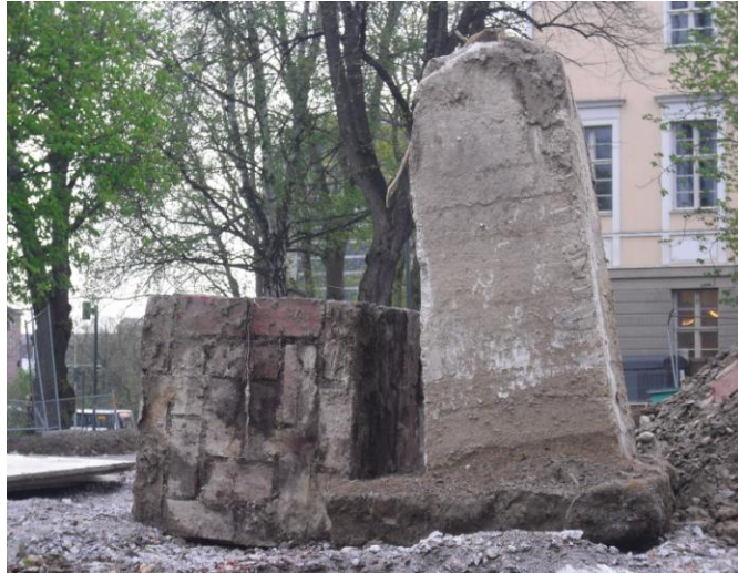
Kuva 47. Sadevesikaivo ja puistovalon sementtiperustus poistettuna.
