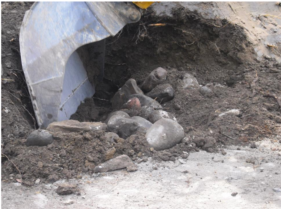
Kuva 44. Kenttäkiveystä rikotaan puistovalon perustuksen takia. Kuvaussuunta N.
