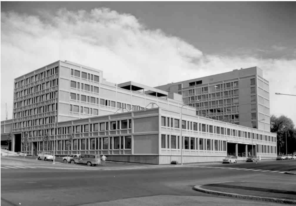
Postitalo 1971, länsi- ja pohjoisjulkisivu
