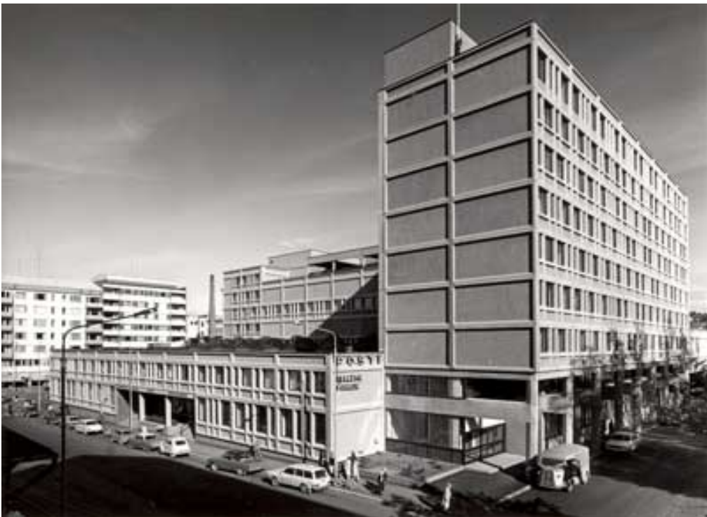
Postitalo 1971, länsi- ja eteläjulkisivu
