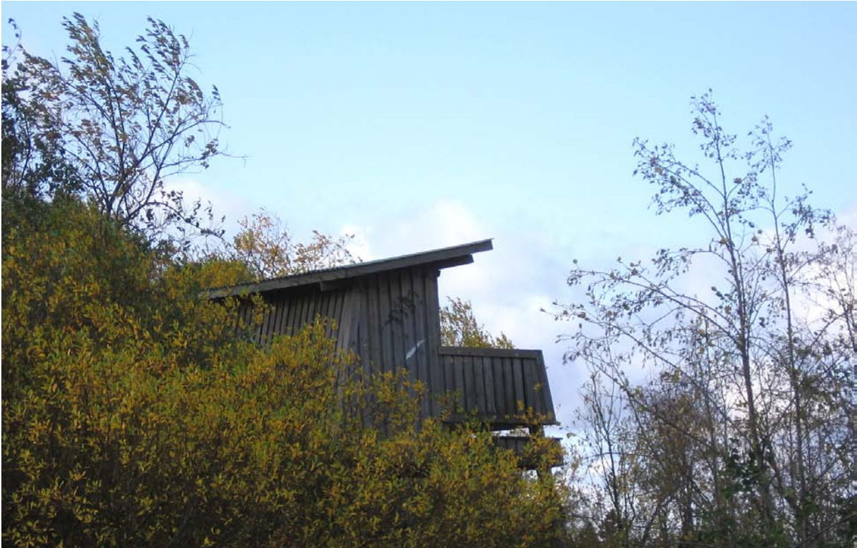
Kuva 62. Järven itäpäässä oleva lintutorni.
