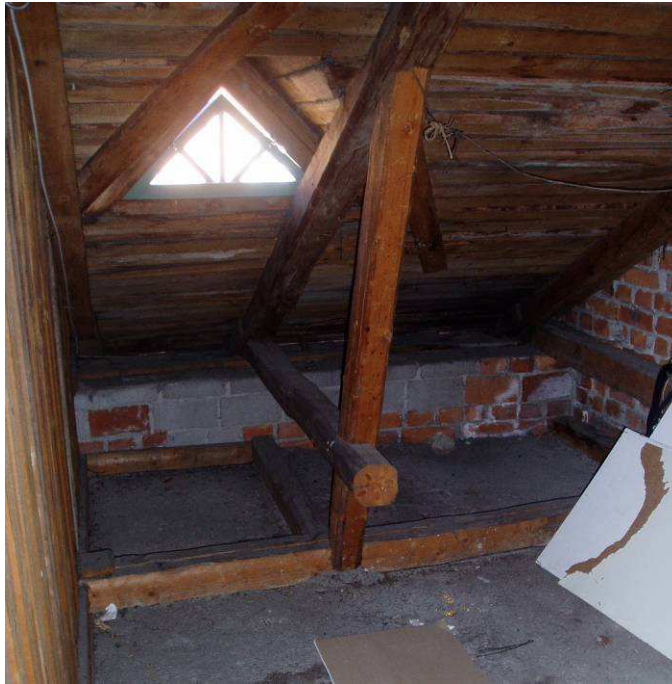
Kuva 8) Vesikaton rakenteet ovat alkuperäisiä.
