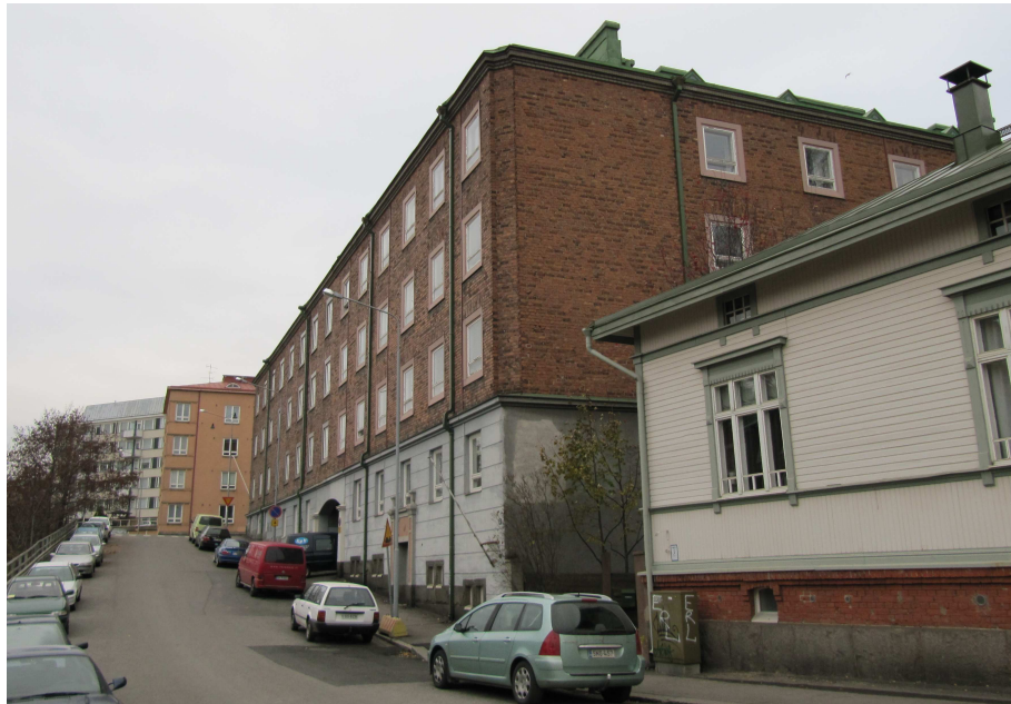
Kuva 4) As Oy Kastinsilta ja takana As Oy Kastinlinna Pajakatua tultaessa.
