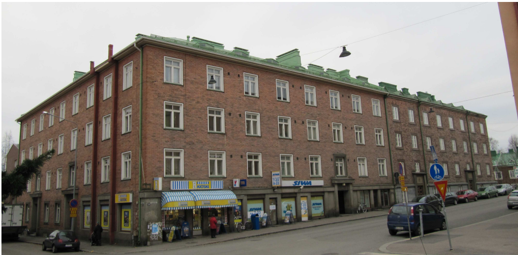
Kuva 2) As Oy Kastinkallio, oikealla As Oy Kastinlinna Siltakadulta kuvattuna.
