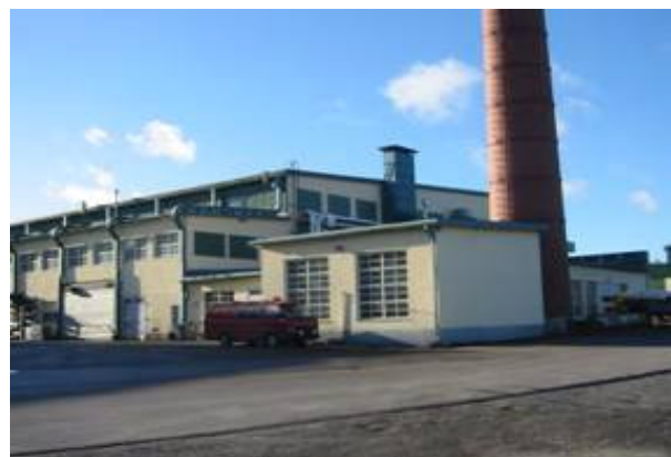
Kuva 2 - Pihahallin pohjoispääty ja savupiippu
