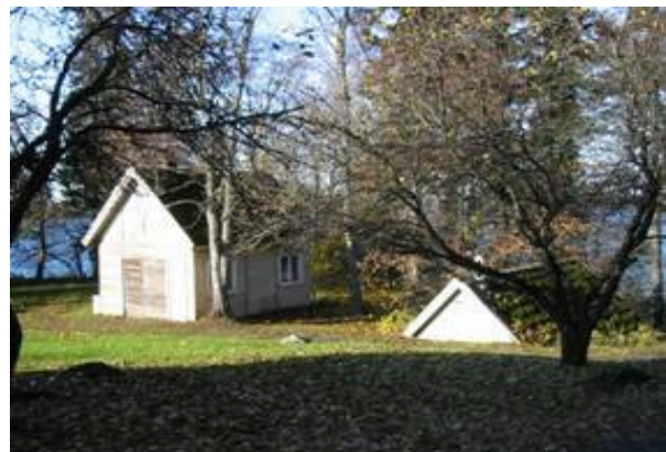
Kuva 3 - Pihavarastot, nro 49 ja 50
