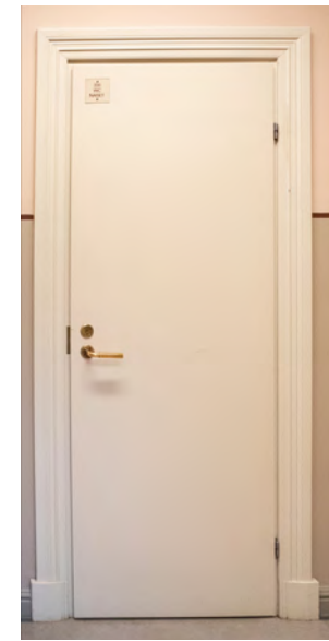
Tyypillinen täysin uusi sisäovi 1990-luvun peruskorjauksesta
