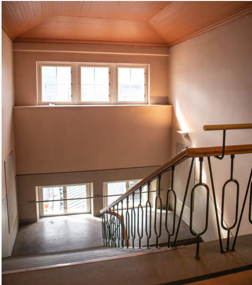
309 PRSH. Porrashuoneen ylimmät kolme ikkuna-aukkoa rakennettiin 1920-luvulla. Oikealla kuvassa näkyy porraskaiteen korotusosa 1990-luvulta.
