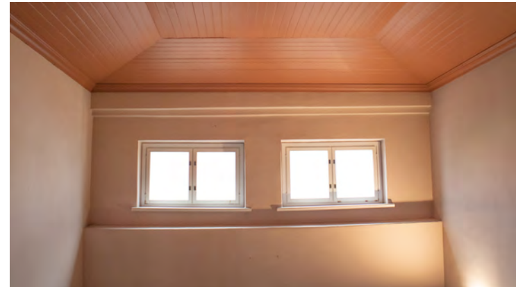
311 PRSH. Pohjoiseen avautuvat porrashuoneen pienet ikkuna-aukot ovat alkuperäiset
