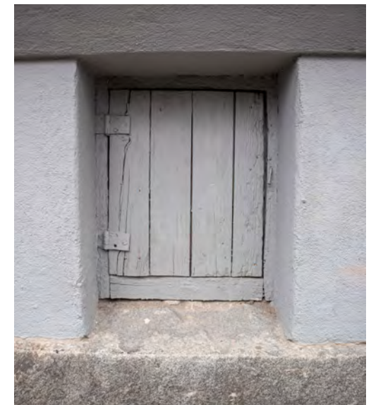
Kellarin puinen tuuletusluukku sokkelissa
