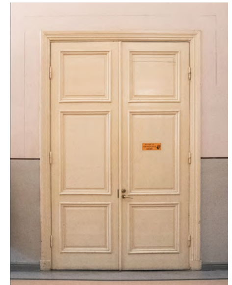
Osassa vanhoja sisäovia on kolme sarranaa ja vetimen paikka matalalla ovi-lehdessä
