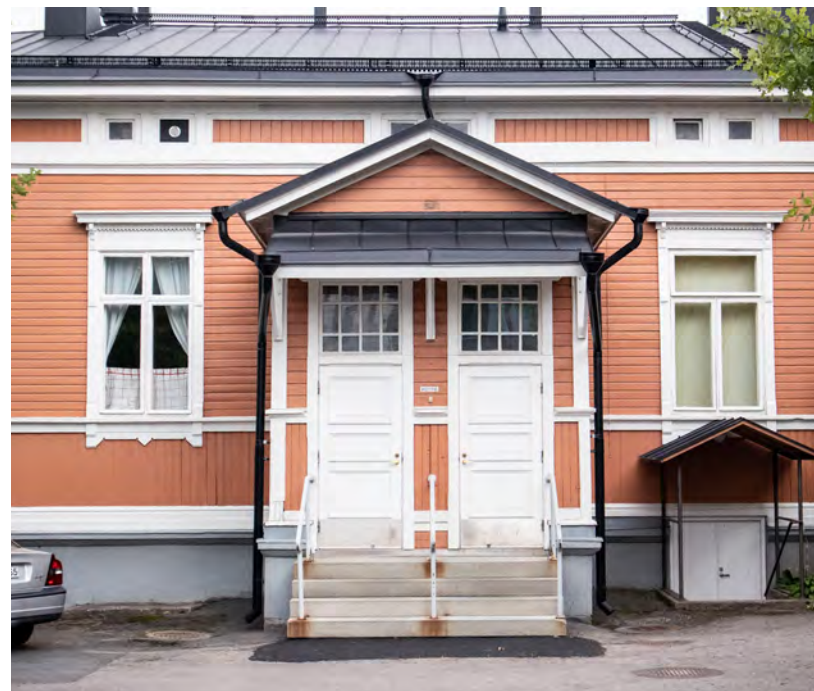
Ruokalarakennuksesta löytyy runsaasti ajallista kerrostumaa, joka välittyy esimerkiksi ikkunoita tarkastellessa. Kuvassa kuistin vasemmalla puolella on ristikarmillinen ikkuna, joka on todennäköisesti korjausmuutos vuonna 1918 tapahtuneesta sotavauriosta. Oikealla puolella kuistia on alkuperäisen 1890-luvun uusrenessanssityylinen T-karmillinen ikkuna. Kuistin sisäänkäynti on uusittu, ulko-ovien yläpuoliset ikkunat ovat todennäköisesti alkuperäiset.
