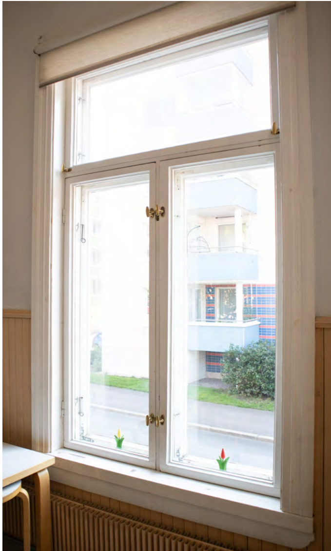
Tyypillinen ikkuna sisään-ulos-aukeava ruokalarakennuksessa: Sisäpuolinen ikkuna on saranoitu sisään aukeava ikkuna vuoden 1987 peruskorjauksesta, ulkopuolinen ikkuna on vanhempi saranoitu ulos aukeava ikkuna arviolta 1890-1920-luvulta
