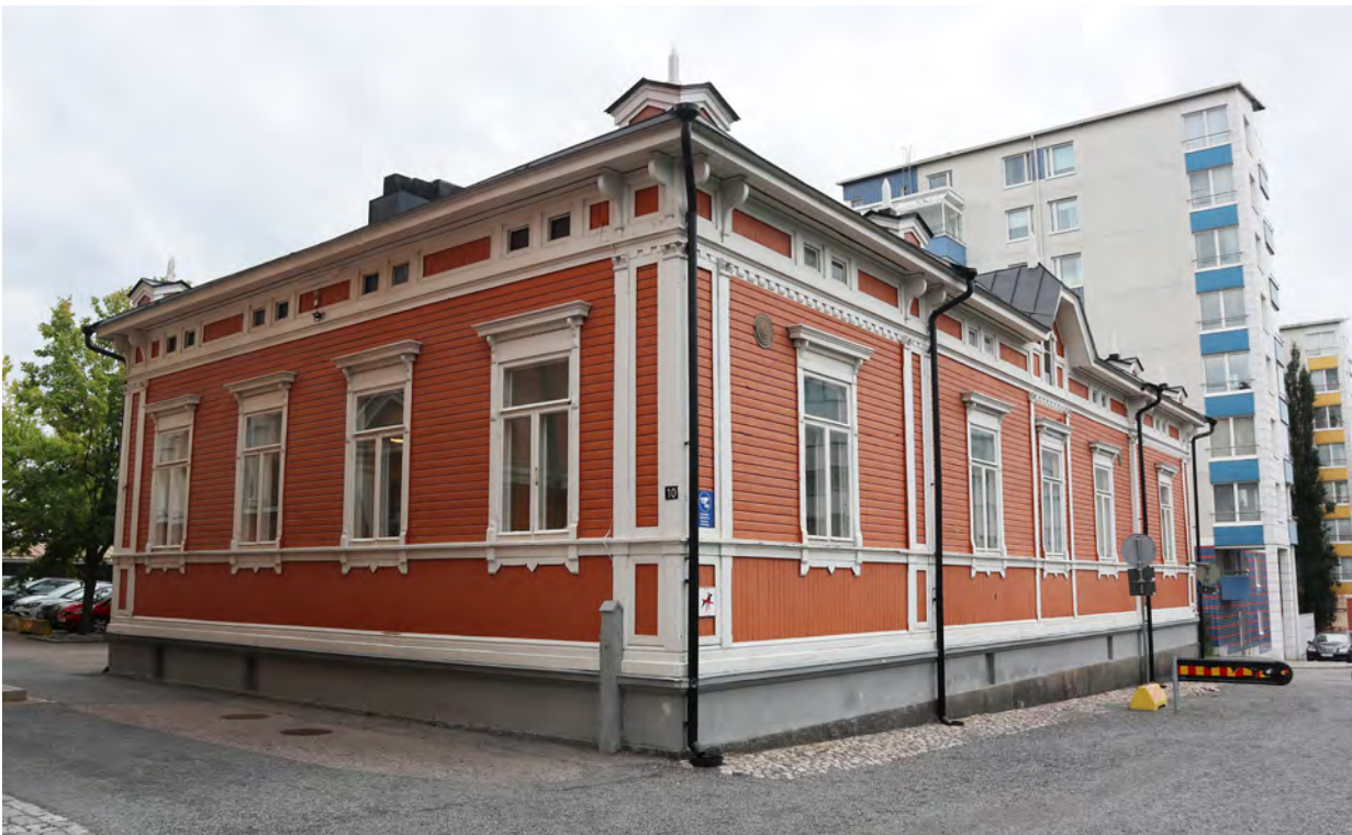
Ruokalarakennuksen pohjois- ja länsijulkisivu elokuussa 2023.
