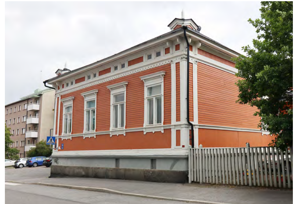
125-vuotiaan eteläjulkisivun ilme on säilynyt hyvin lähellä alkuperäistä. Sahatut koristeet toteuttavat puumateriaalille uskollista muotomaailmaa, nikkarityyliä. Valokuvattu elokussa 2023.
