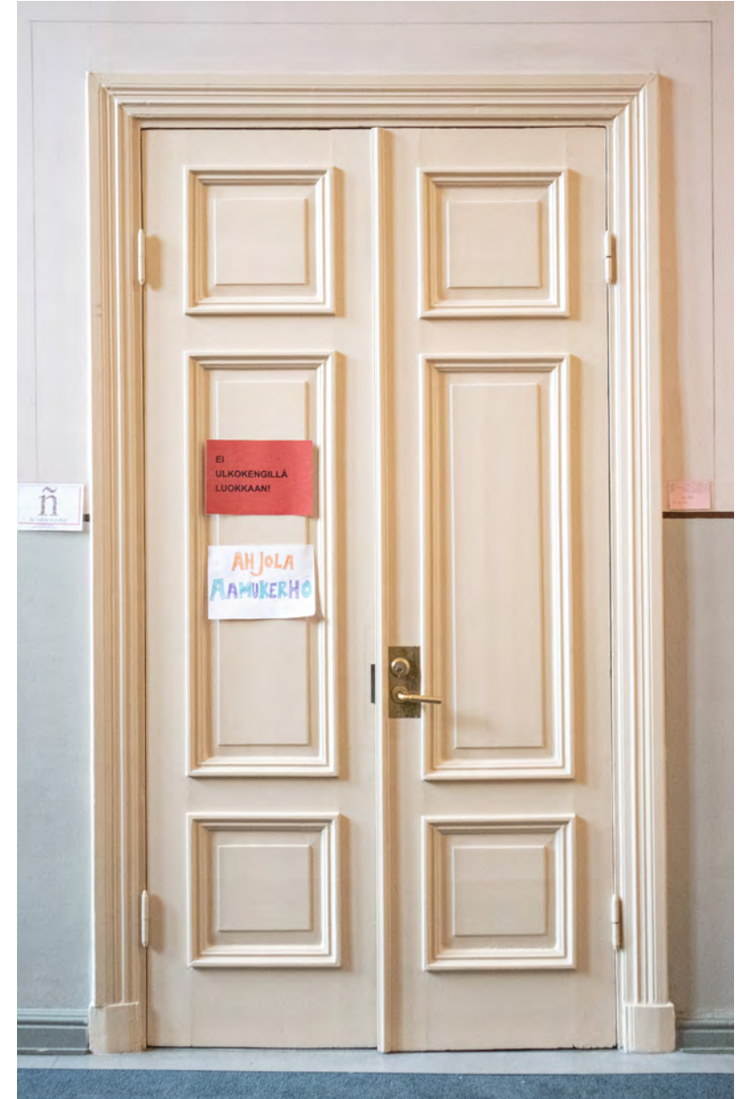
Tyypillinen alkuperäinen mutta kunnostettu paripeiliovi koulun sisätiloissa. Huomaa vanhemmat saranat vasemmalla, oikealla uudemmat
