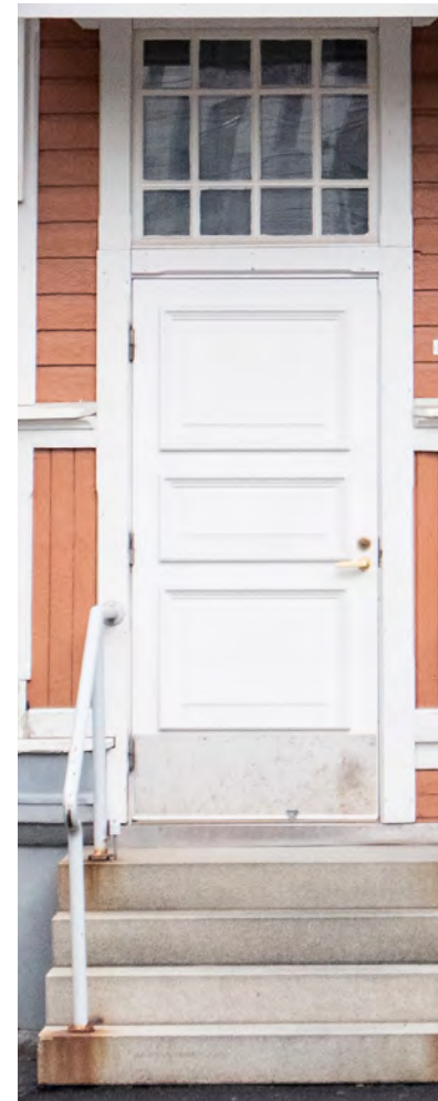
1987 peruskorjauksessa kokonaan uudelleen rakennettu ulko-ovi. Yläpuolinen ikkuna alkuperäisellä paikallaan, mutta sisä- ja ulkopuutteet laseineen on uusittu. Ulkopuolinen ikkuna on vanhempi kuin sisäpuolinen.
