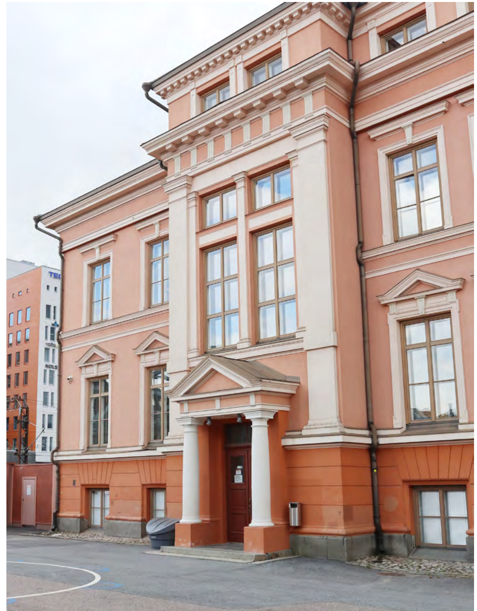
Pohjoinen sisäänkäynti on säilynyt lähellä alkuperäistä asuaan. Pihakorko on noussut ja kiviportaat peittyneet asfaltin alle. Räystäään aluolella rakennusta kierrättävä useamassa kohdassa mutulus eli koristeellinen riippulaatta, joka erottuu valokuvassa hyvin.
