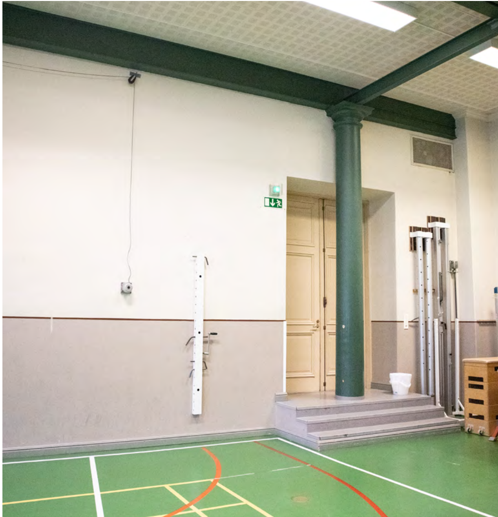
Voimistelusalin läntinen oviaukko käytävälle. Nykytilan maalaustyylit ja värit tapailevat alkuperäisen suuntaista, vaikka ilme onkin muuttunut varsin paljon. Rakennuksessa alkuperäisesti toimineen ilmanvaihto- ja lämmitysjärjestelmän luokkuja on peitetty, moderni tekniikka on sijoitettu alaslaskettuun alakattoon.
