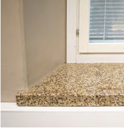
Lähes kaikkien opetustilojen ikkunat ja ikkunapenkit on uusittu 1990-luvulla.
