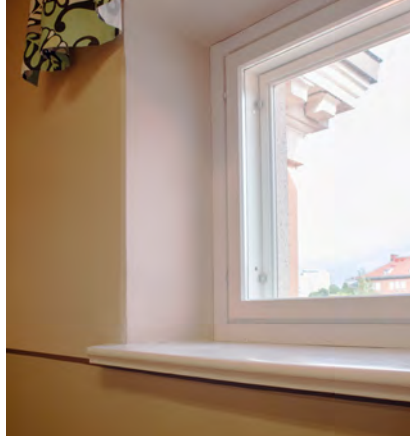
Kuitenkin joissakin opetustiloissa on edelleen vanhoja ikkunaosia, kuten puisia ikkunapenkejä. Kuvassa ullakokerroksen luokkatilan 304 ikkunapenkki.
