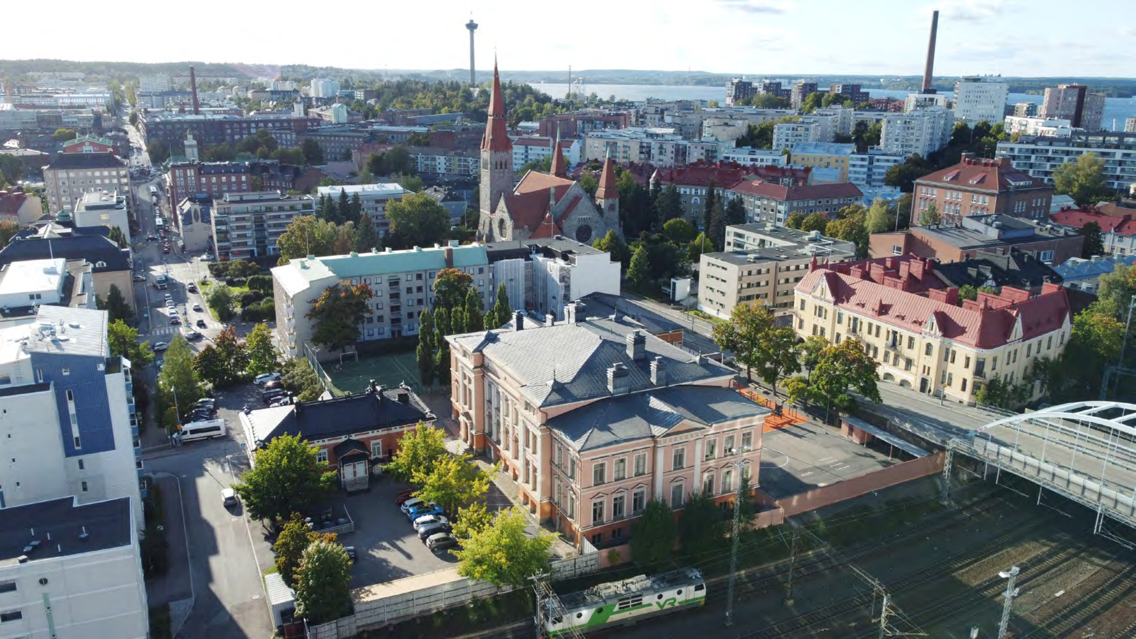
Juhannuskylän maisemaa ratapihalta Näsinneulaa kohti. Pitkä Satakunnankatu vasemmalla jatkuu Klassillisen lukion ja Keskuspaloaseman ohi Amuriin asti. Johanneksen koulu on kuvassa keskellä ja tämän takana Tuomiokirkko. Oikealle jää Erkkilän silta, Schreckin talo ja punatiilinen Tammerkosen koulu. Kauempana kuvassa Ranta-Tampellaa ja Näsijärveä.
