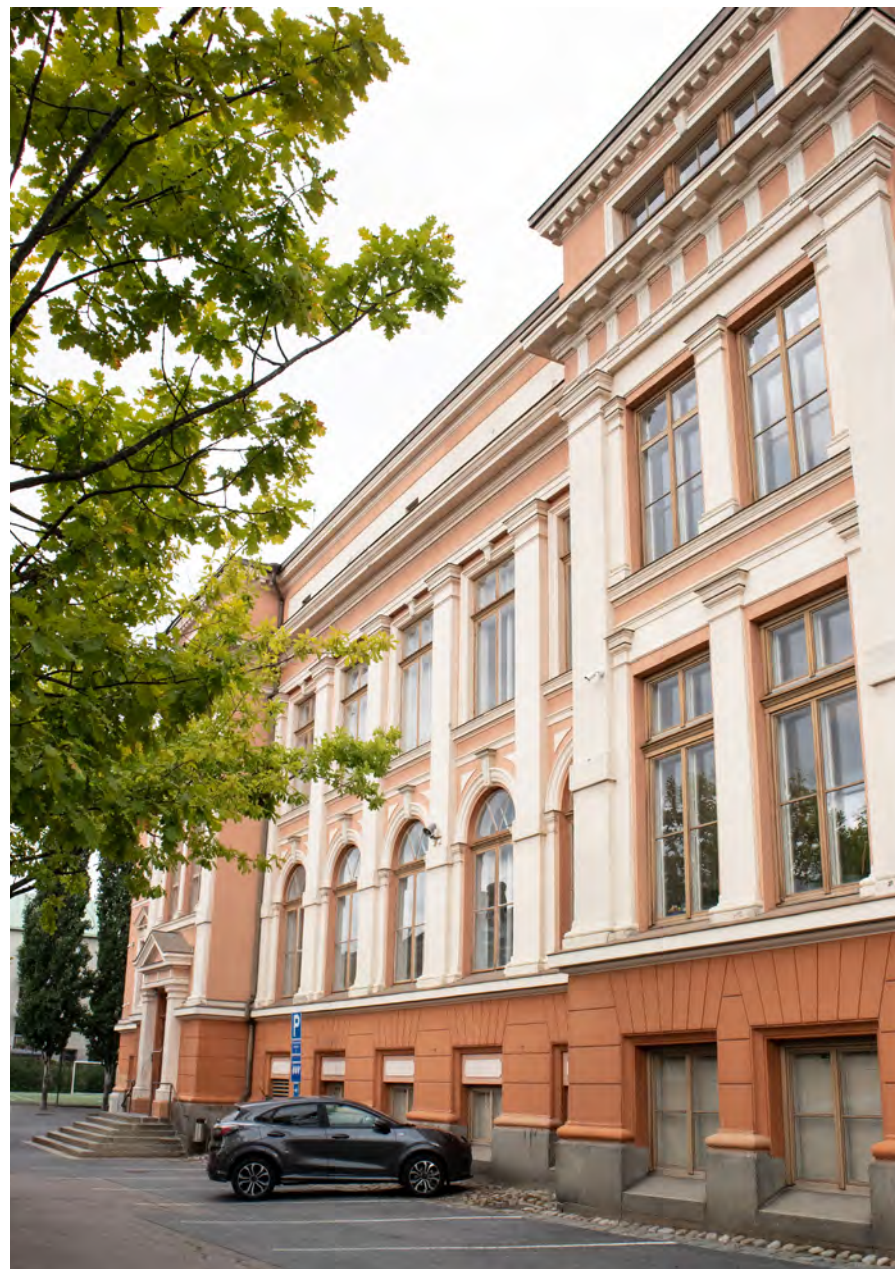
Rakennuksen ainoat kaari-ikkunat ovat eteläjulkisivulla. Kenties alkuperäisellä muotoalinnalla on haluttu erottaa eteläinen tyttöjen puoli pohjoisesta poikien puolesta. Kyseisissä kaari-ikkunoissa on säilynyt vanhoja rakenteita. Kuvassa näkyy myös eteläisen pihan pysäköintipaikat ja sisäänkäyntiä korostavat kiviportaavat.
