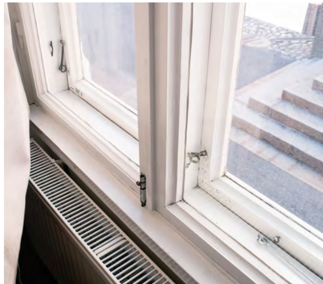
Pohjoisjulkisivun ikkuna, jossa useita erilaisia ja eri-ikäisiä heloja. Sisäpuolinen ikkunapuite on aavistuksen koristeellisempi kuin rakennuksesta muualta löytyvä 1980-luvun versio.
