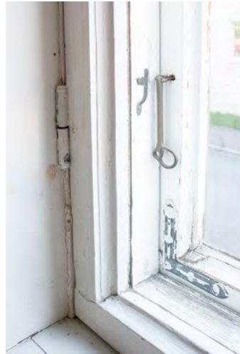
Sisältä uusi, ulkoa vanha: Sisäpuolella sarana, ulkopuolella myrskyhaka ja pyrstökouku sekä kulma- rauta. Ulkona julkisivulla vanhempi viistetty sarana.
