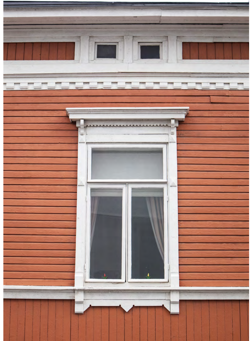
Julkisivun vuorilaudat ovat tyyliltään alkuperäiset uusrenessanssin henkeen koristellut. Muilta osin suurin osa ikkunoista on uusittu. Julkisivuja on jäsennellyt koristeellisilla listoilla.
