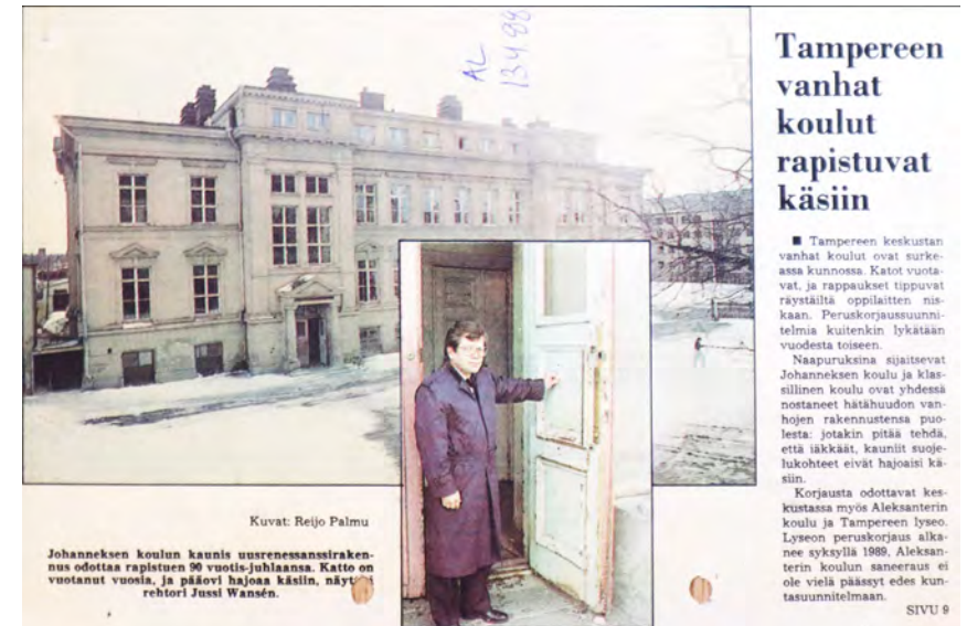
Aamulehdessä julkaistu uutinen 13.4.1988 peruskorjausta odottavasta Johanneksen koulusta. TKA
