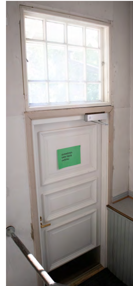
1987 peruskorjauksessa kokonaan uudelleen rakennettu ulko-ovi. Yläpuolinen ikkuna alkuperäisellä paikallaan, mutta sisä- ja ulkopuutteet laseineen on uusittu. Ulkopuolinen ikkuna on vanhempi kuin sisäpuolinen.
