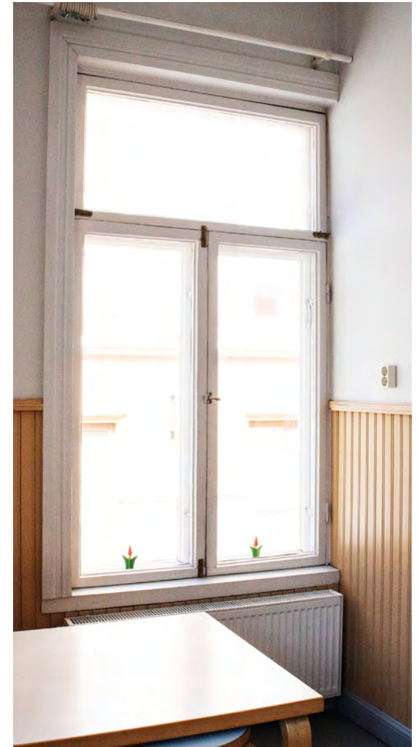
Pohjoisjulkisivun ikkuna on jäänyt 2000-luvulla rakennetun seinän tiukkaan kulmaan. Helat ovat tässäkin erilaiset kuin suurimmassa osassa rakennuksen ikkunoista.
