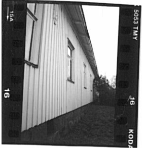
ASUINRAK LÄNSIPUOLEN SEINÄ
