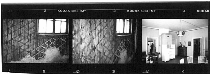
Navetan sisäseinän rimoitus ja rappaus
