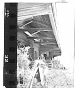
riihen otsan tukirakenteet
