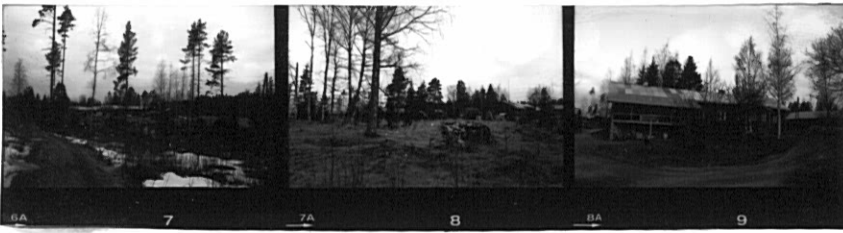
yleiskuvat idästä ja etelästä asuinrakennus
