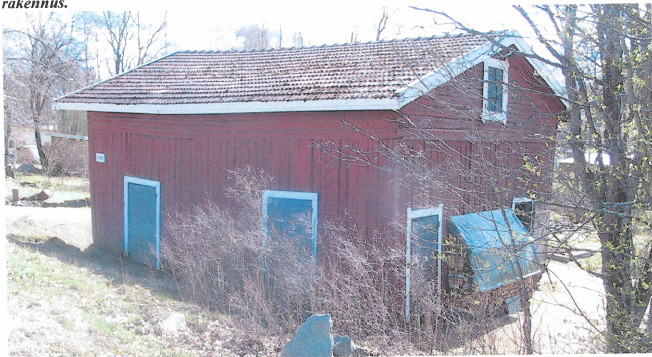
Alanko huhtikuussa 2002. Pystyhirsistä rakennettu aitta/makasiini. Entinen Immalan kaupan rakennus.
