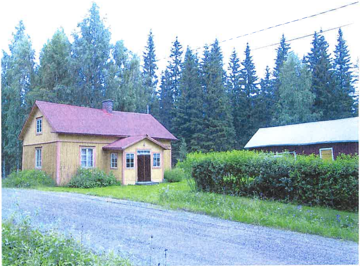
Asuinrakennus etelästä. Oik. ulkorakennus.
