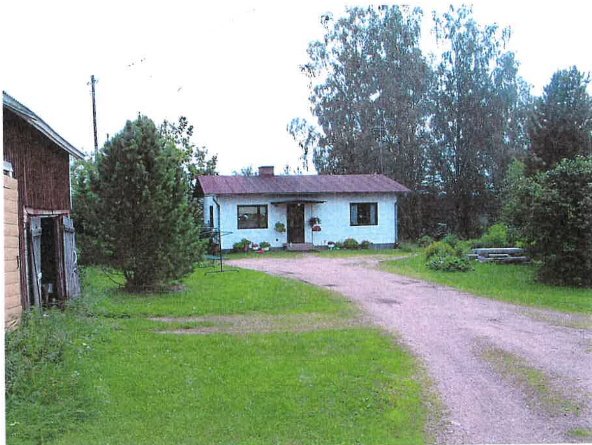
Pihapiiriä luoteesta. Vas. ulkorakennus, taustalla päärakennus.
