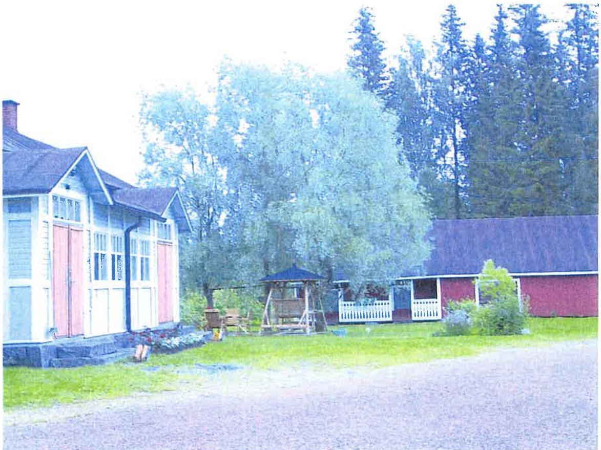
Pihapiiriä lännestä. Vas. päärakennuksen kuisti, oik. aitta ja talli.
