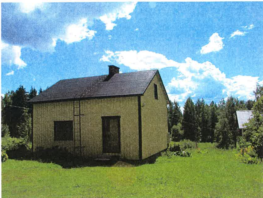
1950-luvulla rakennettu asuinrakennus pohjoisesta
