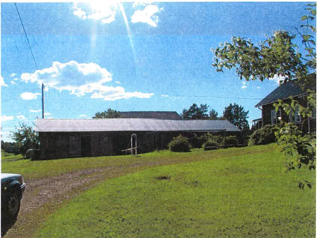
Pihapiiriä idästä. Kesk. ulkorakennus, oik. päärakennusta.
