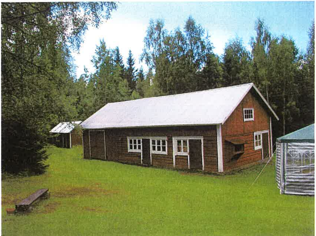
1950-luvulla rakennettu navetta
