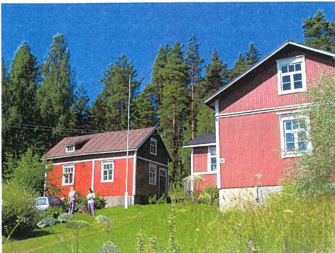
Pihapiiriä koillisesta. Vas. 1920-luvulla rakennettu asuinrakennus, oik. vuonna 1909 rakennettu asuinrakennus.
