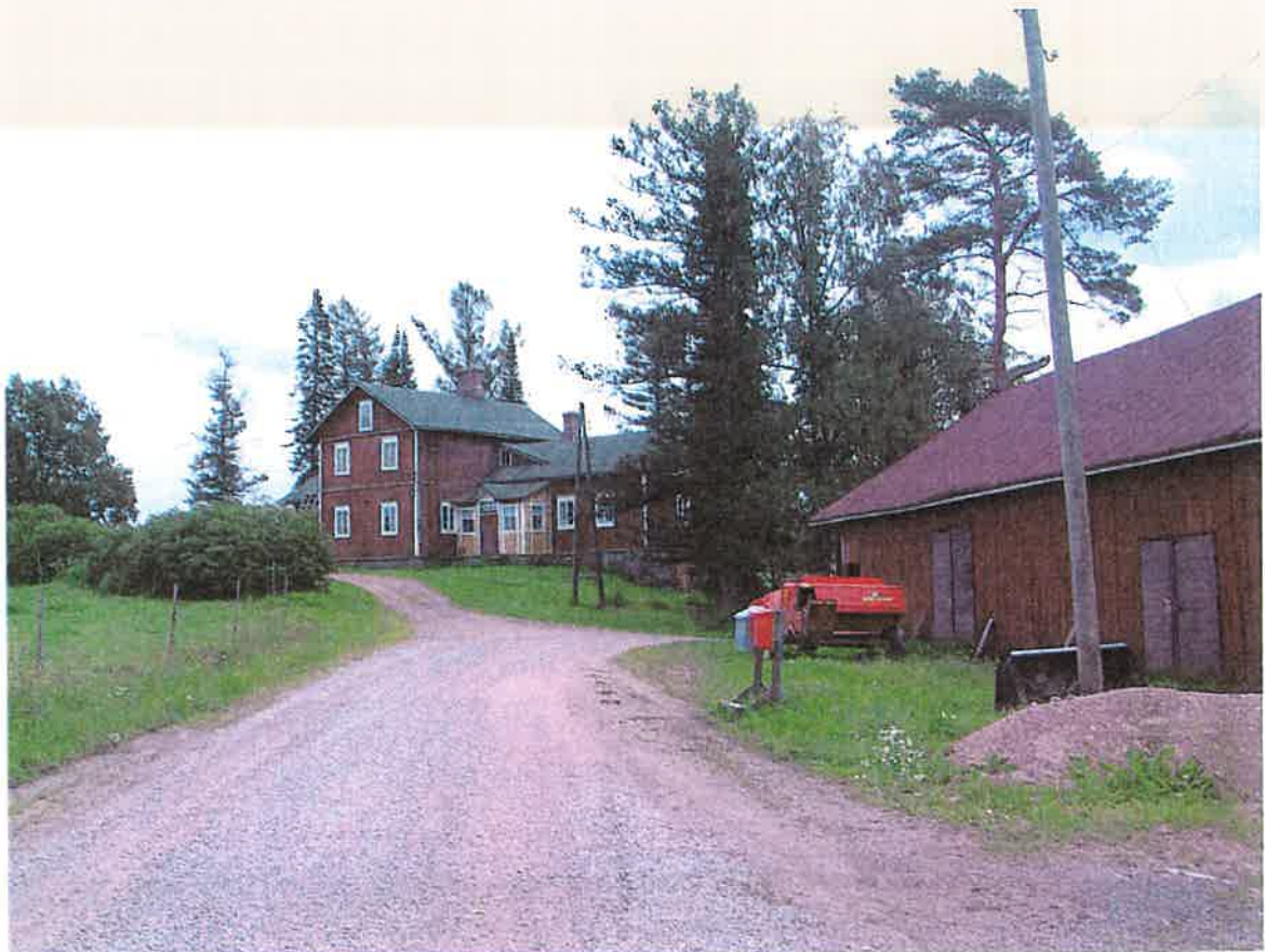
Taustalla päärakennus, oik. ulkorakennus. Kuva lännestä.
