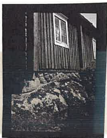
ASUINRAKENNUKSEN PERUSTUSTA LÄNNESTÄ
