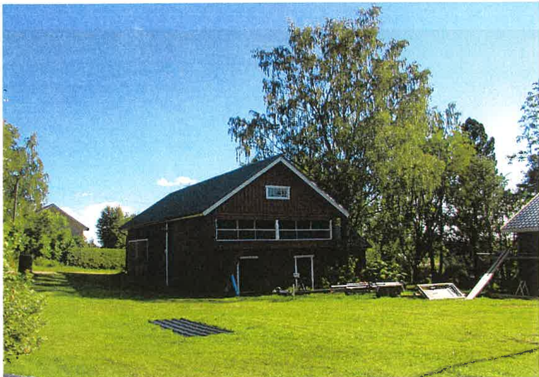
Puolirakennus etelästä. Rakennuksen pohjoispäässä autotalli.
