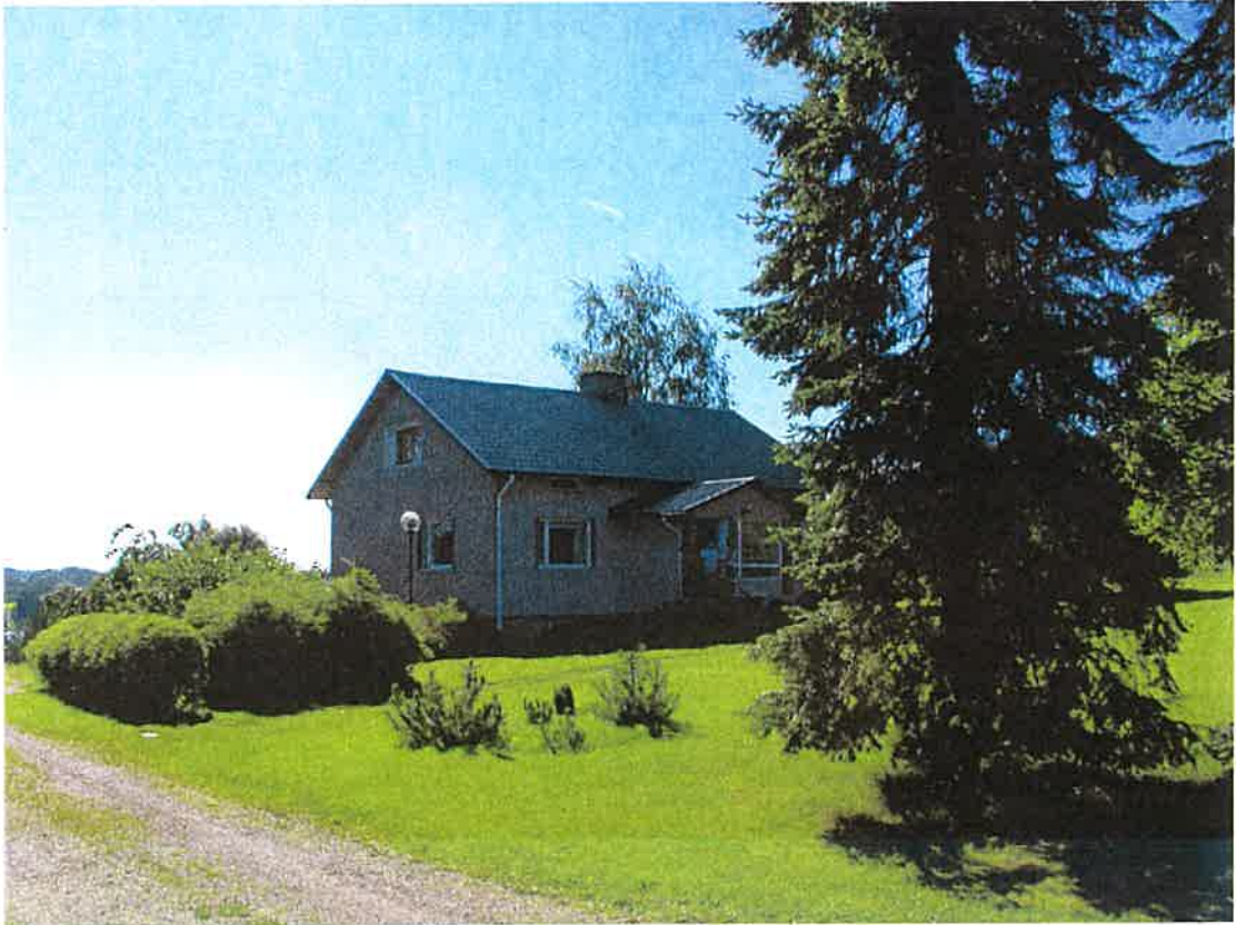
1950-luvulla rakennettu päärakennus lännestä
