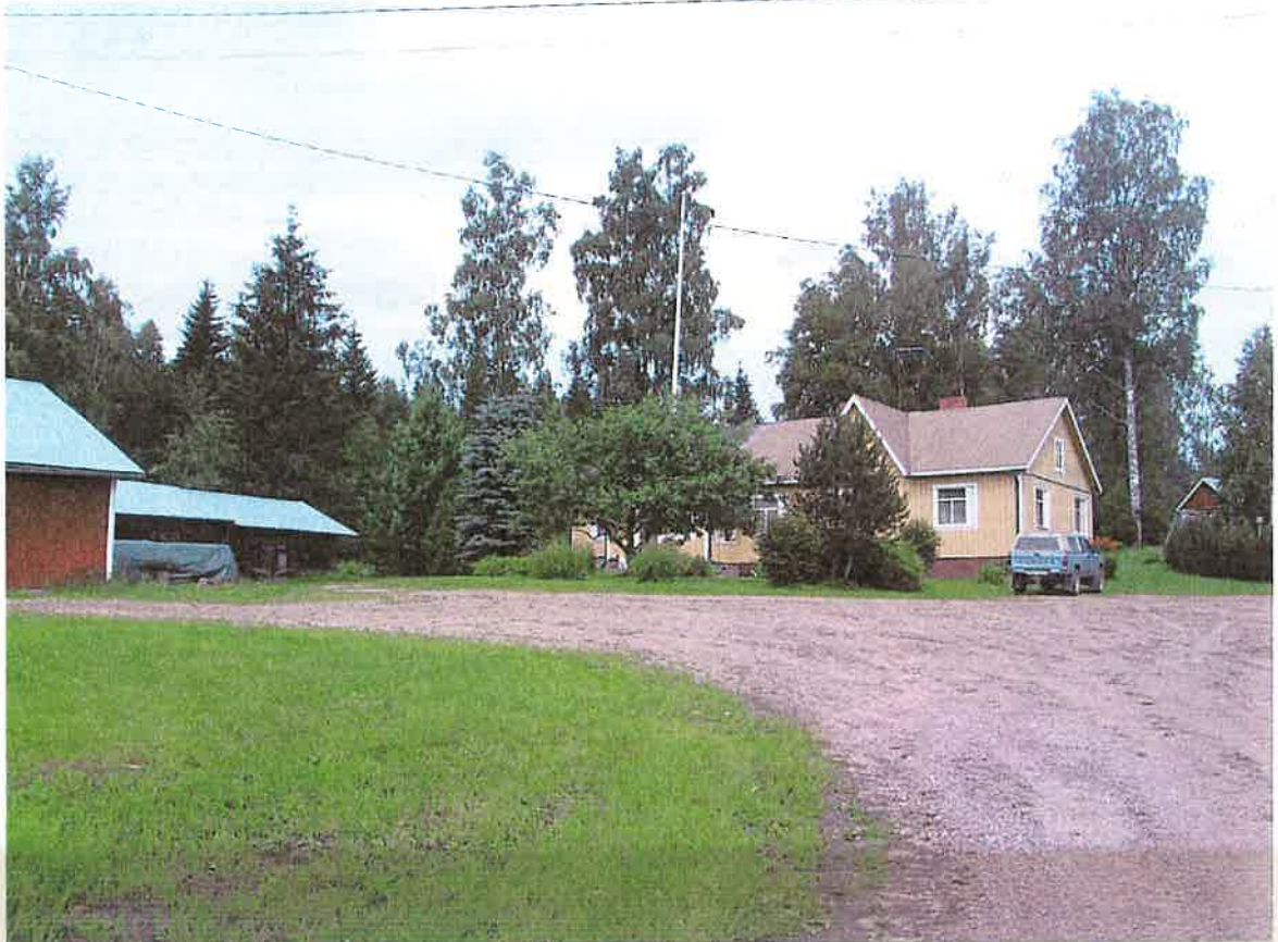
Pihapiiriä etelästä. Vas. ulkorakennuksen pääty ja riviaitta, oik. päärakennus.
