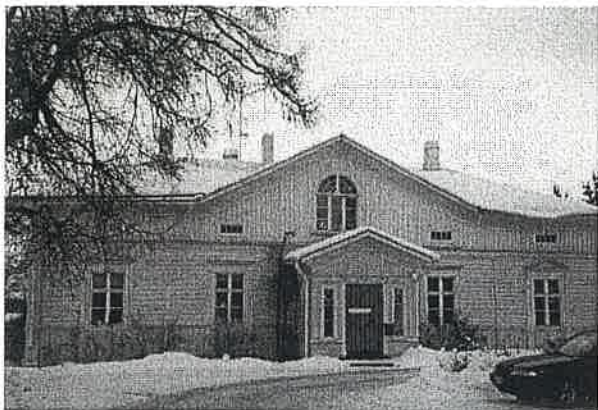
Etelän puoleinen julkisivu.
