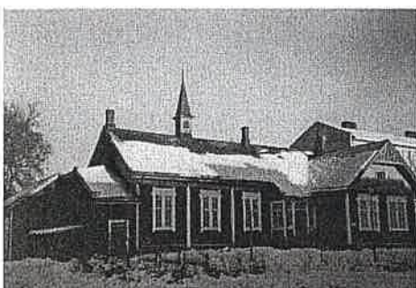
Etelän puoleinen julkisivu.
