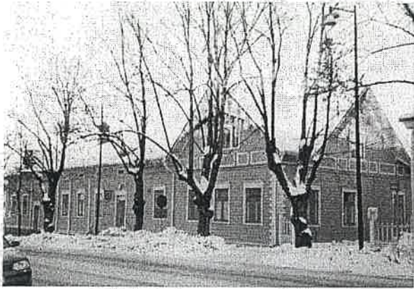
Vanhan apteekkirakennuksen eteläjulkisivu.
