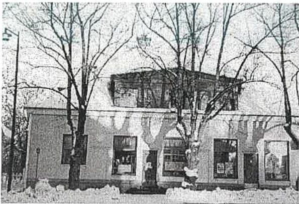
Uuden apteekkirakennuksen eteläjulkisivu.
