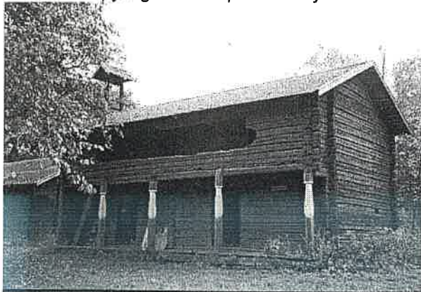
Luhtiaitan pohjoisen puoleinen julkisivu.
