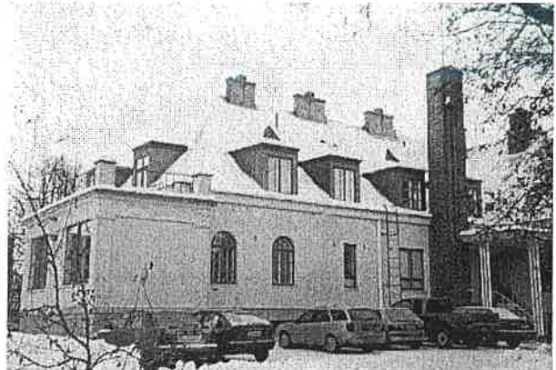
Uuden apteekkirakennuksen länsijulkisivu.
