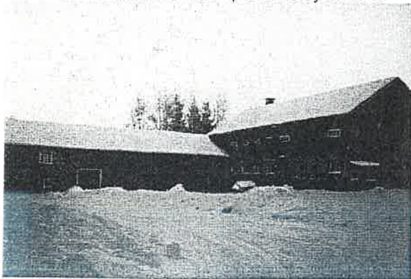
Navetta etelästä kuvattuna.
