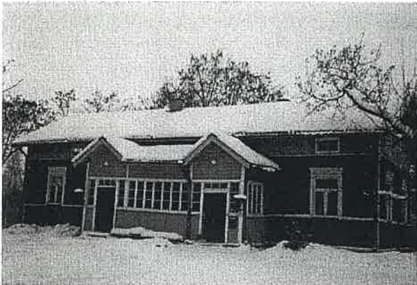
Päärakennuksen etelän puoleinen julkisivu.
