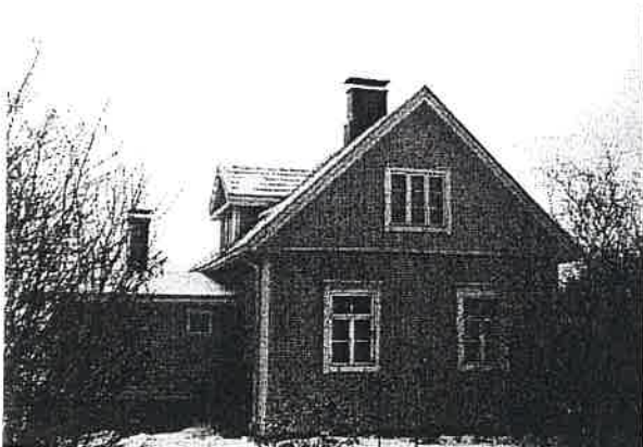
Asuinrakennus kuvattuna pohjoisesta.
