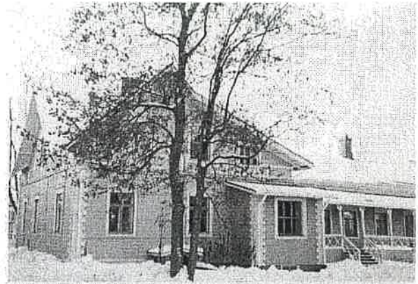
Vanhan apteekkirakennuksen pohjoisjulkisivu.
