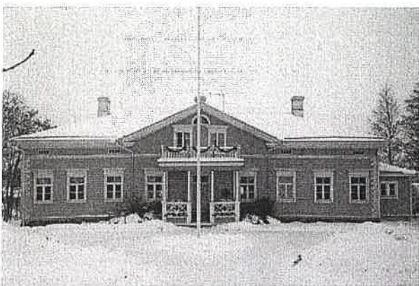
Päärakennuksen pohjoisen puoleinen julkisivu.
