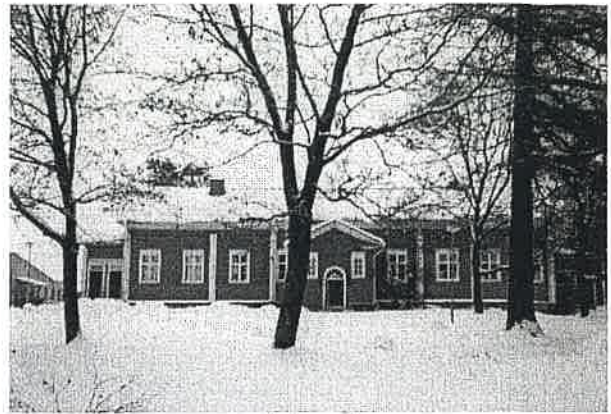
Etelän puoleinen julkisivu.
