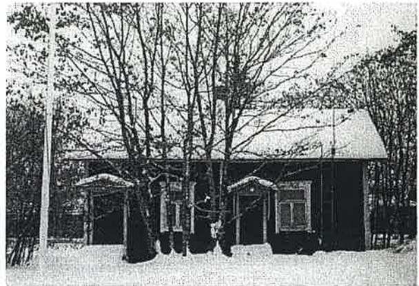
Pienen asuinrakennuksen idän puoleinen julkisivu
