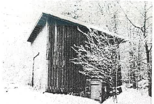
Lautarakenteinen liiteri, jonka alla kivinen bunkkeri.
