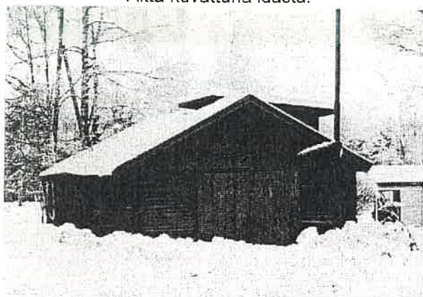
Talouksrakennus kuvattuna pohjoisesta.
