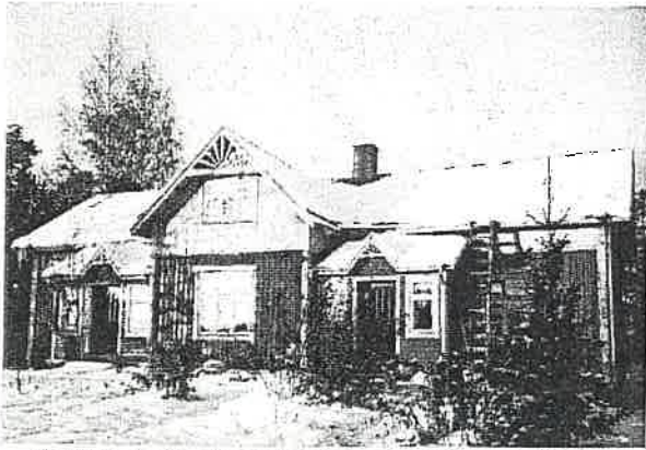
Asuinrakennuksen kaakon puoleinen julkisivu.
