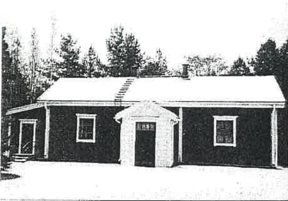
Asuinrakennus luoteesta kuvattuna.
