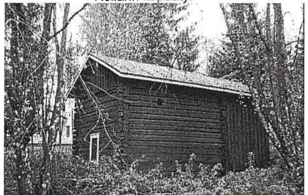
Sauna kuvattuna koillisesta.
