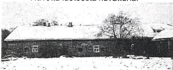
Navetta etelästä kuvattuna.
