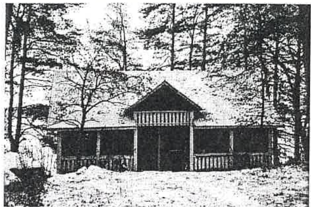
Aitta kuvattuna asuinrakennuksen kulmalta, koillisesta.
