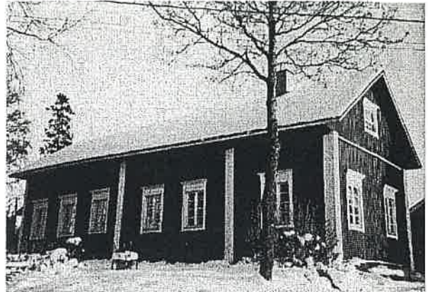
Vanhemman asuinrakennuksen luoteen puoleinen julkisivu.
