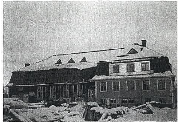
Etelän puoleinen julkisivu.
