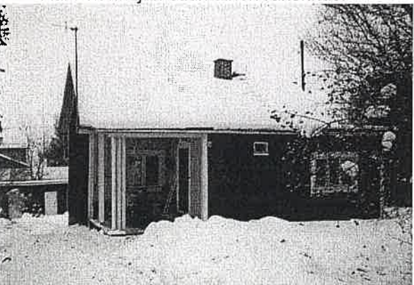
Kivisen pohjoisen puoleinen julkisivu.
