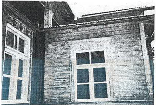
Vanhemman as.rak. kuistin pohjoisen puoleinen ikkuna.
