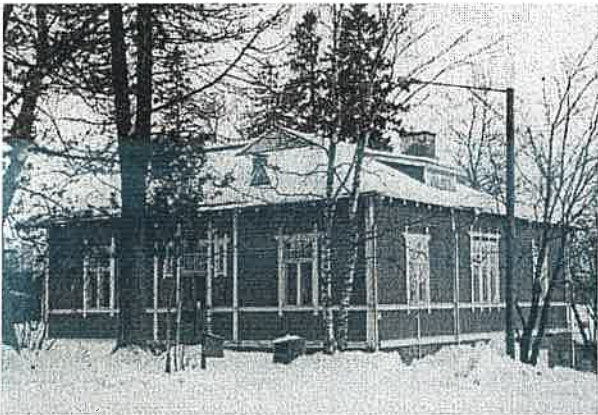
Pohjoisen ja idän puoleiset julkisivut.
