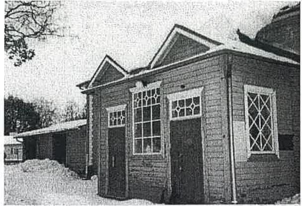
Pääjulkisivu kuvattuna luoteesta.
