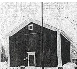
Pohjois- ja länsijulkisivu.
