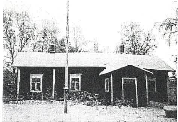
Pohjois-eteläsuuntaisen asuinrakennuksen lännen puoleinen julkisivu.
