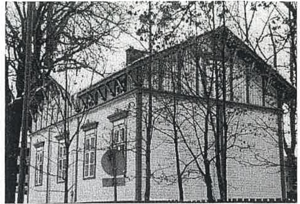
Länsipääty ja pohjoisen puoleista julkisivua
