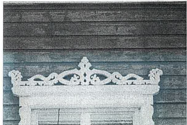
Ikkunan päällinen lehtisahakoriste.
