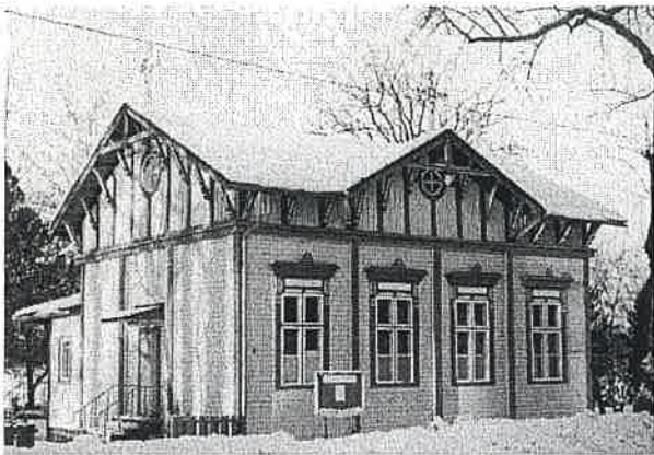
Idän ja etelän puoleiset julkisivut.
