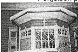
Kuistin ikkunat ja räystään profiointia.
