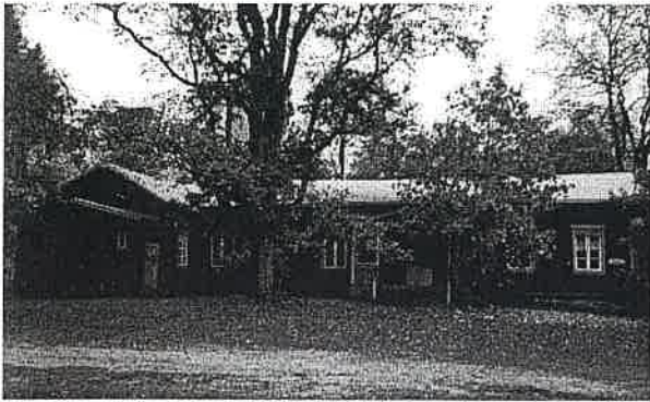
Vanhan pytingin etelän puoleinen julkisivu.
