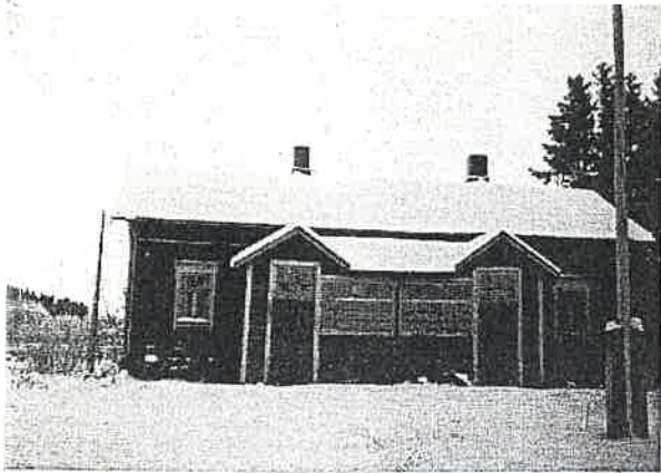
Pohjoisen puoleisen asuinrakennuksen etelän puoleinen julkisivu.
