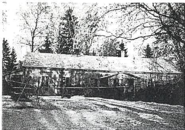
Vanhempi asuinrakennus lounaasta kuvattuna.
