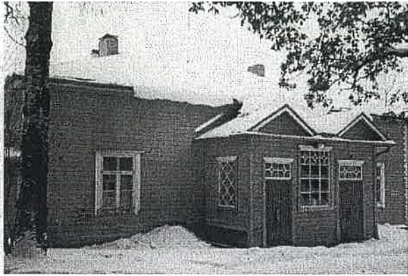
Pääjulkisivu kuvattuna koillisesta.
