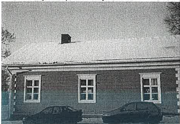
Idän puoleinen julkisivu.
