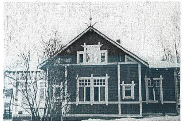
Etelän puoleinen julkisivu.
