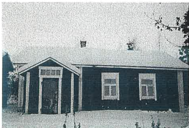
Asuinrakennuksen kaakon puoleinen julkisivu.
