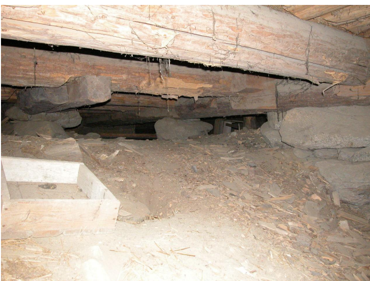
Päärakennuksen perustus on tehty perinteisesti luonnonkivipilareiden varaan.
