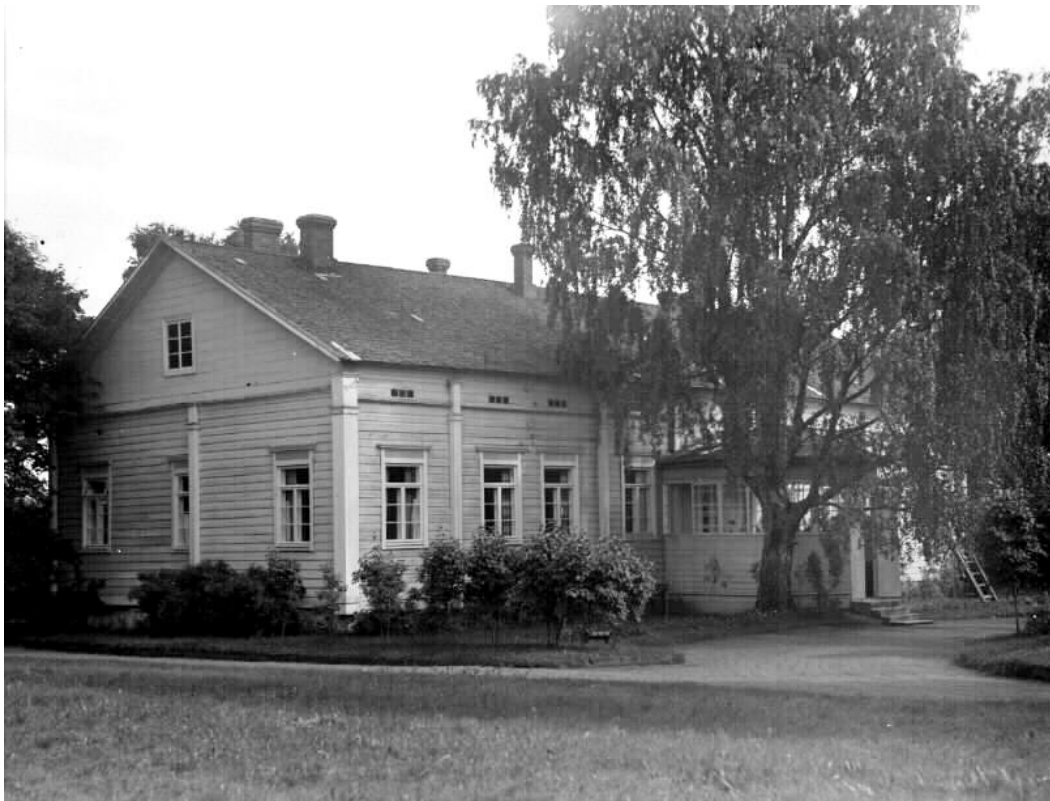
Raholan tilan päärakennus vuonna 1935. Rakennus on edelleen pääpiirteissään samassa asussa. Kuva: Tampereen museot / Kuva-arkisto
