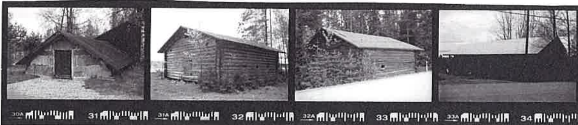
PÄÄ RAK. LUOTEIS- PUOLELLA SIJAITSEVA MAAKELLARI
