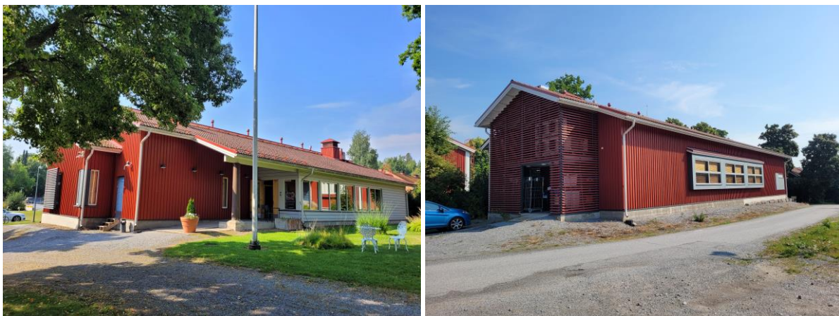
Kuva 53 Uusi talli sisäpihalta (vasemmalla) ja parkkipaikalta nähtynä (oikealla).
