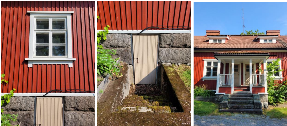
Kuva 45 Rakennuksen detaljeja: kuusiruutuinen ikkuna (vasemmalla), kellarin ovi (keskellä) ja pääsisäänkäynti (oikealla).
