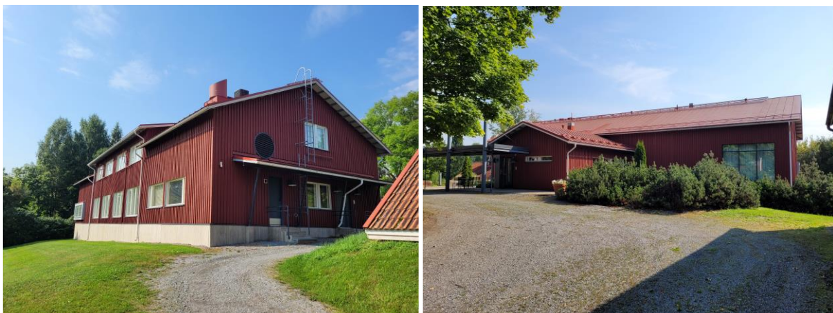
Kuva 51 Rakennus lähestyttäessä sitä päärakennukselta (vasemmalla) ja sisäpihan puolelta (oikealla).
