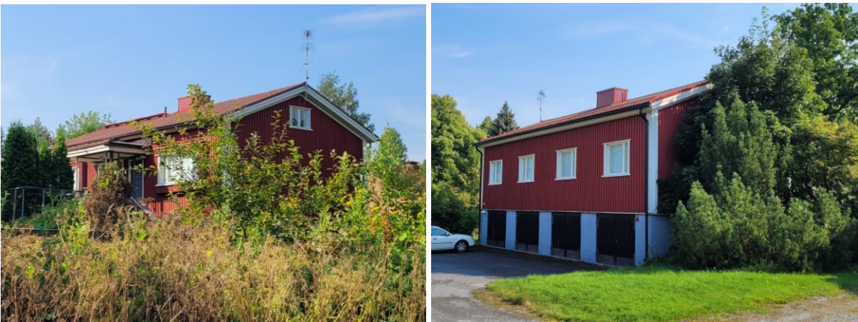
Kuva 55 Rakennus on osittain pihapiirin kasvillisuuden peitossa (vasemmalla). Alaosassa on useampi autotalli (oikealla).
