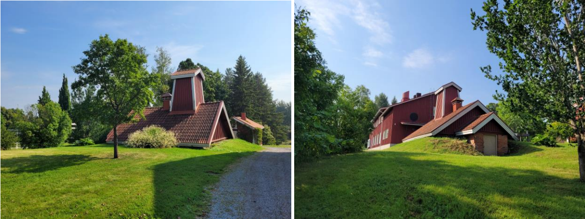
Kuva 48 Kellarirakennuksen katto talouspihalta katsottuna (vasemmalla) ja sisäänkäynti kellarin päärakennukselta lähestyttäessä (oikealla).
