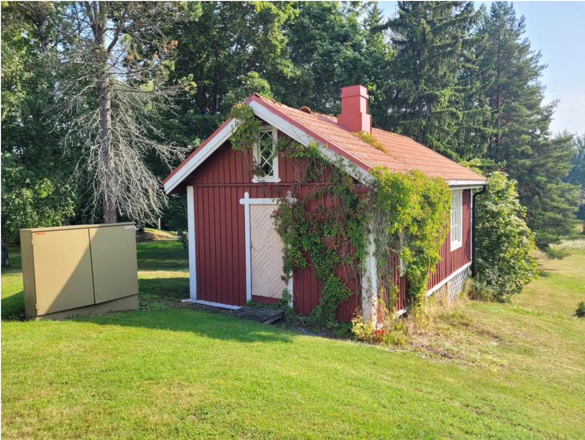
Kuva 46 Mankelirakennuksen sisäänkäyntipääty, jonka takana kulkee kuusiaita.
