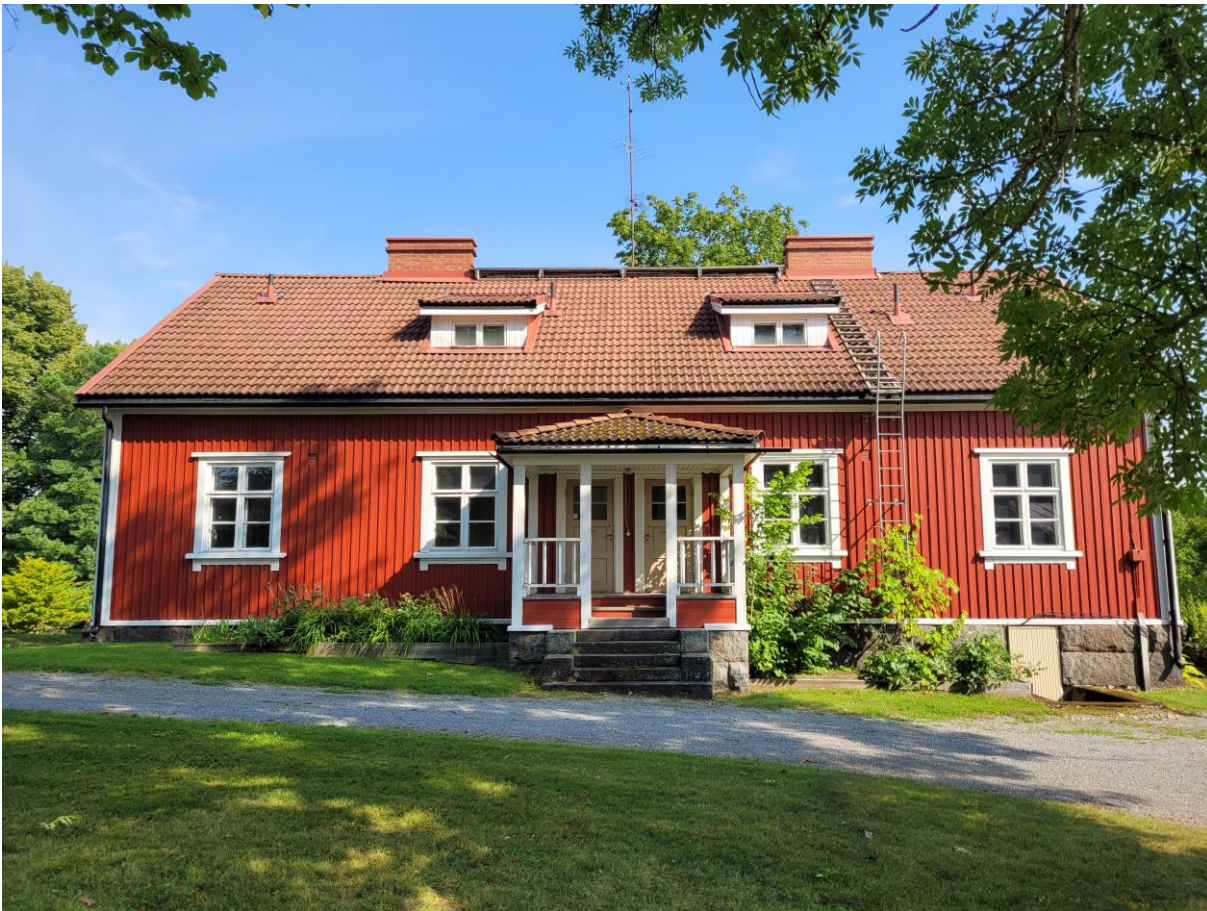
Kuva 43 Vanha työläisten asunnon sisäänkäynti tapahtuu sisäpihalta pienen avokuistin kautta.
