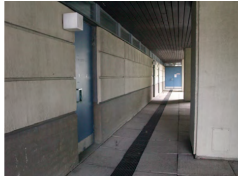
Koillissiiven tiloihin johtavat ovet
