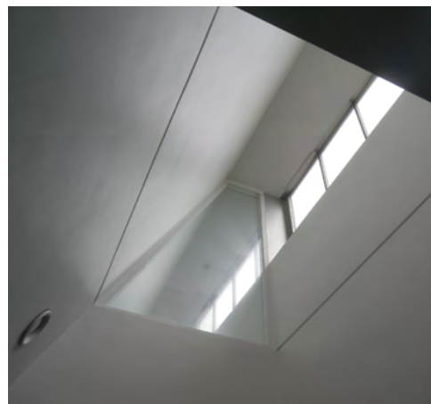
Ikkunoita toimistotilojen katonrajassa
