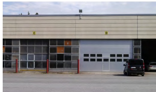
Länsijulkisivun alkuperäisiä ovia ja uusi nosto-ovi
