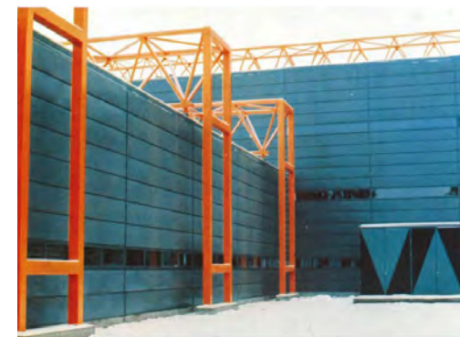
Valion Vaaralan tehdas Vantaalla. Kuva: Arkkitehti-lehti 2/1973, s. 29.
