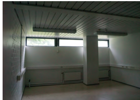
Koillissiiven tiloihin johtavat ovet
