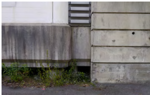
Alkuperäisen ja laajennuksen yhtymäkohta
