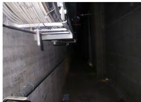
Kylmävaraston ja ulkoseinän välinen käytävä
