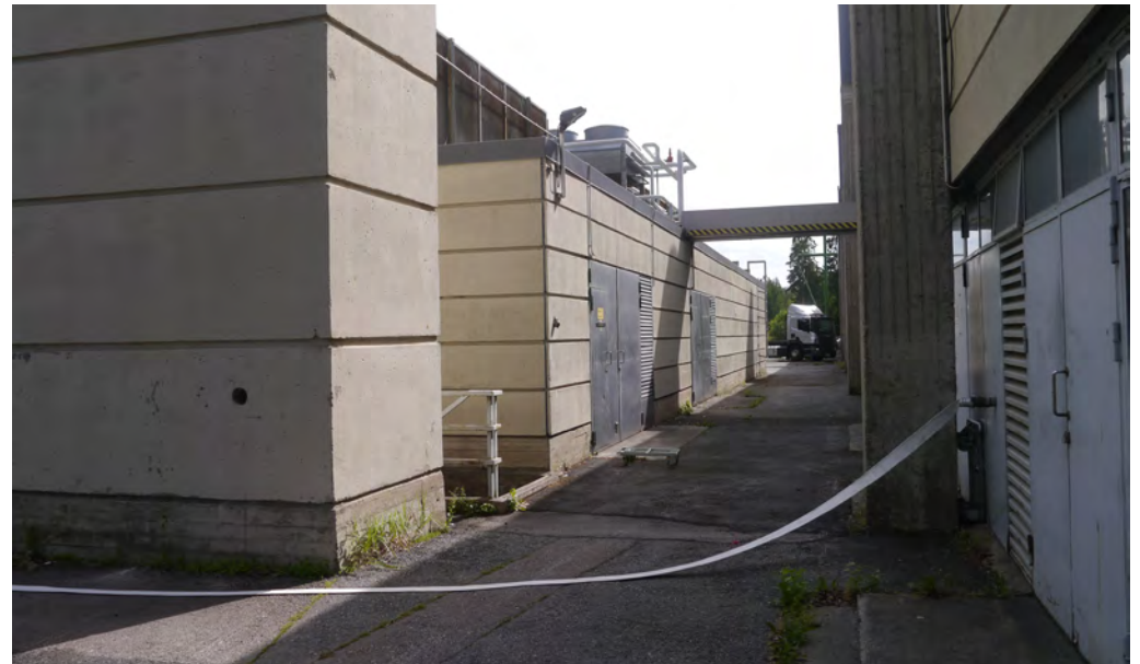
Varaston ja konttori- ja varastorakennuksen välinen tila
