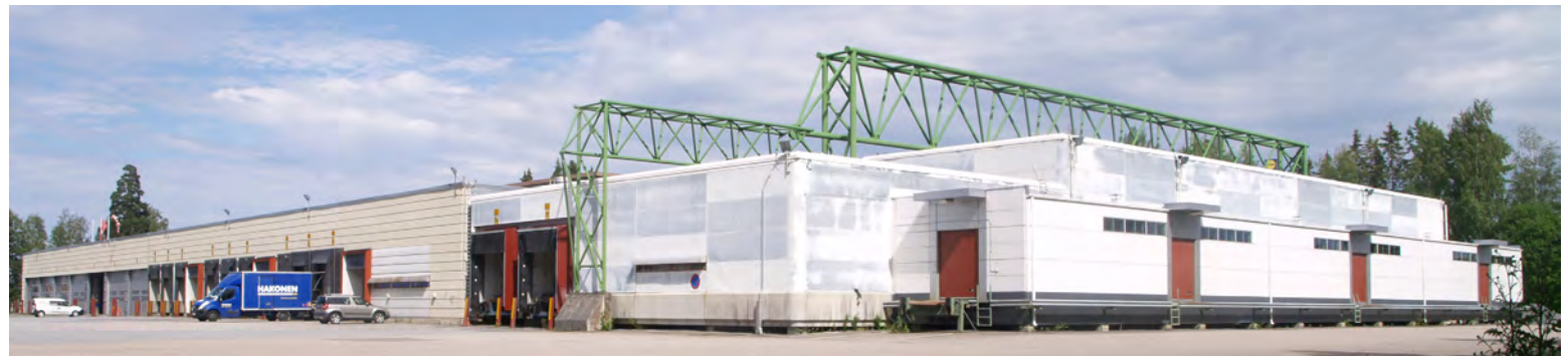
Rakennus lounaasta. Etualalla vuosina 1980 ja 1998 tehdyt laajennusosat.
