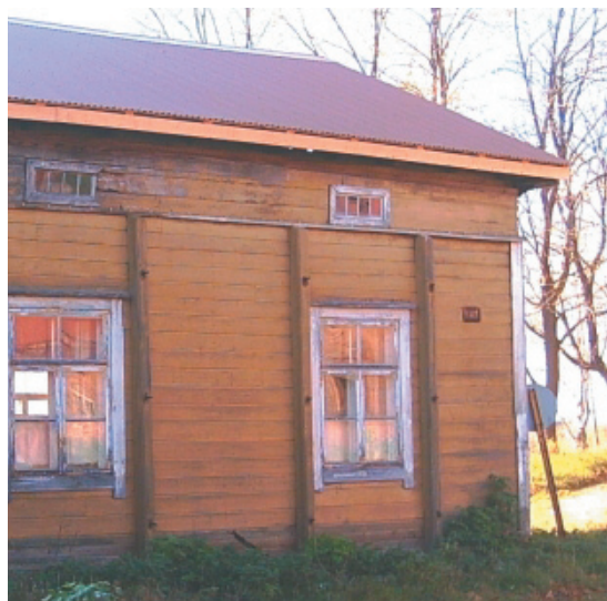
Päärakennuksen pirttipääty följareineen. Matala kivistä tuskin näkyy maanpinnan yläpuolella. Kattoa suojaa väliaikainen aaltopeltikate.
