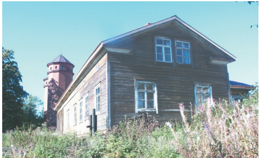
Niemen päärakennus kaakosta, taustalla Navetan tornit.
