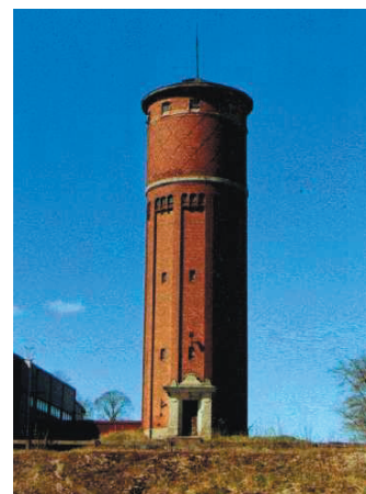
Lielahden tehtaiden vesitorni. (Valokuva: Kantonen 1999)
