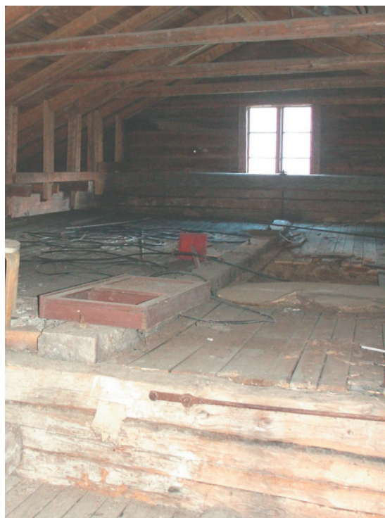
Pirtin yläpuolinen ullakotila. Korotetun yläpohjan keskellä kulkee haltijahirsi.
