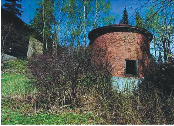
Rehusiilo myllyn itäpuolella. Kuvan vasemmassa reunassa näkyy osa myllyrakennuksen pohjoispäähän liittyvästä lautarakenteisesta siilo- ja varistorakennuksesta. (Valokuva: Kantonen, 1999)
