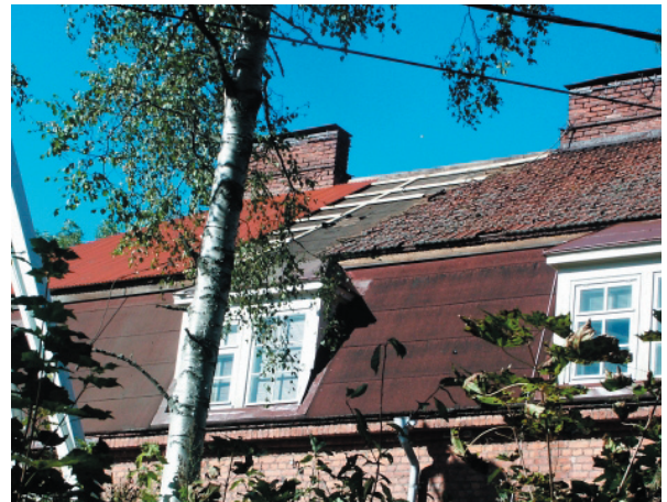
Rakennuksen nro B30 vanhoja kattotiliä vaihdetaan peltikatteeseen vuoden 2005 syksyllä.
