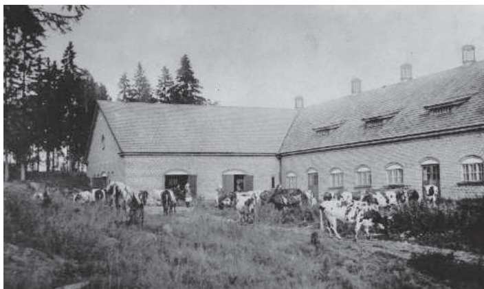
Lehmiä Federleyn suunnitteleman navettarakennuksen karjapihalla. (Kantonen, 1999–2000 → M-Realin Lielahden tehtaiden arkisto)
