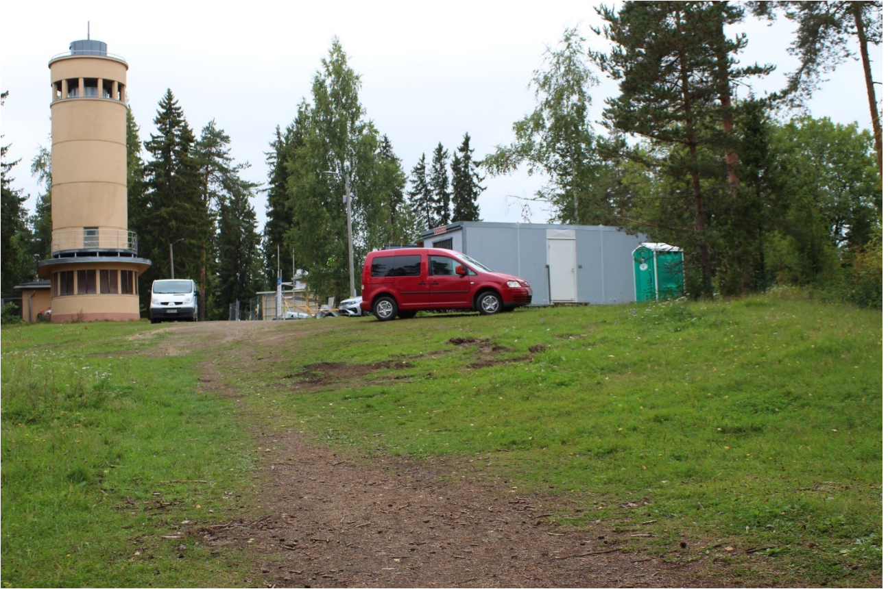
Kirkkoharjun työmaa tarkastushetkellä. KY 375:70
