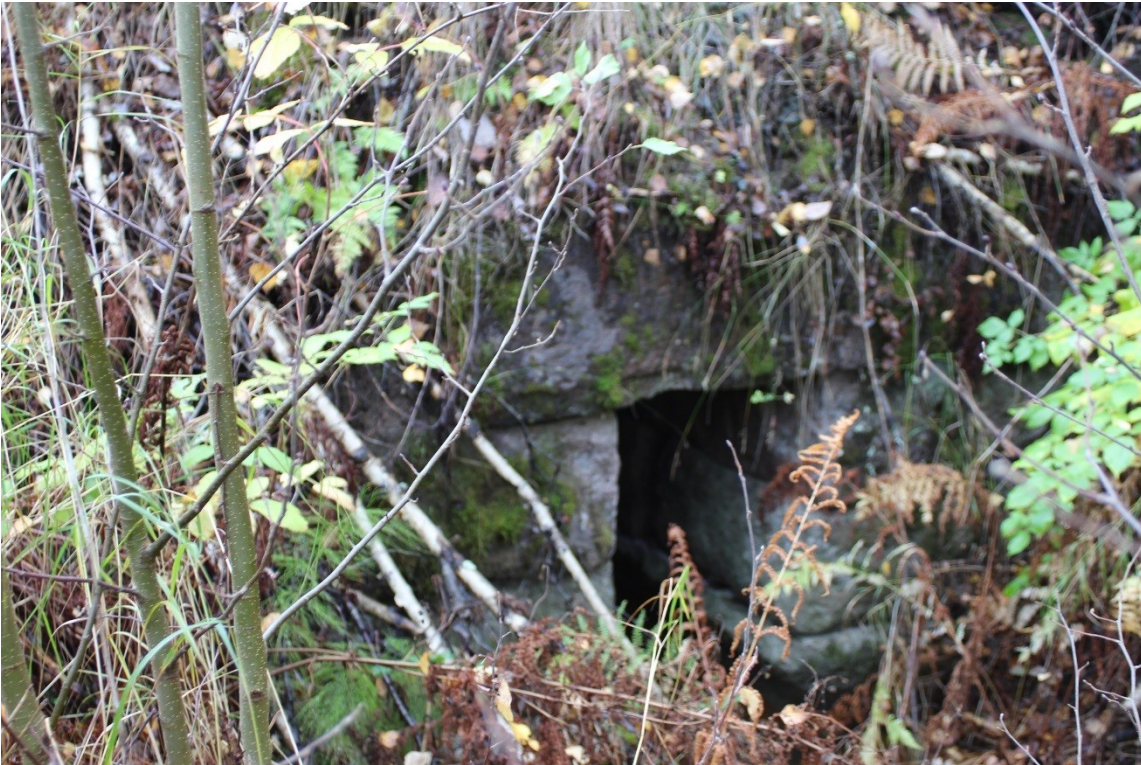
Sillan rakenteet etelään. KY 375:118
