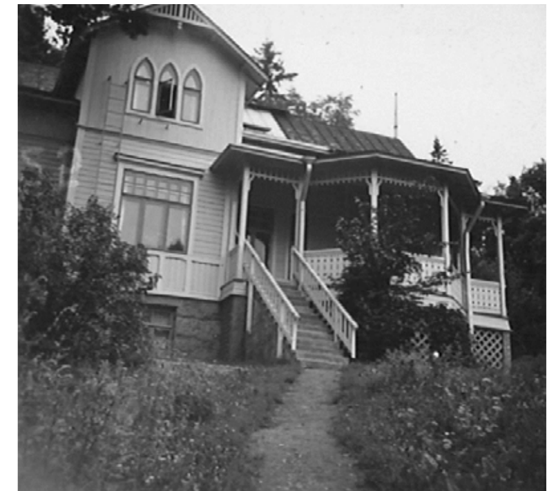
Uramonkatu 9 1950-luvun alussa. Poikkipäädystyyn on lisätty palotikkaat ja betoniportaaseen puukaide. Ikkunoiden karmit ja puitteet ovat nykyistä tummemmat, julkisivun nurkkalaudat ja koristelustoitukset ovat julkisivulaudoitusta vaaleammat. TKA.
