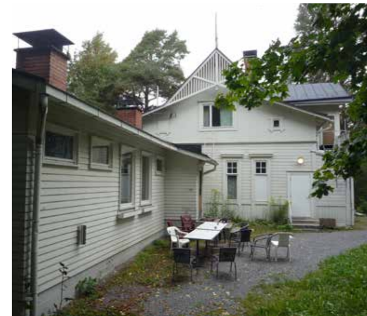
Näkymä kaakosta katsottuna. Etualalla laajennus, taustalla huvilarakennus.
