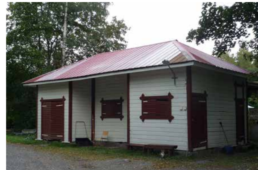
Vanha piharakennus, jossa on varastotiloja ja ulkokäymälät. Osa rakennuksen julkisivulaudoituksesta sekä vesikate on uusittu, muut osat ovat alkuperäisiä. Aikakauden tyylistä poikkeavat tummat korosteosat on maalattu 2000-luvulla.
