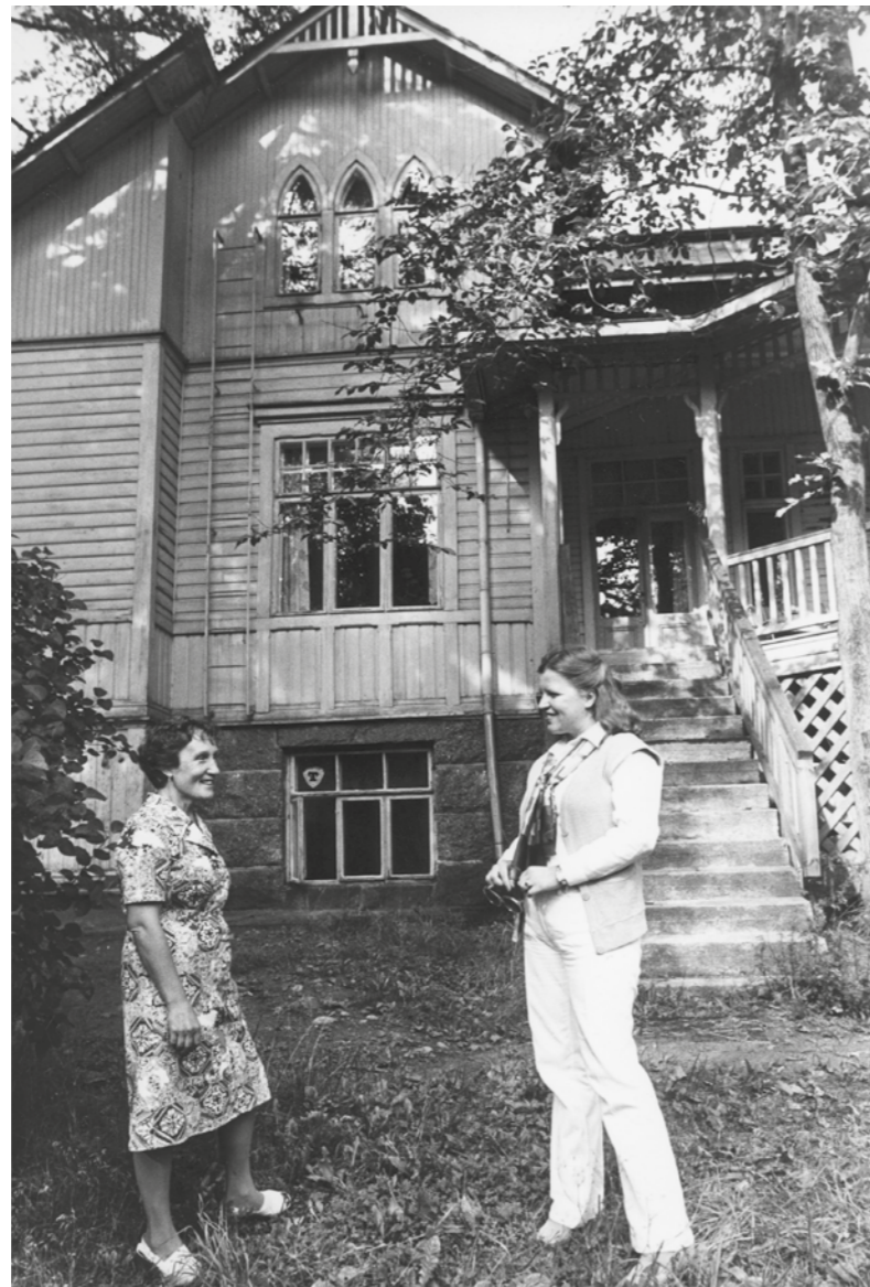
"Kaksi naista suojakodin pihamaalla 1980-luvulla". Vasemmalla rakennuksen nurkkaan 1950-luvulla toteutettu laajennus (liukurata). Vanha verannan pitsikaide on korvattu yksinkertaisella puukaiteella ja portti purettu. Kuvaaja Veikko Seppänen. TW.
