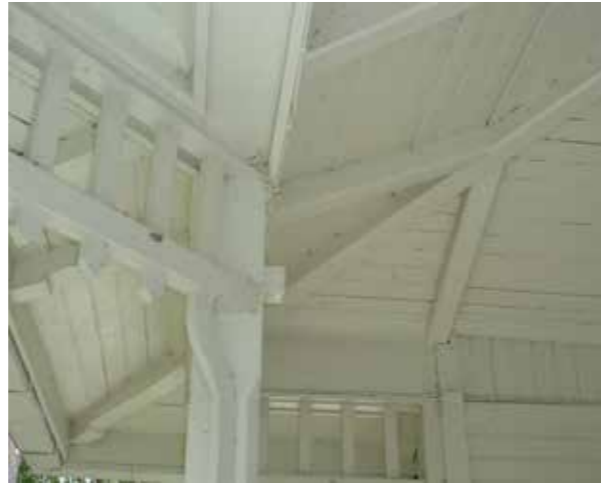
Verannan puurakenteisia kattorakenteita.
