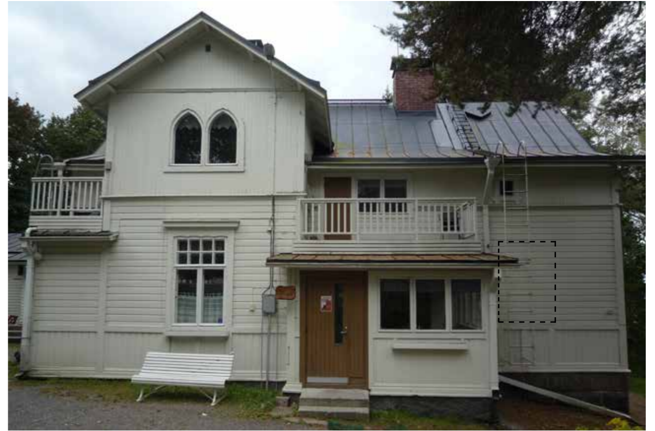
Julkisivu koilliseen. Katkoviivalla esitetty oletettu vanha ikkunan paikka. Tähän viittaavat rintapaneelin pystysuorat koristeosat ja ulkoverhouslautojen pystysaumamat.
