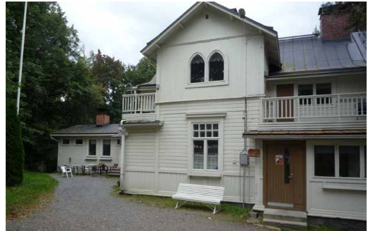
Näkymä pohjoisesta katsottuna. Etualalla päärakennus, taustalla laajennuksen pääty.
