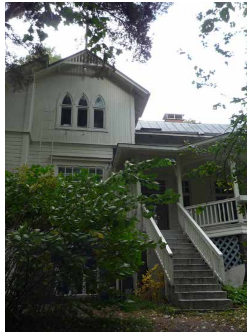
Päärakennuksen poikkipäätty ja kuistin portaat lounaasta katsotuna.
