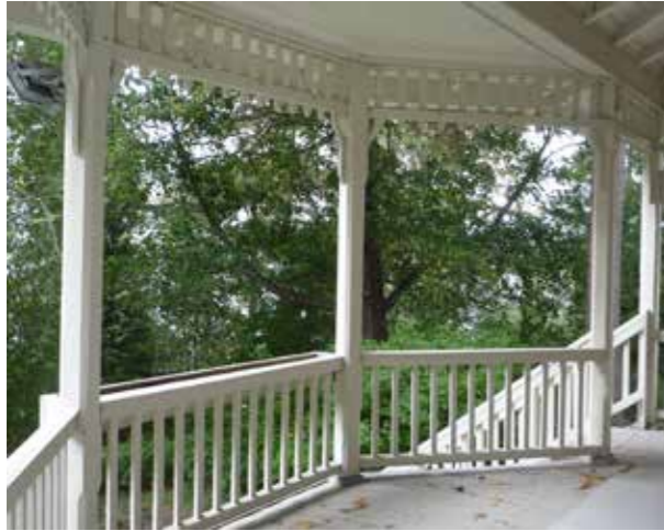
Näkymä verannalta Pyhäjärvelle. Käiteen puurakenteet on uusittu, yläosan koristeaihe on todennäköisesti alkuperäinen.
