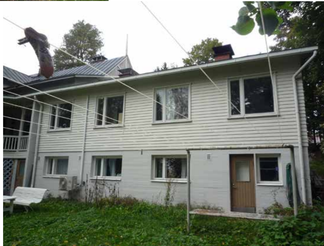
Laajennus lounaasta katsottuna.
