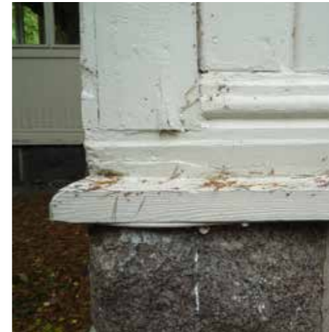
Kivirakenteisen sokkelin ja julkisivulaudoituksen liittymä.
