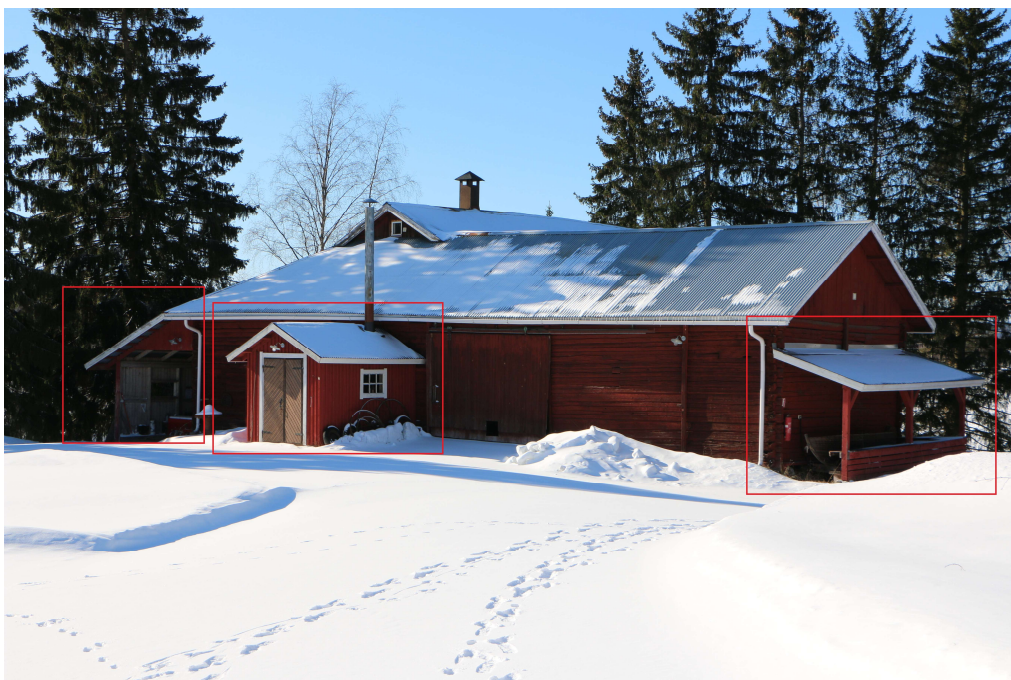
KUVA 17. Vanhat kuuset ympäröivät riihirakennusta. Oikealla näkyy Perinneriihipäivää varten rakennettu lätyn- ja makkaranpaistokatos. Etuseinälle rakennetun lisäsiiven takana on kuivaushuone ja 2010 muurattu uuni. Myöhemmin rakennetut lisäsiivet rajattu kuvaan punaisella. (I. Peltomäki)
