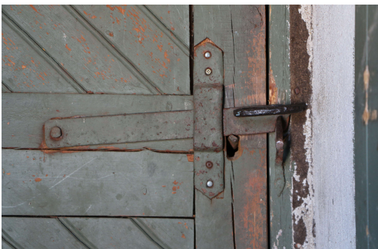
KUVA 10. Navettarakennuksen oven vanhanmallinen takorautainen salpa. Navettarakennuksessa ovat säilyneet melkein kaikki alkuperäiset sisäovet. Ulko-ovia on jouduttu korjaamaan lahovaurioiden vuoksi. (I. Peltomäki)
