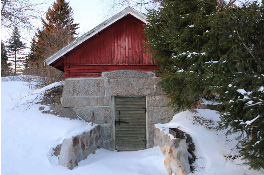
KUVA 15. Maakellarin sisäänkäynti. Ovessa on samaa vihreää maalia ja sama salpatyyppi kuin navettarakennuksessa. (I. Peltomäki)
