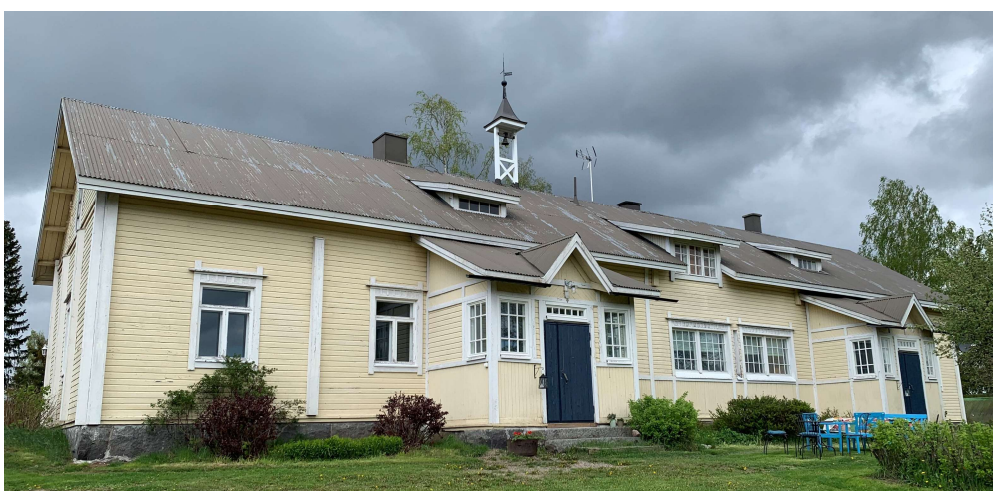
KUVA 58. Rakennuksen eteläjulkisivu tällä hetkellä. (I. Peltomäki)
