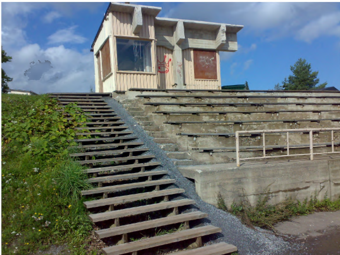
Kuva 18: Vanha katsomo ennen purkamista
