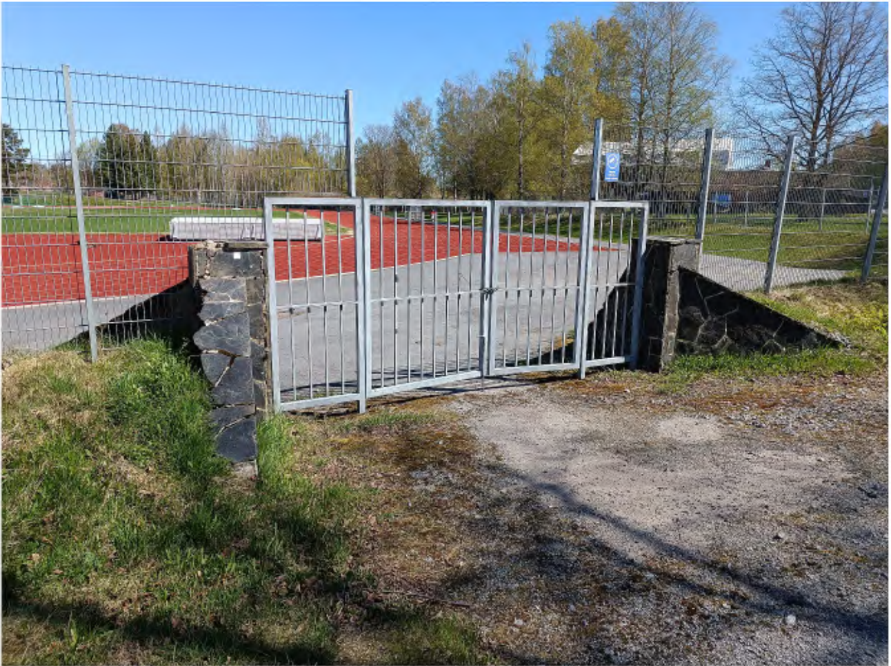
Kuva 21: Portti ja sen liuske kivillä päällystetyt vanhempaa tekoa olevat tukimuurit urheilukentän etelälaidalla.
