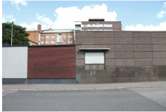
Pinninkadun katuseinä korttelin 259 kohdalla. Kuvan keskellä entinen grillikioski.
