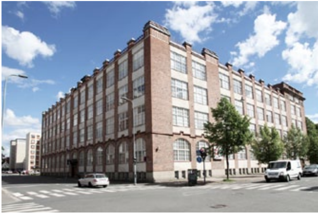
Aaltosentehdas (Lambert Petterson 1913-16, 1926, Jaakko Tähtinen 1951) on valittu arvokkaaksi rakennuskulttuurikohteeksi Tammelassa. Rakennus on muutettu asuinkäyttöön.
