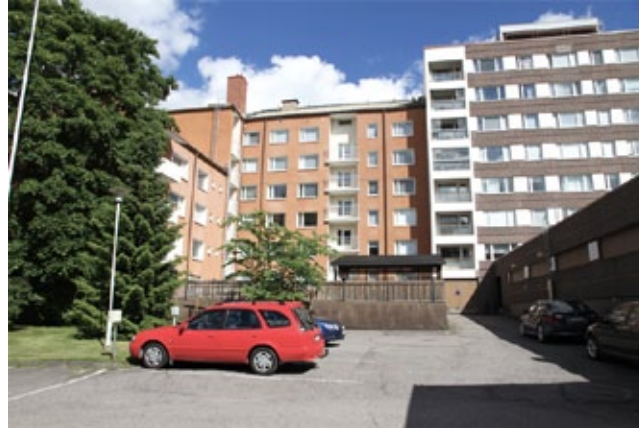
Autopiha ja oleskelupiha on jäsennetty päällysteillä. Jalankulku- ja ajoreittejä ei ole eroteltu eikä korttelipihaalla ole nykymääräysten mukaista leikkipaikkaa. Oleskelupiha on pieni eikä vaikuta käyttöasteeltaan suurelta.
