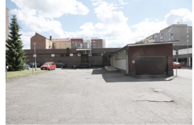
As Oy Tammelan puistokatu 20:n liiketilojen huolto- ja lastaussillat sijaitsevat takapihalla. Oikealla katettu autohallin ajoluiska.
